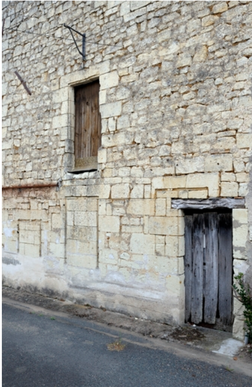
Hôpital, aile est. Détail des remaniements de maçonneries, avec obturation et reprise des baies.
