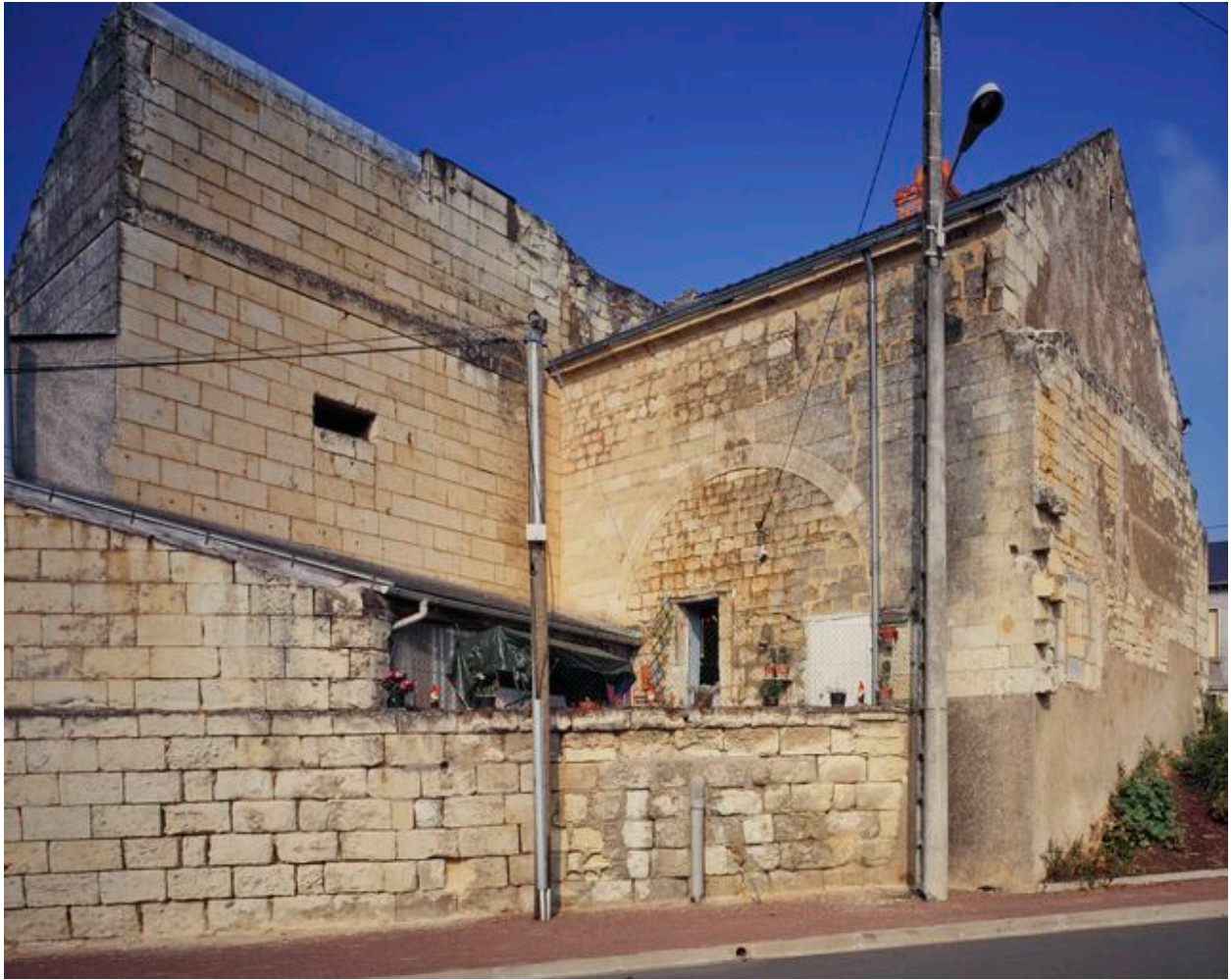
Vestiges de la façade sud de l'ancien Gros pavillon, en 1996.
