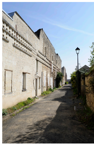
Hôpital, aile est. Détails : baies hautes alignées, jambes scandant le haut du gouttereau, pigeonniers, portes en plein-cintre à rouleau épais, nombreux remaniements. Phot. Bruno Rousseau, Phot. Youenn Communeau IVR52_20114900789NUCA
