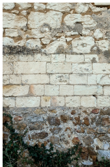
Hôpital, aile nord (rue des Moulins). Détail de la maçonnerie : moellons de perrons, petit appareil de tuffeau, moellons de tuffeau. Phot. Bruno Rousseau IVR52_20124901682NUCA
