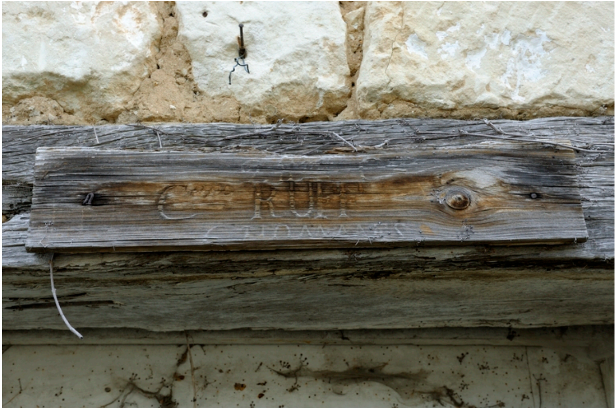
Hôpital, aile est. Détail du linteau, avec cartouche du XIXe siècle indiquant le casernement de 6 hommes du capitaine Ruff.
