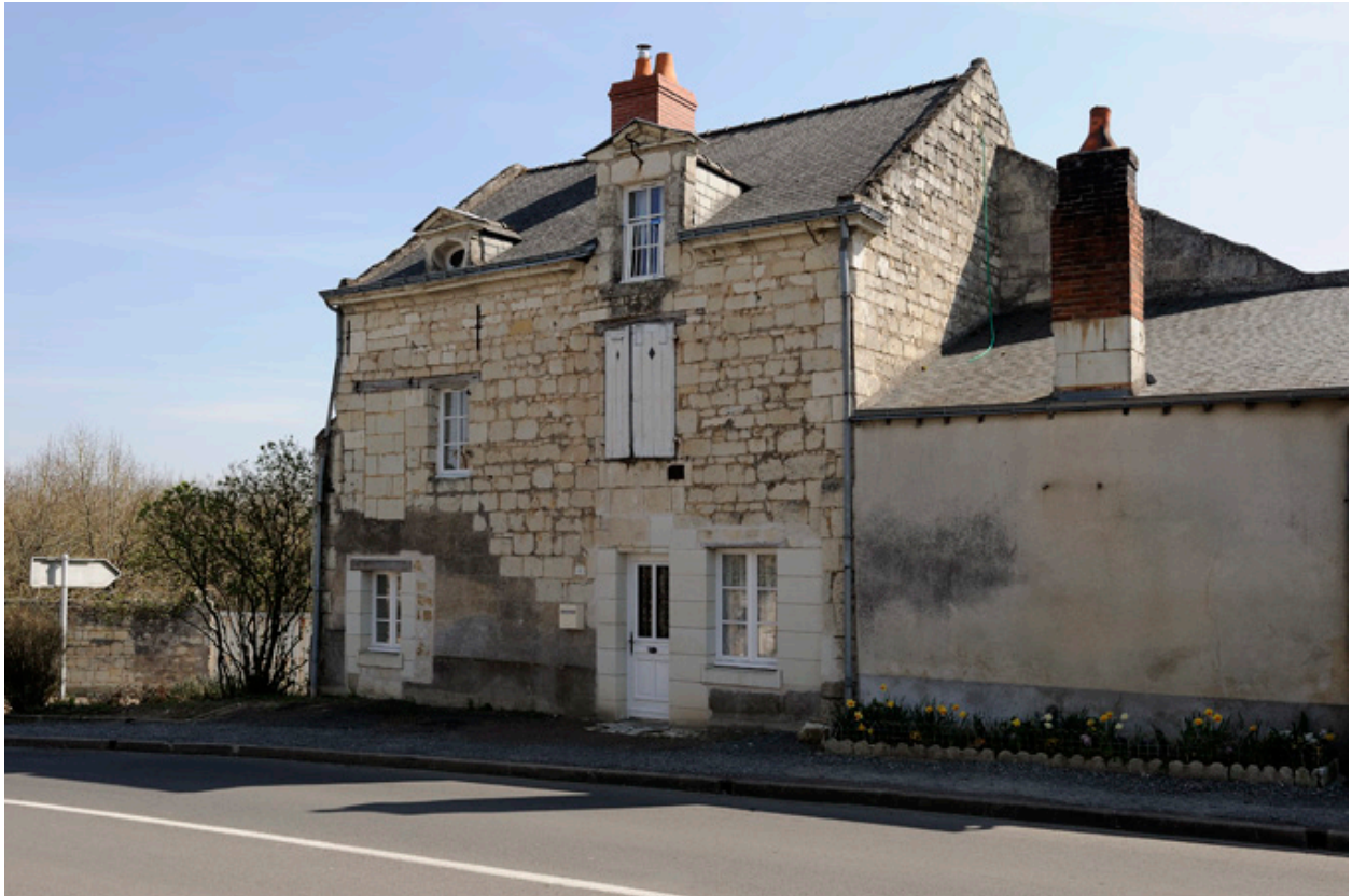
Gros pavillon : actuelle façade principale au 1, rue de la Corderie (remaniements début et fin XVIIIe siècle, puis XIXe siècles).
