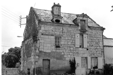
Vue générale de la maison conservant en élévation des vestiges du Gros pavillon, en 1979. Phot. Dominique Eraud IVR52_1979490222Z
