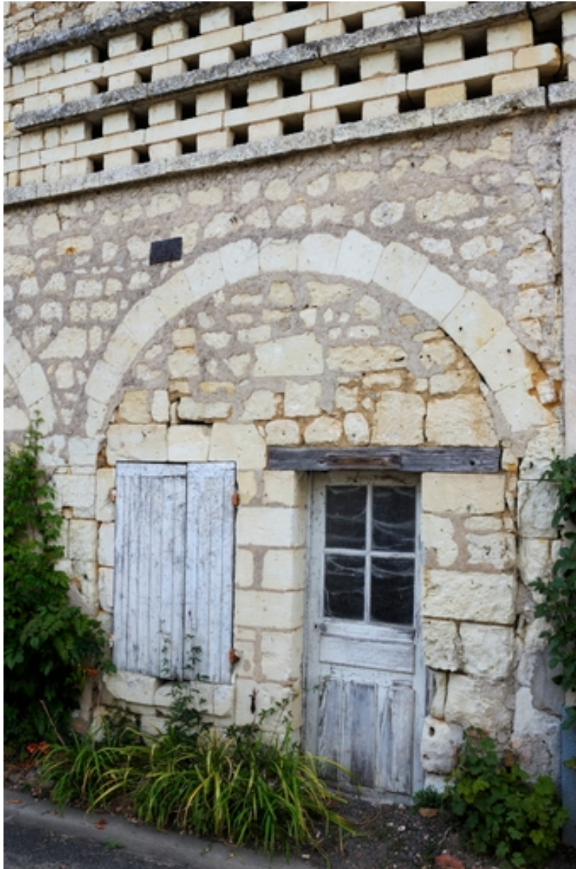
Hôpital, aile est. Remaniements des parties basses de l'élévation ; portes couvertes d'un arc à rouleau fin (anciennes écuries).
