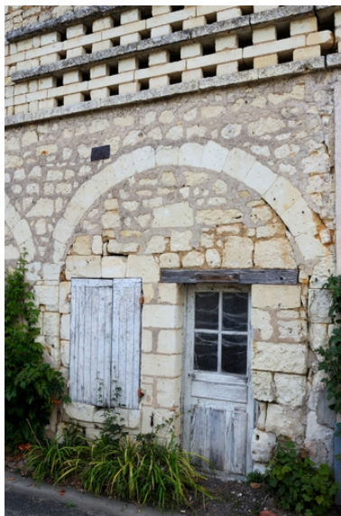
Hôpital, aile est. Remaniements des parties basses de l'élévation ; portes couvertes d'un arc à rouleau fin (anciennes écuries). Phot. Bruno Rousseau IVR52_20124901684NUCA
