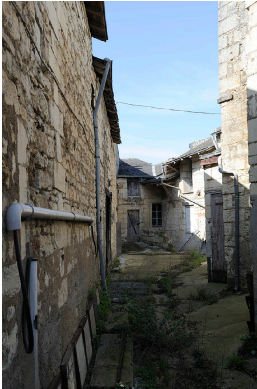
Hôpital, aile est : façade est (à gauche), avec soubassements remaniés en dépendances des bâtiments voisins.
