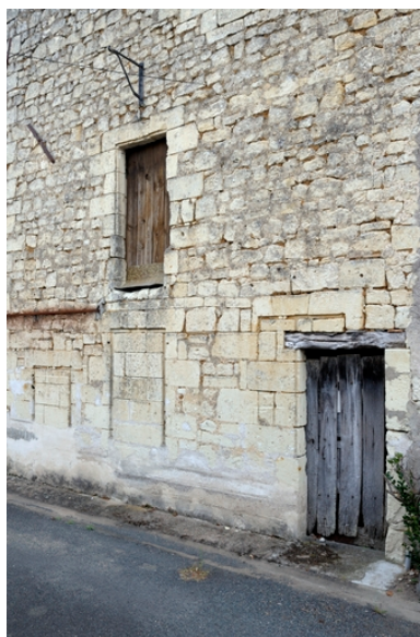
Hôpital, aile est. Détail des remaniements de maçonneries, avec obturation et reprise des baies. Phot. Bruno Rousseau IVR52_20124901686NUCA
