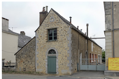
Vue depuis la rue au sud-ouest. Phot. François Lasa IVR52_20075302159NUCA
