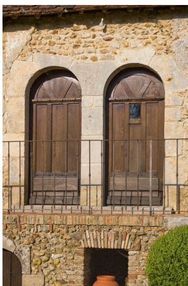
Logis : portes jumelles de l'élévation postérieure du corps principal. Phot. Yves Guillotin IVR52_20117200584NUCA
