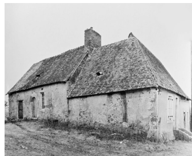
Vue du logis depuis le sud-ouest : état vers 1979. Repro. Yves Guillotin IVR52_20117200577NUCA
