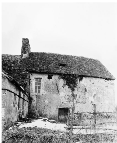
Logis, élévation postérieure du corps principal : état vers 1979. Repro. Yves Guillotin IVR52_20117200581NUCA
