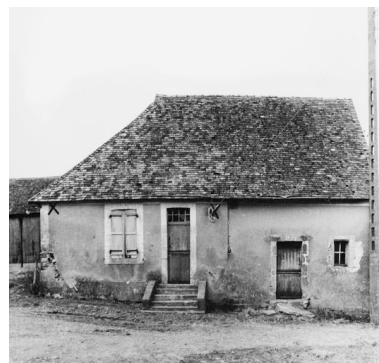
Logis, élévation antérieure de l'aile en retour : état vers 1979. Repro. Yves Guillotin IVR52_20117200574NUCA
