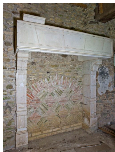
Logis, aile en retour : cheminée, 4e quart du XXe siècle. Phot. Yves Guillotin IVR52_20117200572NUCA
