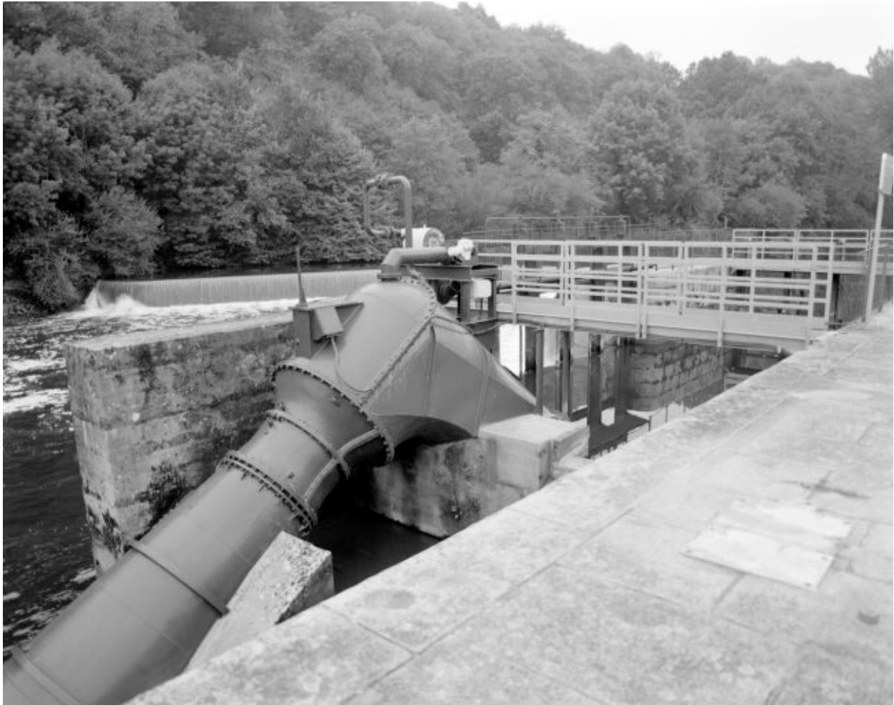
La maison éclusière et le transformateur électrique.
