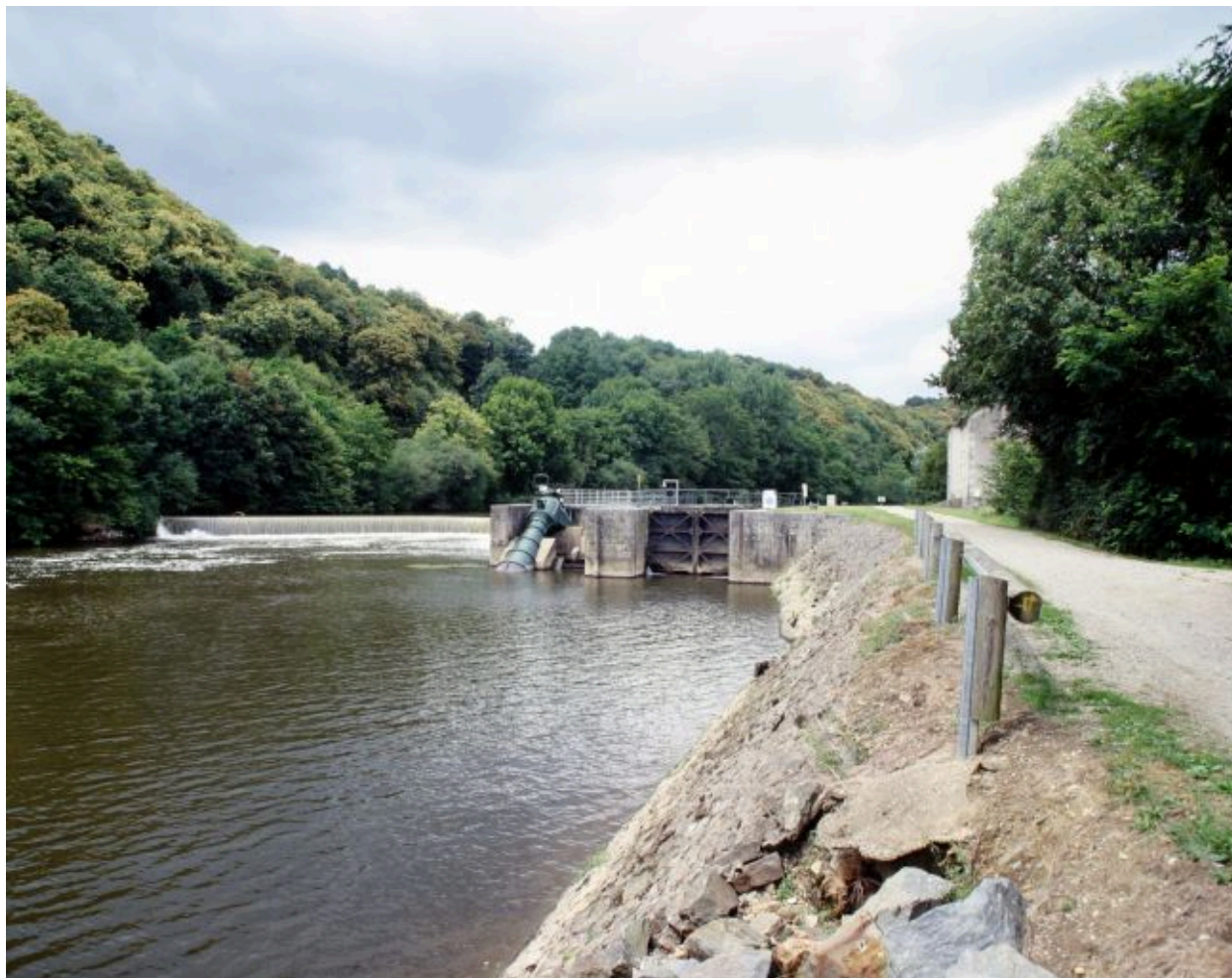
Vue d'ensemble du site depuis la rive gauche en aval : barrage, micro-centrale électrique, écluse, maison éclusière.
