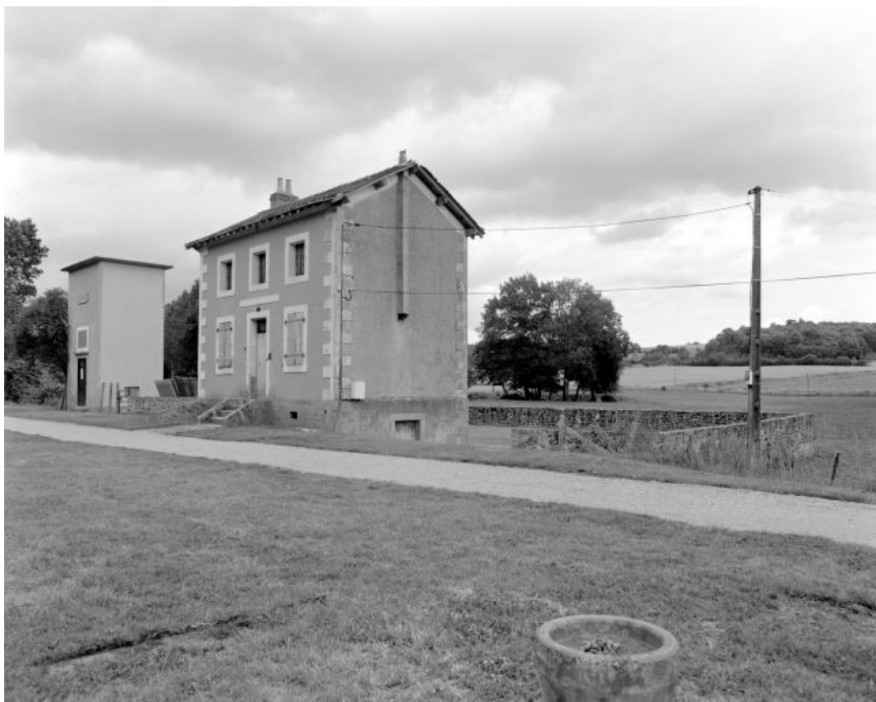
La maison éclusière et le transformateur électrique.
