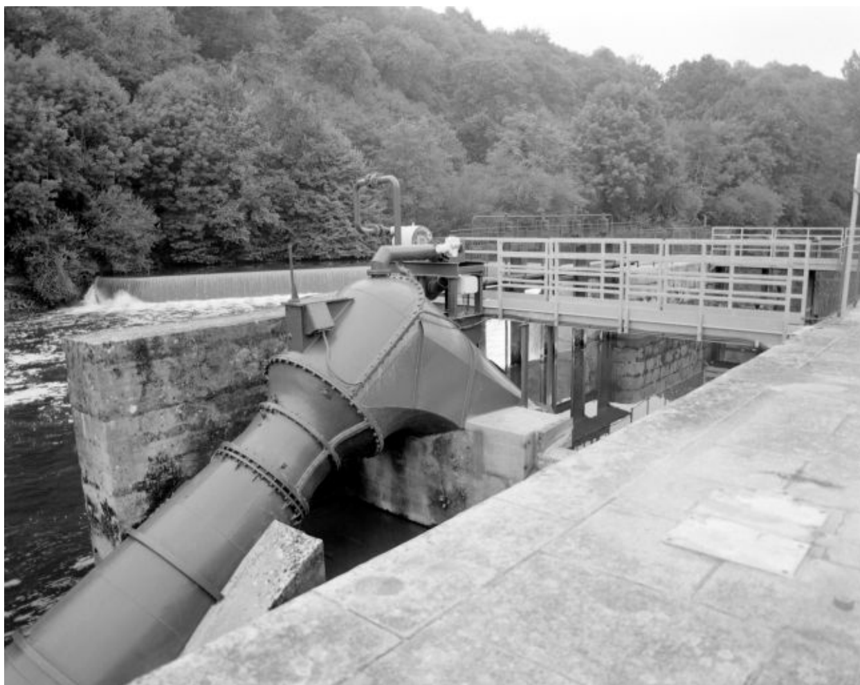
La maison éclusière et le transformateur électrique.
