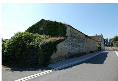
La grange-étable vue depuis le nord. Phot. Yannis Suire IVR52_20238501720NUCA
