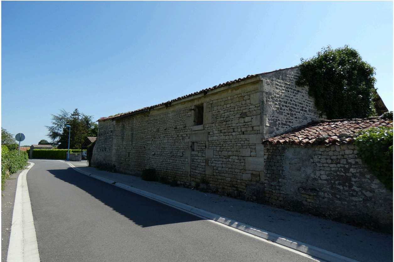
La grange-étable au nord du logis, vue depuis l'ouest.
