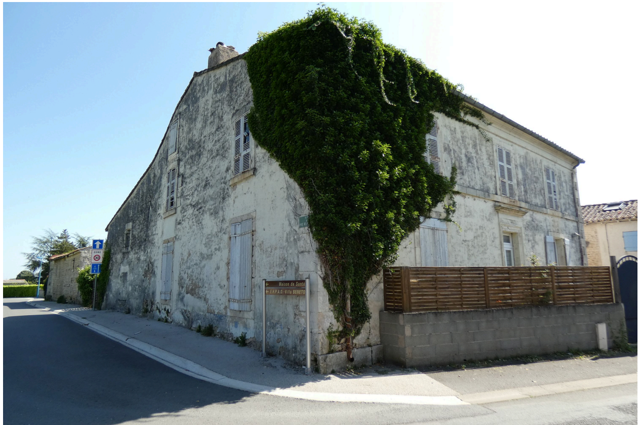
Le logis et ses dépendances vus depuis l'ouest.
