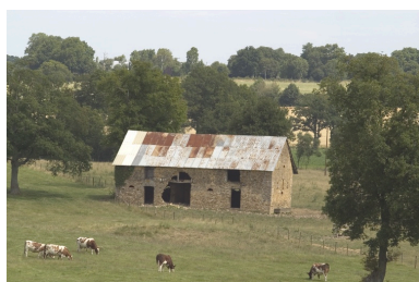
L'étable-grange vue depuis le sud. Phot. François Lasa IVR52_20045302175NUCA
