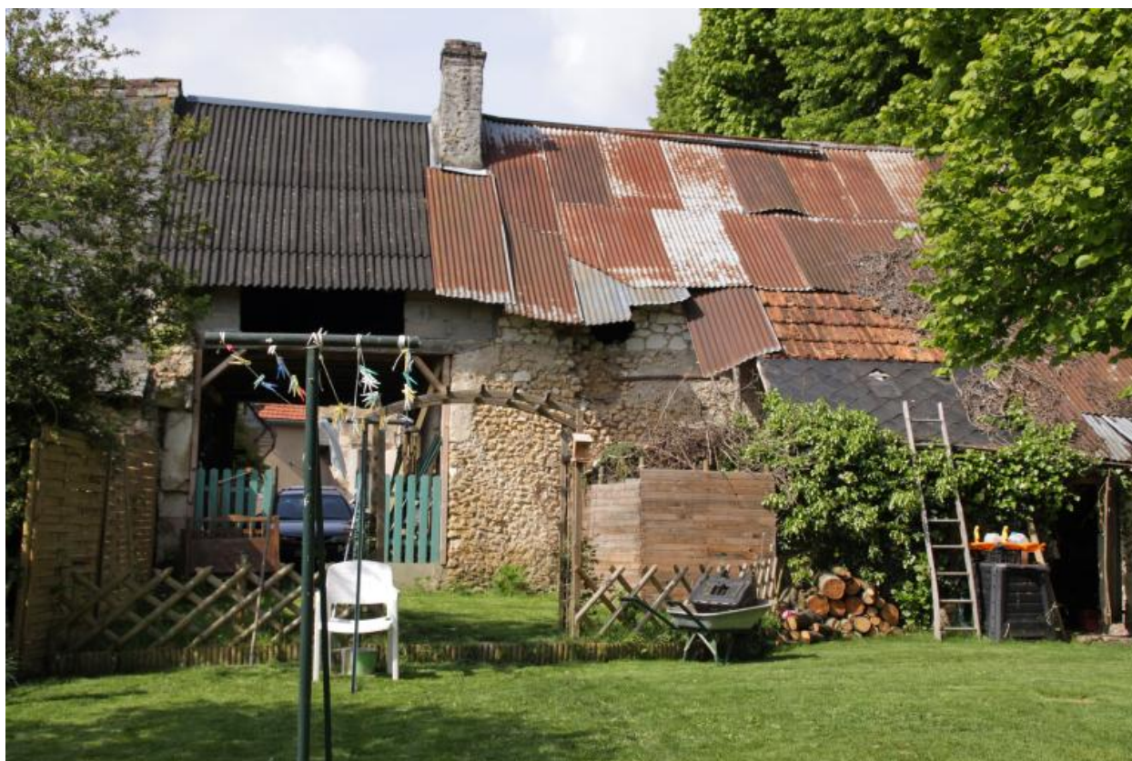
Maison 3 : façade postérieure.
