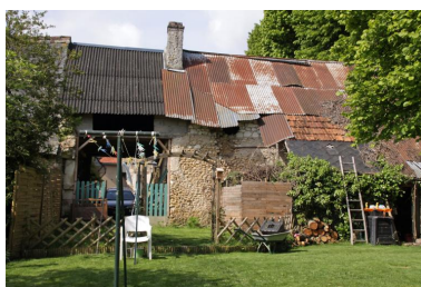
Maison 3 : façade postérieure. Phot. Jean-Baptiste Darrasse IVR52_20107200807NUCA
