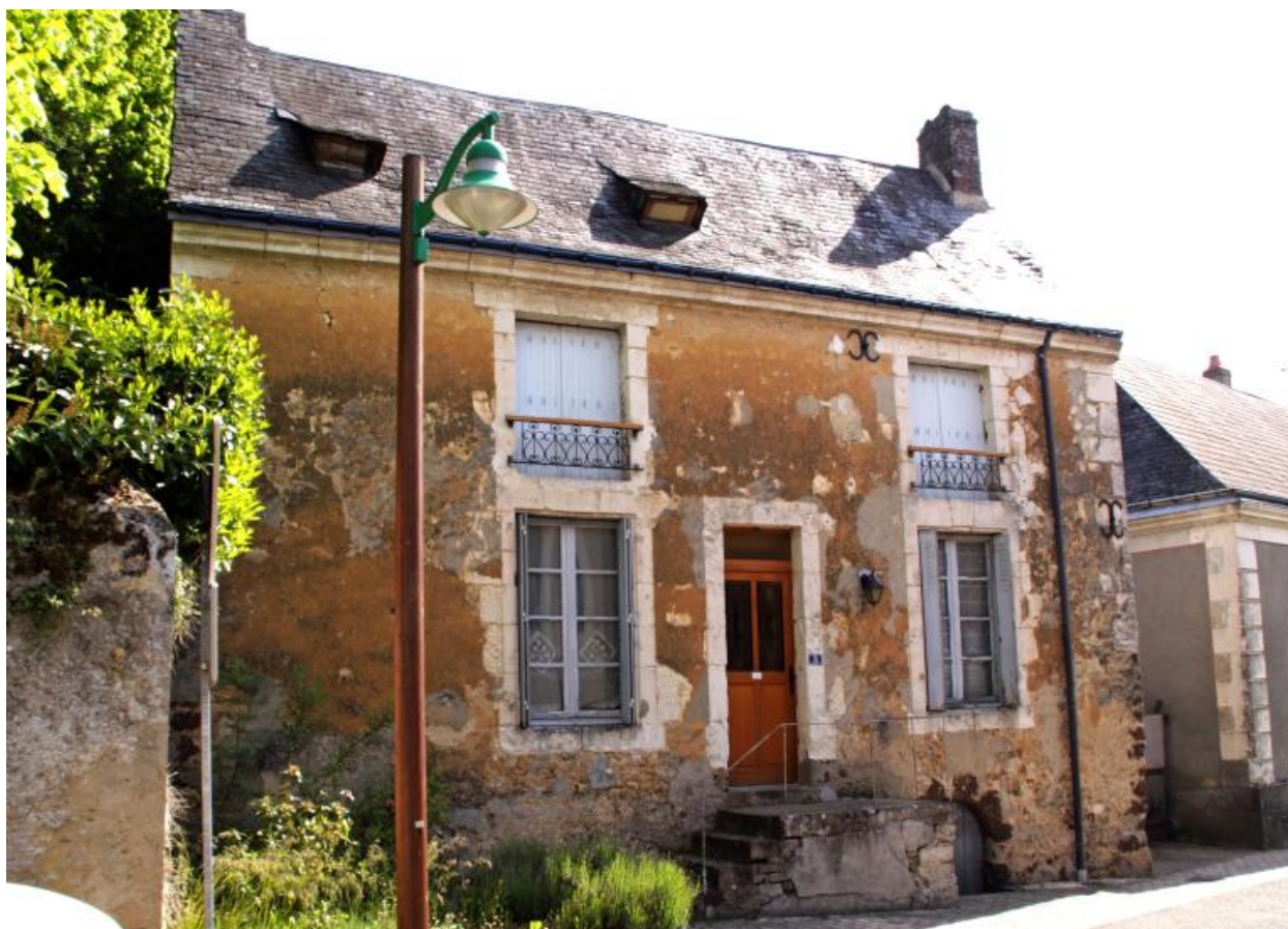
Maison 1 : façade sur rue.
