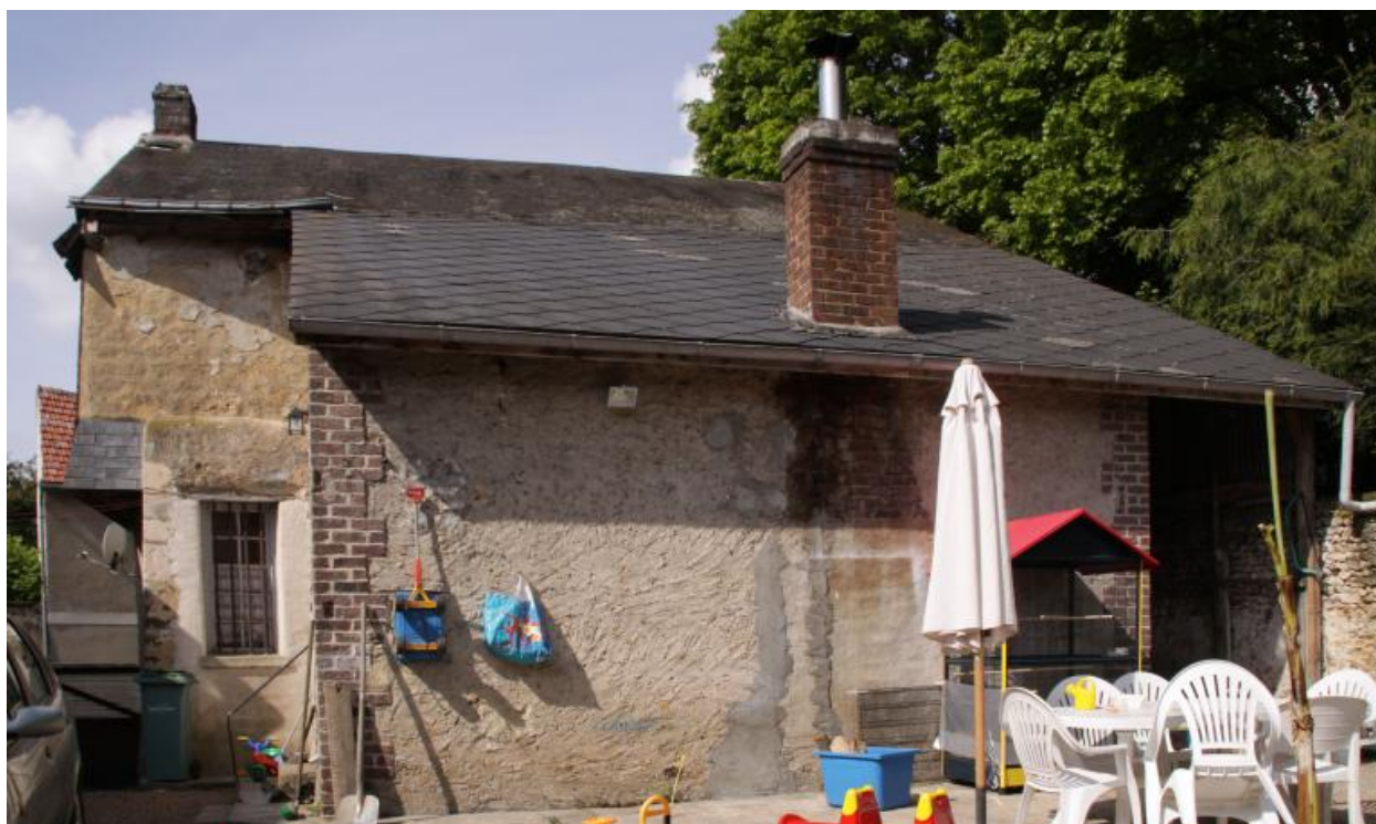
Maisons 1 et 2 vues depuis la cour.
