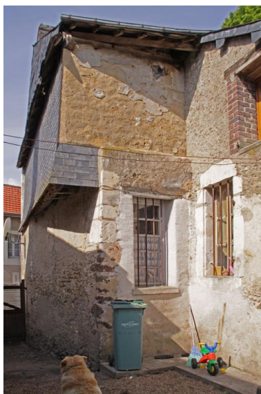
Maisons 1 et 2 vues depuis le passage menant à la cour. Phot. Jean-Baptiste Darrasse IVR52_20107200811NUCA
