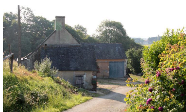
Vue prise depuis l'ouest. Toits à porcs accolés à l'ensemble d'habitation. Phot. Jean-Baptiste Darrasse IVR52_20107201172NUCA
