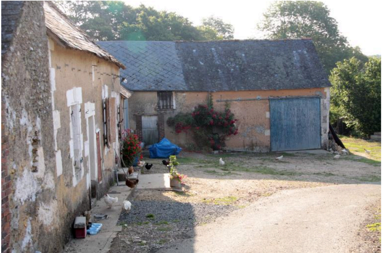
Etable et grange 2 : façade ouest sur cour.
