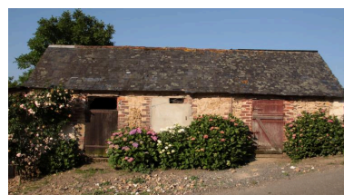
Soles : façade nord sur cour. Phot. Jean-Baptiste Darrasse IVR52_20107201177NUCA
