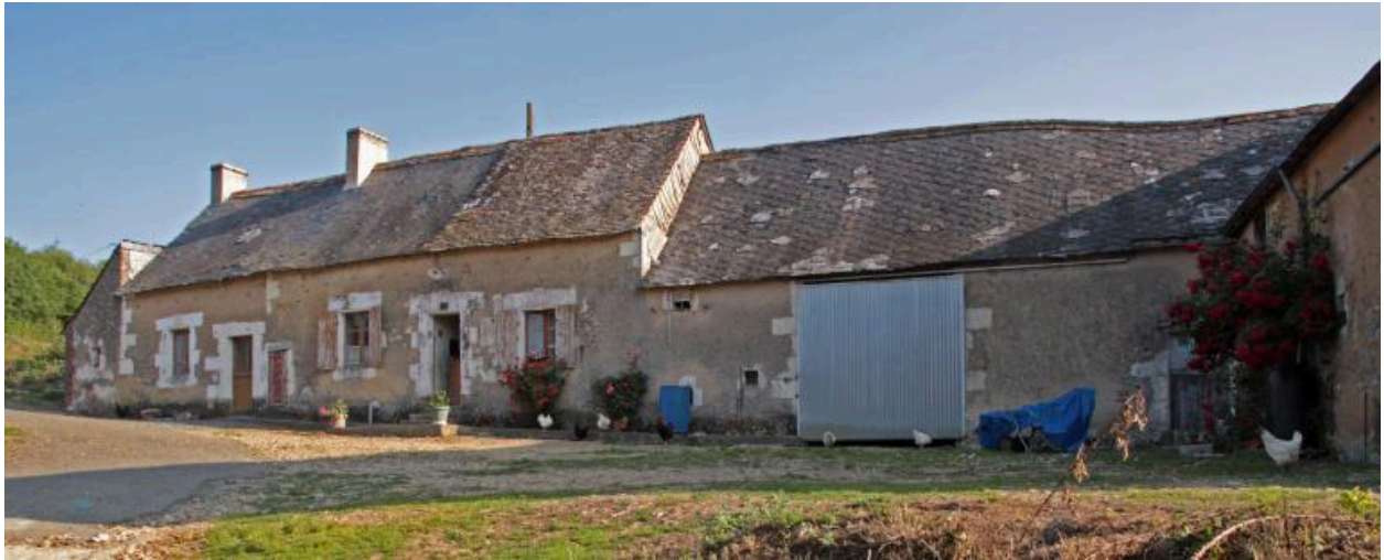
Maisons et grange 1 : façades sud sur cour.
