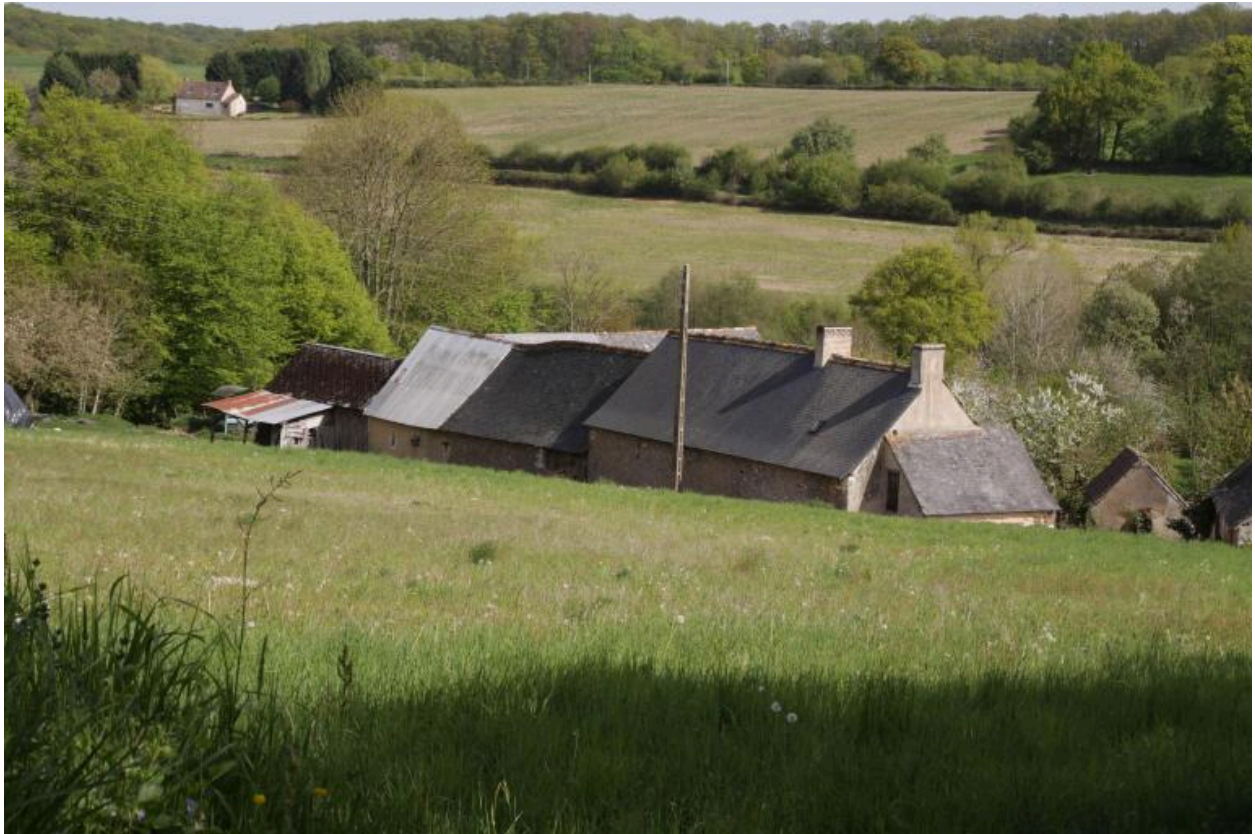
Vue d'ensemble prise depuis le nord-ouest.
