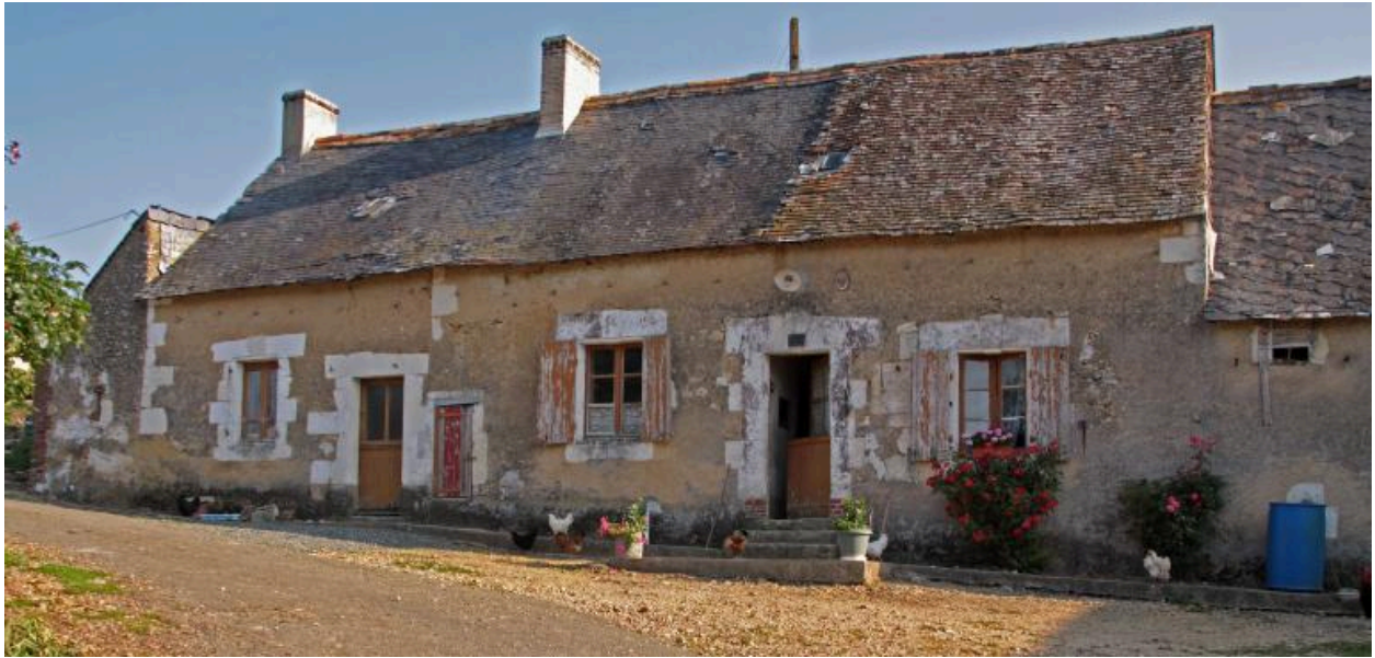
Maisons 1 et 2 : façades sur cour.
