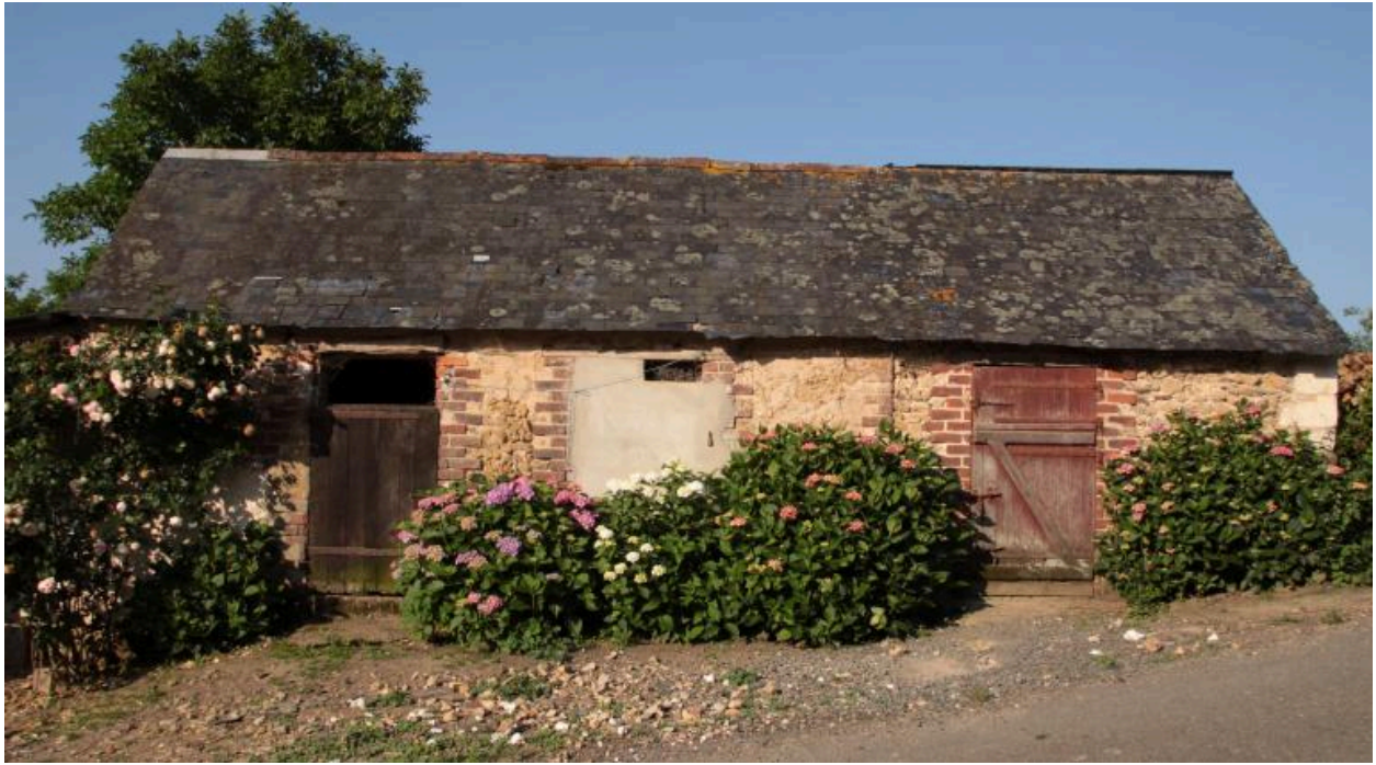
Soues : façade nord sur cour.
