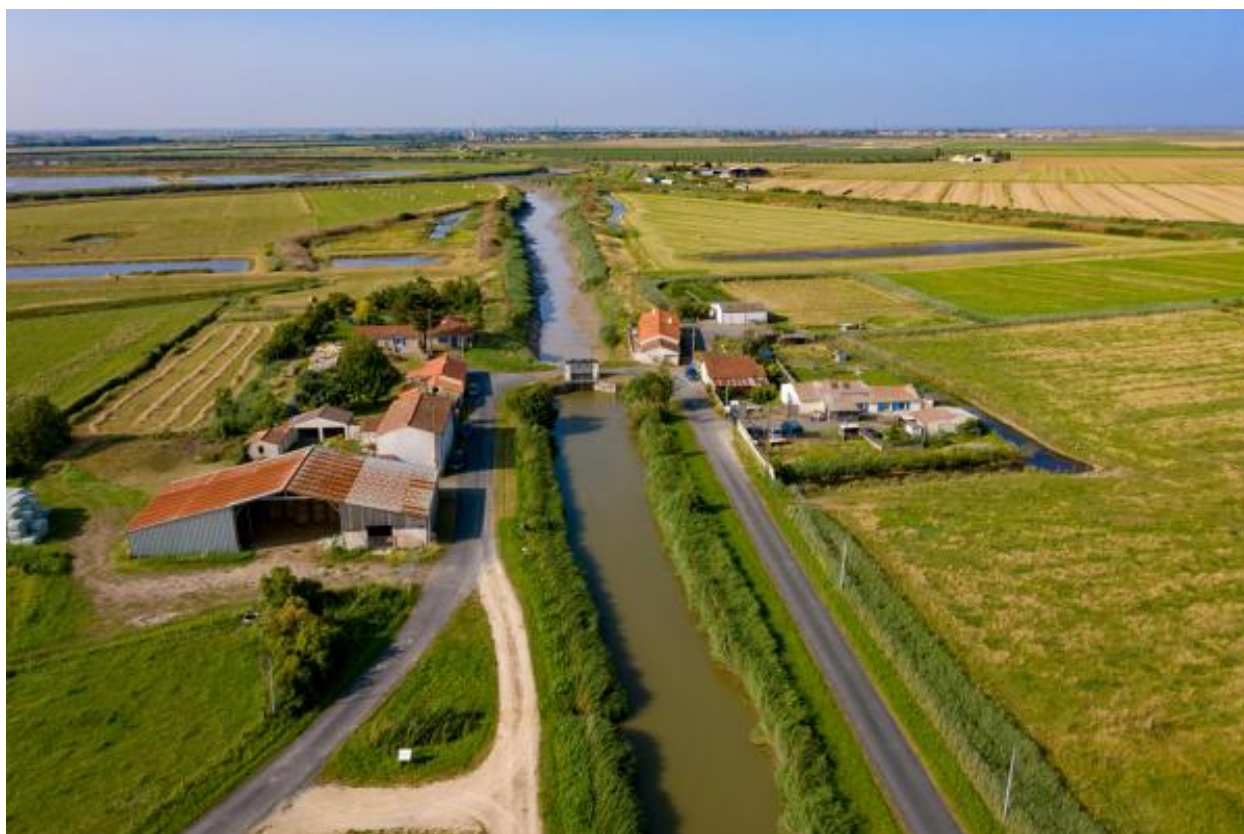
Vue aérienne depuis l'amont, en direction du sud-ouest.
