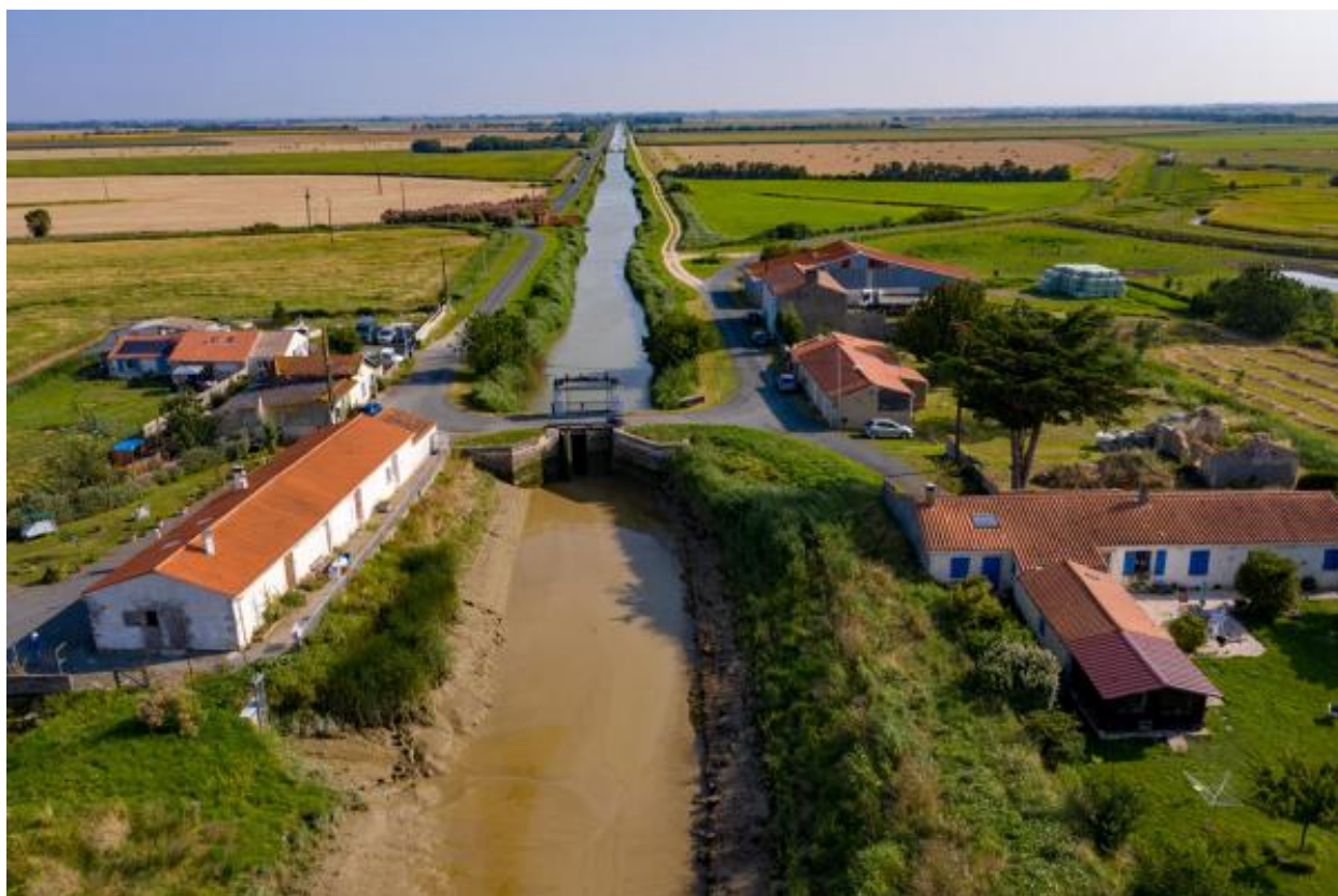
Vue aérienne depuis l'aval, en direction du nord-est.
