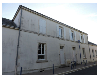
Le corps principal de bâtiment, côté nord, rue du Têteau. Phot. Yannis Suire IVR52_20188500513NUCA
