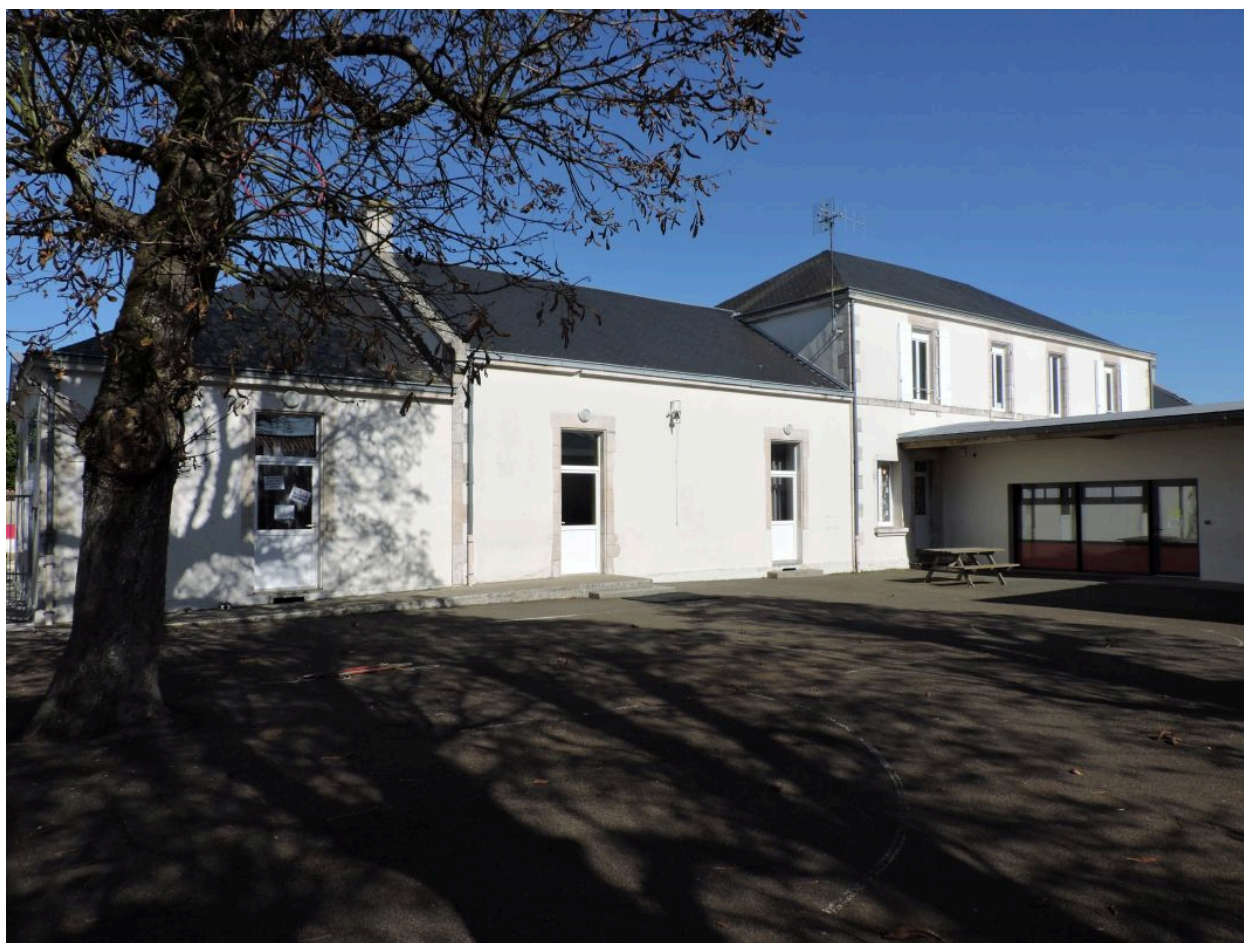
La cour ouest et les bâtiments au fond, vus depuis le sud-ouest.
