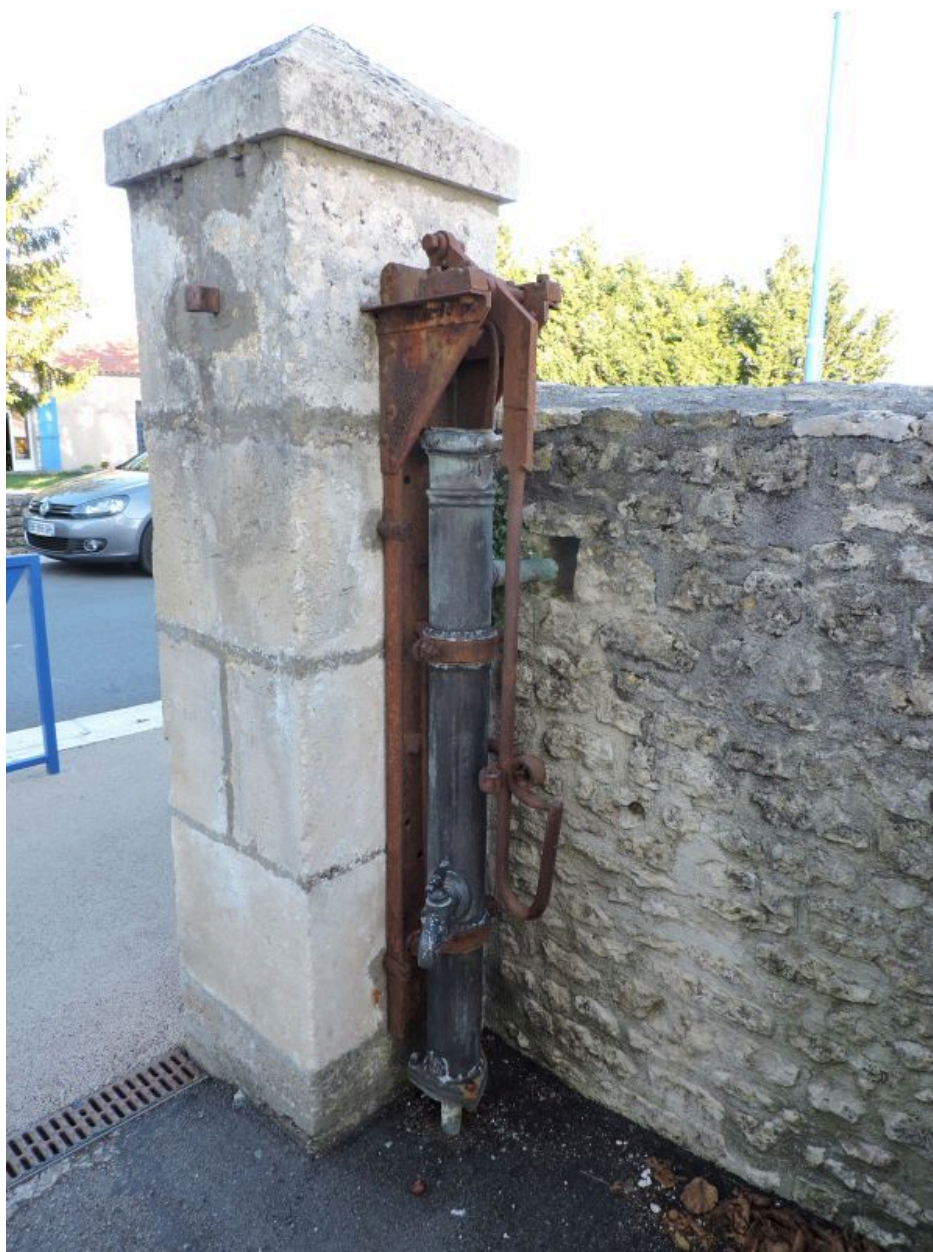
Pilier de portail et pompe de puits entre l'école et la cantine.
