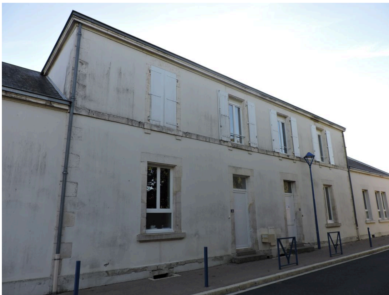
Le corps principal de bâtiment, côté nord, rue du Têteau.
