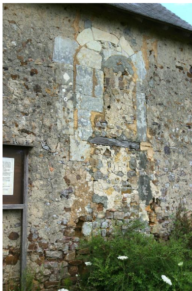
Détail de l'élévation sud : fenêtre bouchée du chœur. Phot. François Lasa IVR52_20035302169NUCA
