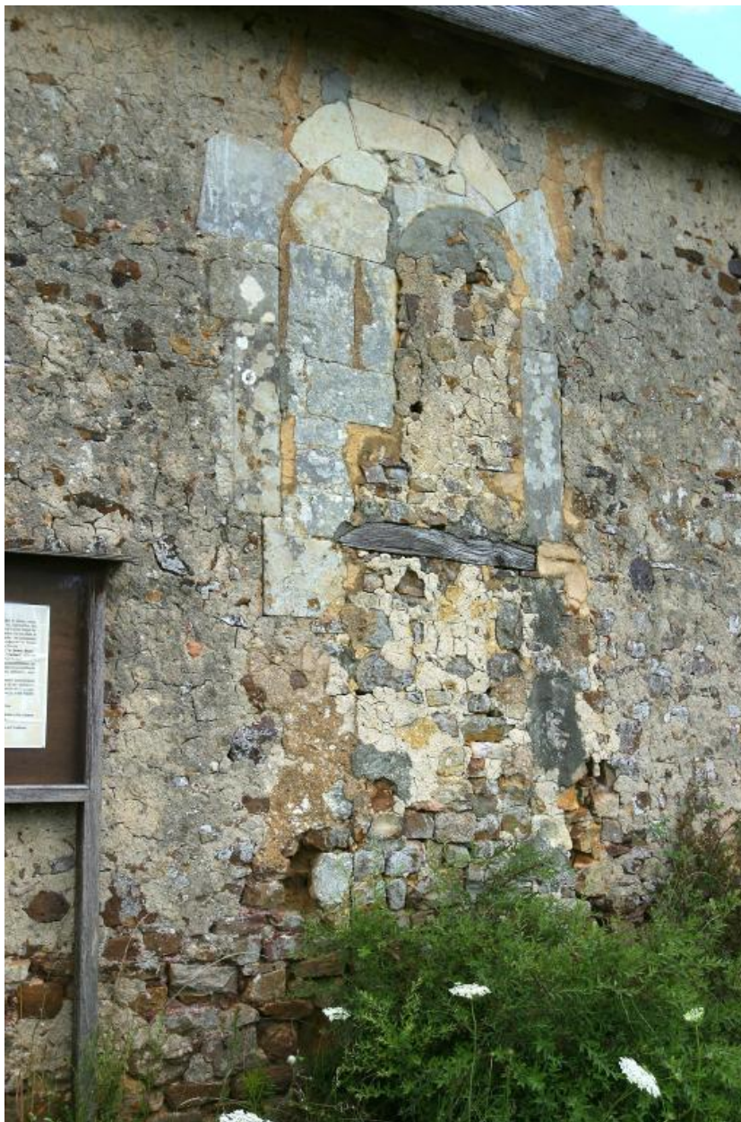
Détail de l'élévation sud : fenêtre bouchée du chœur.
