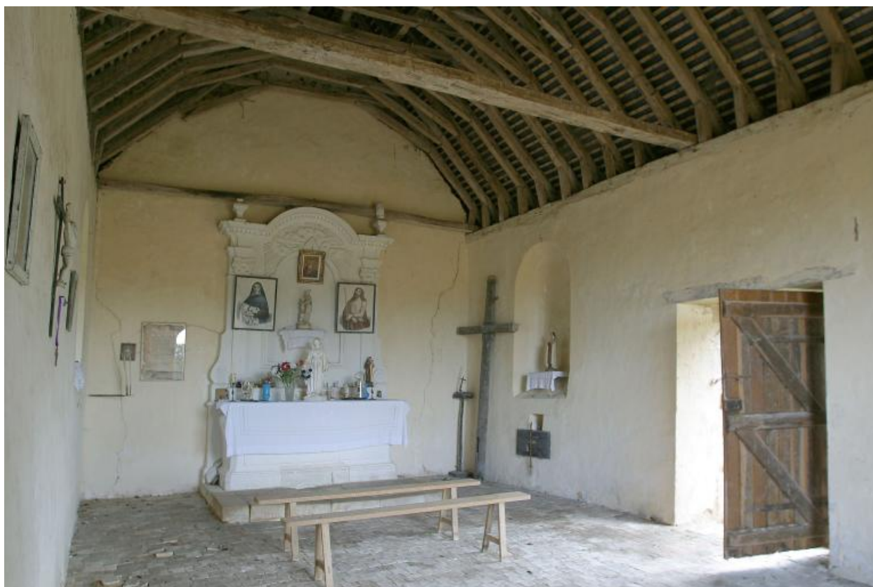
Vue intérieure depuis l'ouest.
