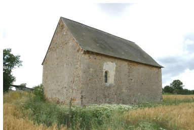
Les élévations est et nord. Phot. François Lasa IVR52_20035302170NUCA
