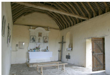
Vue intérieure depuis l'ouest. Phot. François Lasa IVR52_20035302172NUCA
