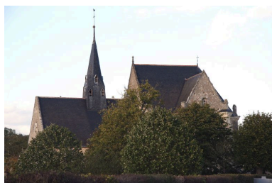
Vue de volume prise du sud. Phot. Jean-Baptiste Darrasse IVR52_20057203871NUCA
