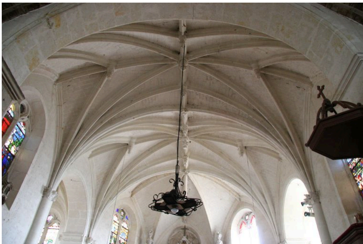
Le chœur : voûtes d'ogives bombées.
