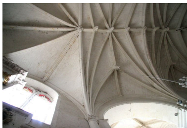
Demies travées de voûtes de l'abside et du chœur, détail. Phot. Jean-Baptiste Darrasse IVR52_20057203795NUCA
