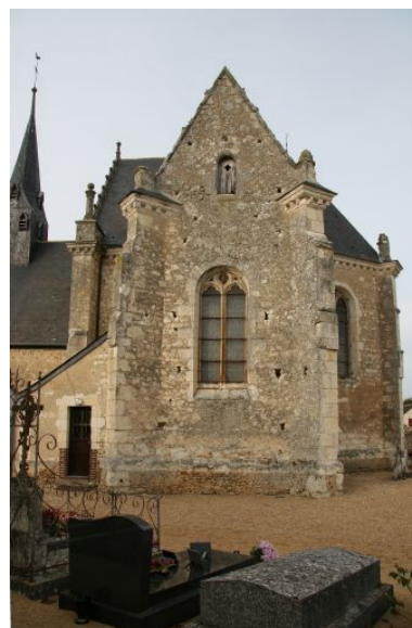
Façade méridionale : bras droit du transept. Phot. Jean-Baptiste Darrasse IVR52_20057203782NUCA
