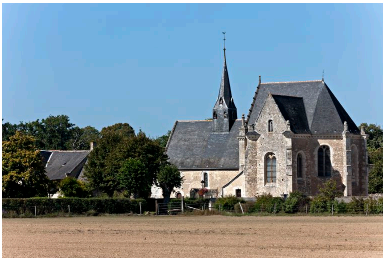
Vue de volume prise du sud.
