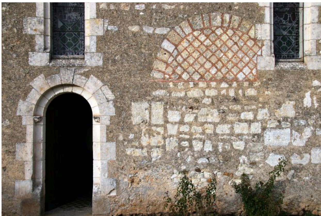
Façade méridionale de la nef : appareil réticulé.
