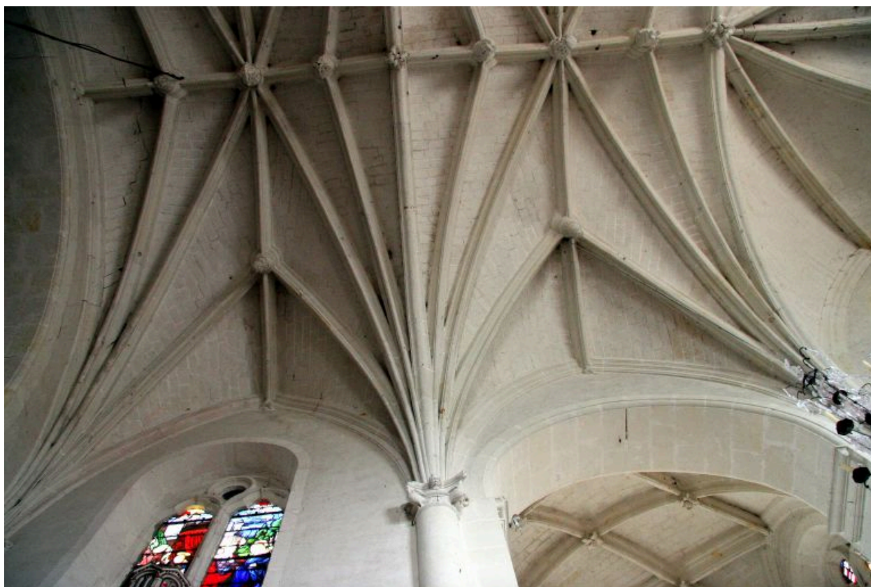
Demies travées de voûtes du chœur : détail.
