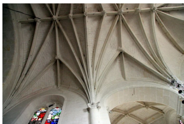
Demies travées de voûtes du chœur : détail. Phot. Jean-Baptiste Darrasse IVR52_20057203792NUCA
