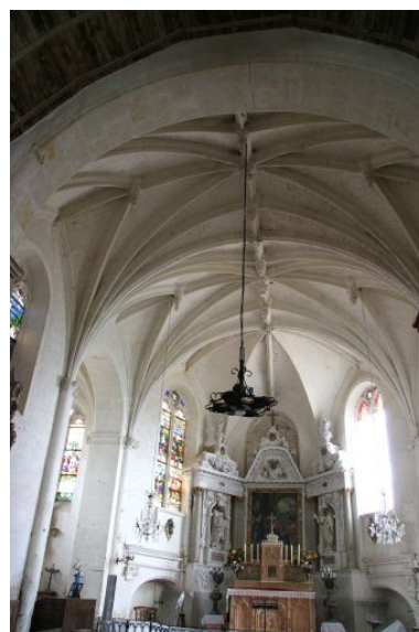
Vue de volume du chœur. Phot. Jean-Baptiste Darrasse IVR52_20057203791NUCA
