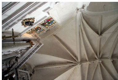
Demies travées de voûtes de l'abside et du chœur, détail. Phot. Jean-Baptiste Darrasse IVR52_20057203794NUCA
