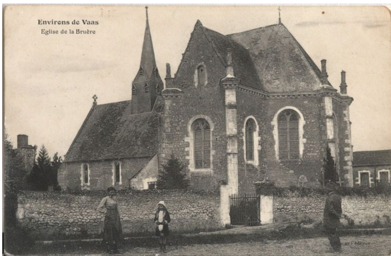
Façade méridionale prise du sud-est.
