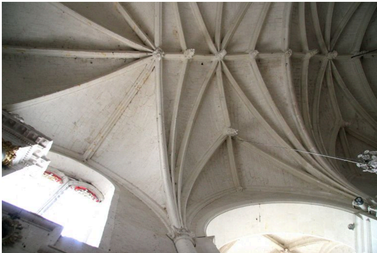
Demies travées de voûtes de l'abside et du chœur, détail.
