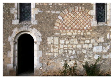
Façade méridionale de la nef : appareil réticulé. Phot. Jean-Baptiste Darrasse IVR52_20057203785NUCA
