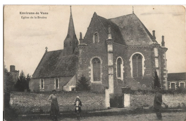
Façade méridionale prise du sud-est. Phot. Jean-Baptiste (reproduction) Darrasse IVR52_20067205390NUCA
