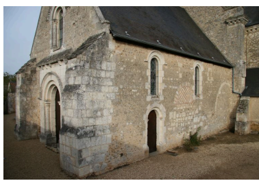
Façade méridionale de la nef. Phot. Jean-Baptiste Darrasse IVR52_20057203783NUCA
