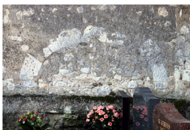
Abside : revers de l'enfeu. Phot. Jean-Baptiste Darrasse IVR52_20057203870NUCA
