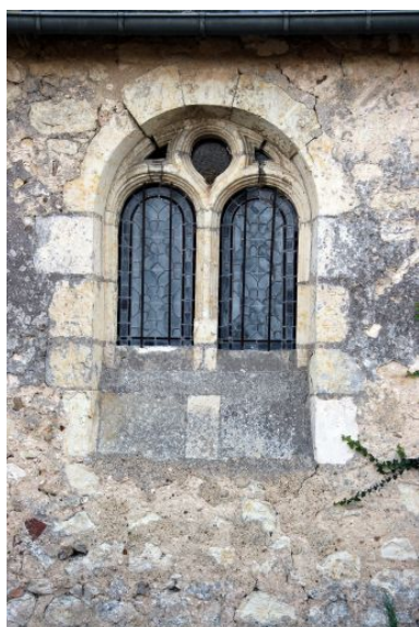
Fonts baptismaux : baie. Phot. Jean-Baptiste Darrasse IVR52_20057203869NUCA
