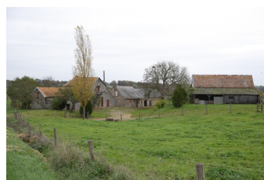
Vue d'ensemble depuis le sud- ouest : le logement-étable- porcherie, le logis-étable et la remise. Phot. François Lasa IVR52_20065302725NUCA
