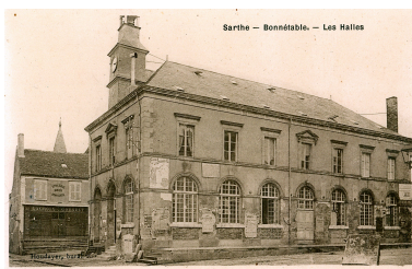
Etat ancien de l'élévation sur la place de la maison n° 14 (à l'arrière plan).
