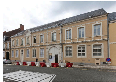
Maison, actuellement groupe scolaire, 18, place d'Armes. Phot. Yves Guillotin IVR52_20147201936NUCA
