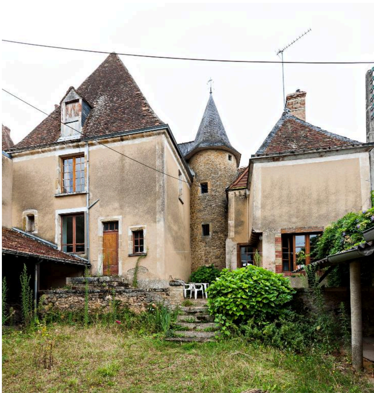
Elévations postérieure de la maison n° 14.
