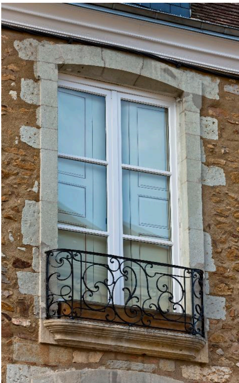
Baie de la maison n° 16, XVIIIe siècle.
