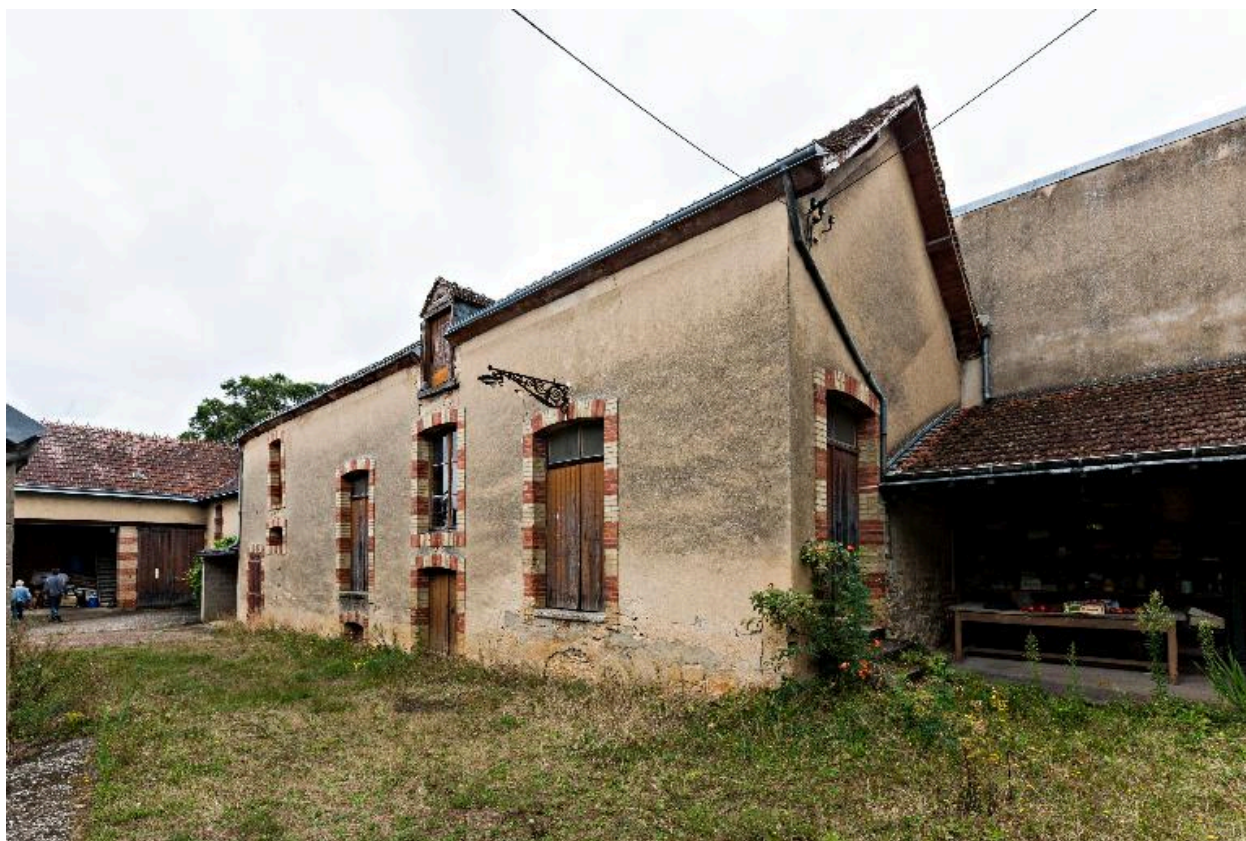
Remise et magasins construits vers 1908 pour l'ancienne épicerie en gros dans la cour de la maison n° 14.
