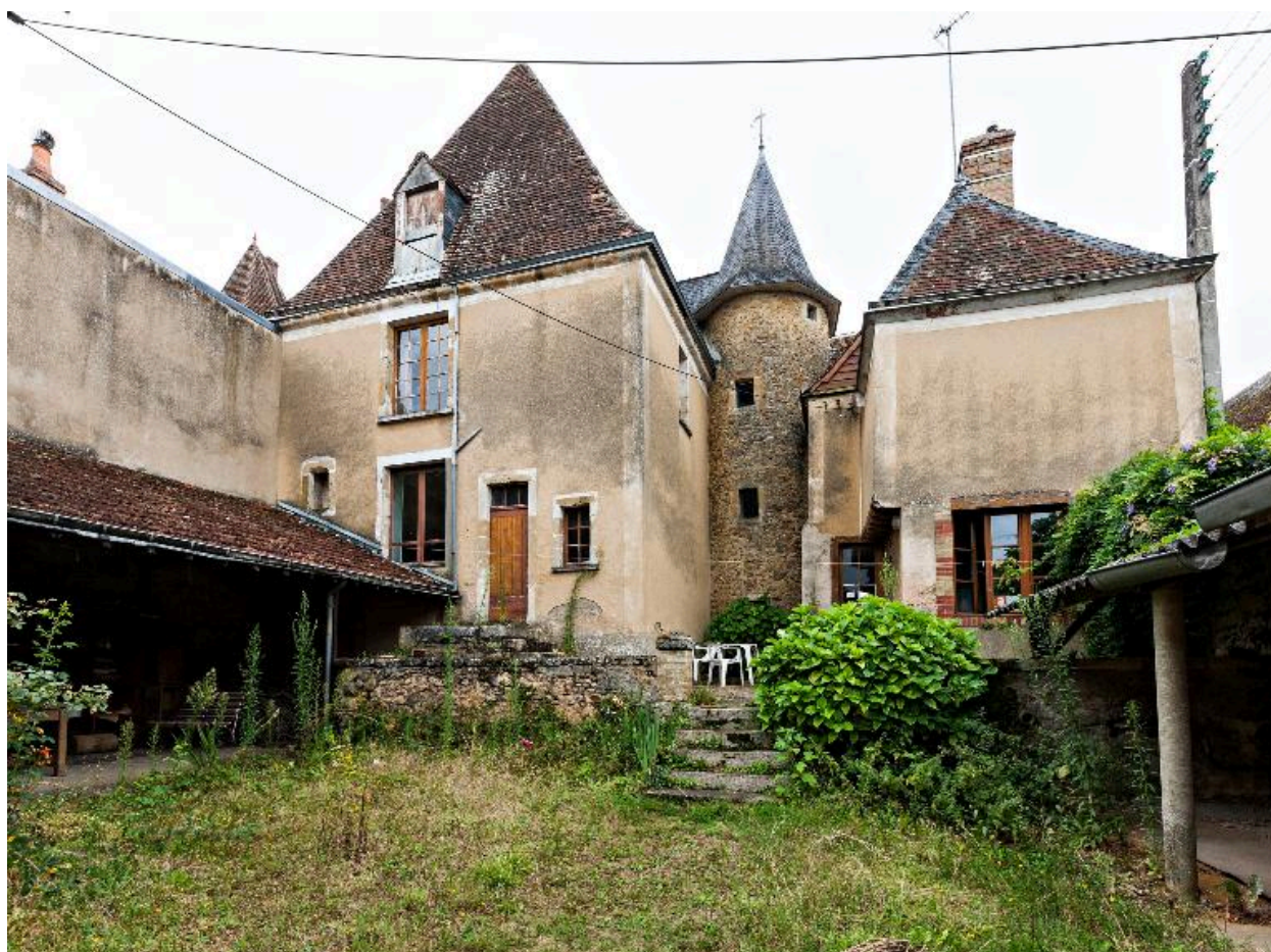
Elévations postérieure de la maison n° 14.
