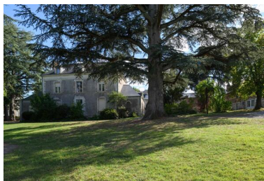
Vue d'ensemble, côté nord, de l'ancien prieuré et des communs. Phot. Armelle Maugin IVR52_20244900890NUCA
