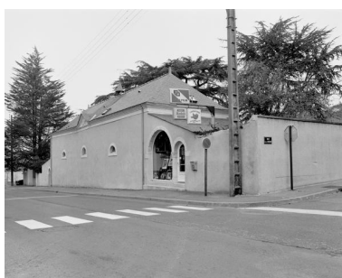
Façade sur rue, bâtiment privé abritant les vestiges de l'église du prieuré de Bénédictins. Phot. Bruno Rousseau IVR52_19854902240X
