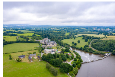
Le barrage de Saint-Fraimbault-de-Prières. Phot. Pierre-Bernard Fourny IVR52_20215300464NUCA
