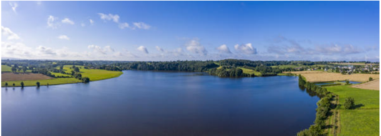
La retenue du barrage de Saint-Fraimbault-de-Prières.
