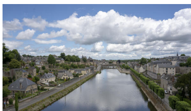
La Mayenne à Mayenne. Phot. Pierre-Bernard Fourny IVR52_20225300529NUCA
