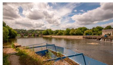
L'écluse du Port- Rhingeard à Entrammes. Phot. Pierre-Bernard Fourny IVR52_20235301076NUCA
