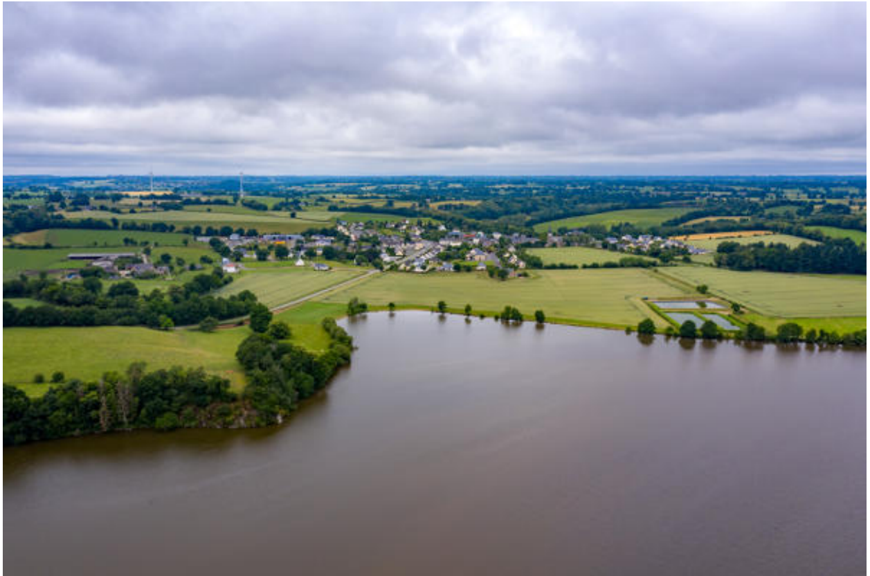
La retenue du barrage de Saint-Fraimbault-de-Prières.
