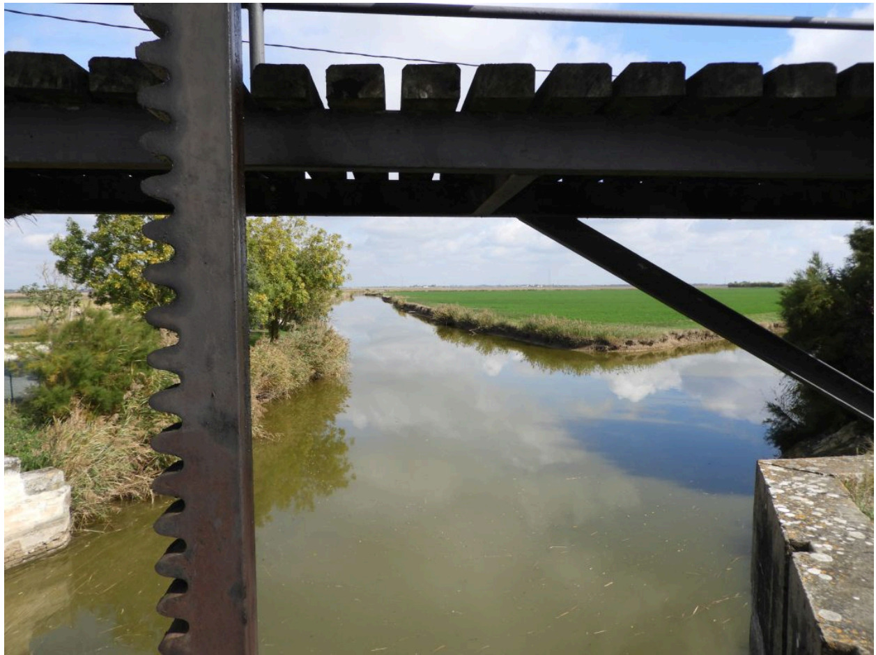
Le canal de l'Epine en amont de la porte, vu à travers le portique de celle-ci.
