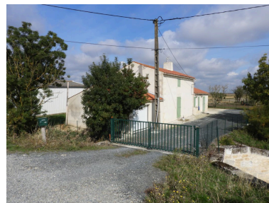
L'ancienne maison de garde vue depuis la porte au sud. Phot. Yannis Suire IVR52_20178500123NUCA
