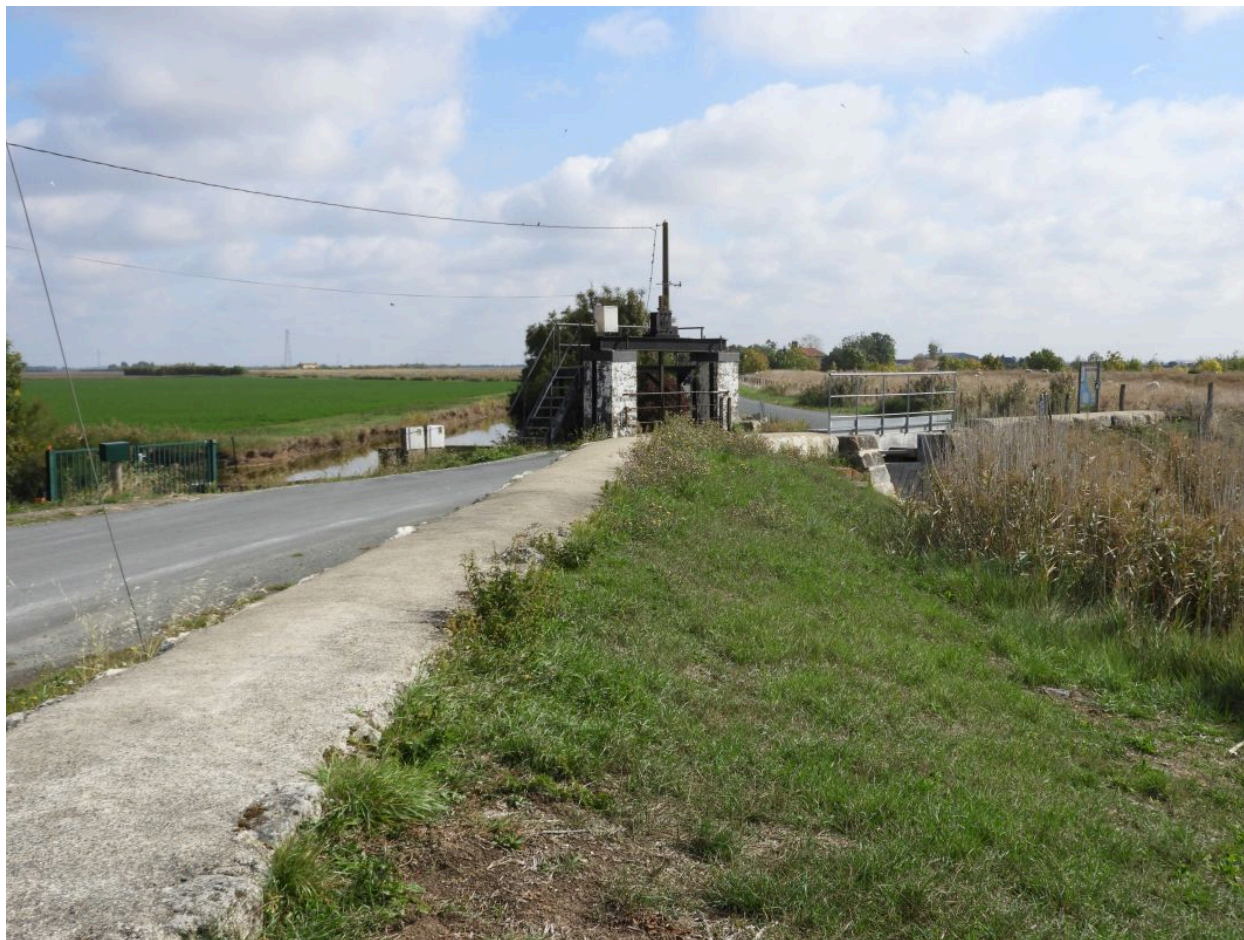
La porte vue depuis le nord-est, avec la digue qu'elle interrompt, au premier plan, et le chenal en arrière-plan.
