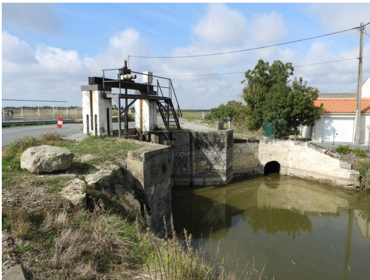
La porte vue depuis le nord-est, côté amont. A droite, la dérivation sous un petit pont, puis la maison de garde.
