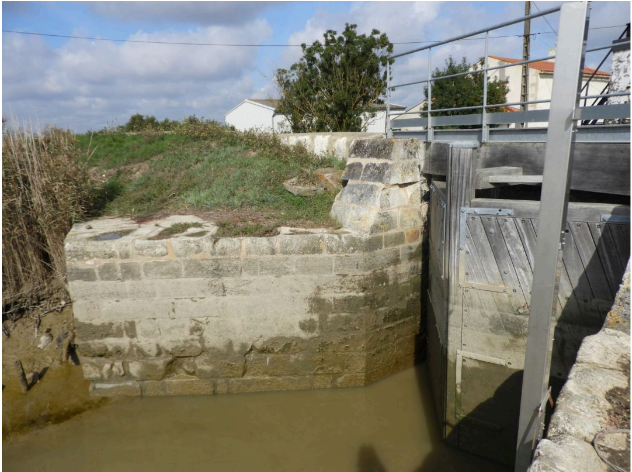
Bajoyer en pierre de taille en aval de la porte, rive droite.
