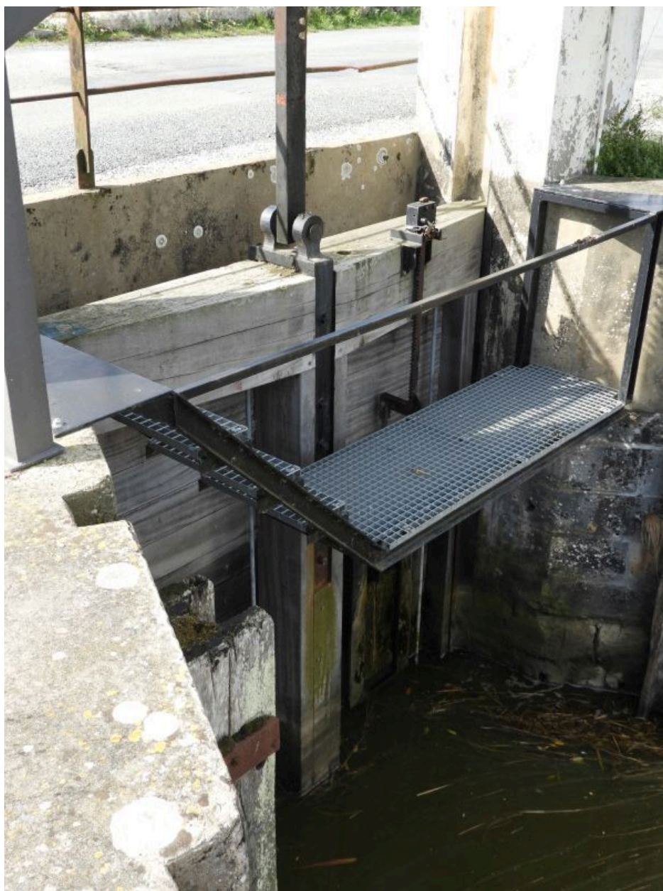
La vanne en bois à l'arrière de la porte.
