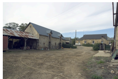
Vue d'ensemble depuis la cour au sud-est : à gauche, l'étable à chevaux ; au centre, le logis ; à droite l'étable à vaches-grange. Phot. François Lasa
