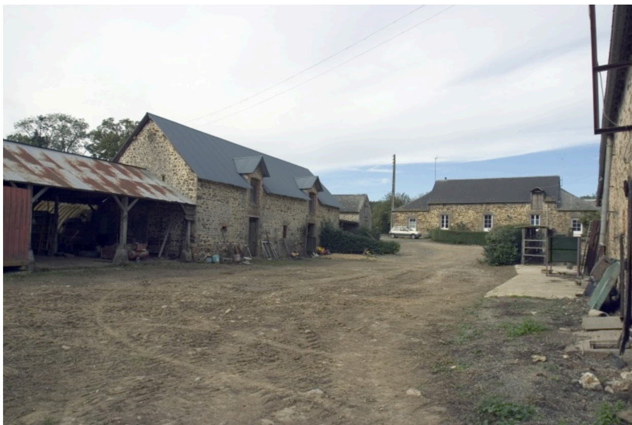
Vue d'ensemble depuis la cour au sud-est : à gauche, l'étable à chevaux ; au centre, le logis ; à droite l'étable à vaches-grange.
