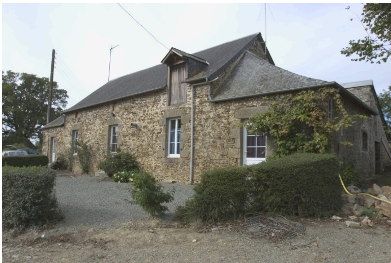
Le logis vu depuis l'est.
