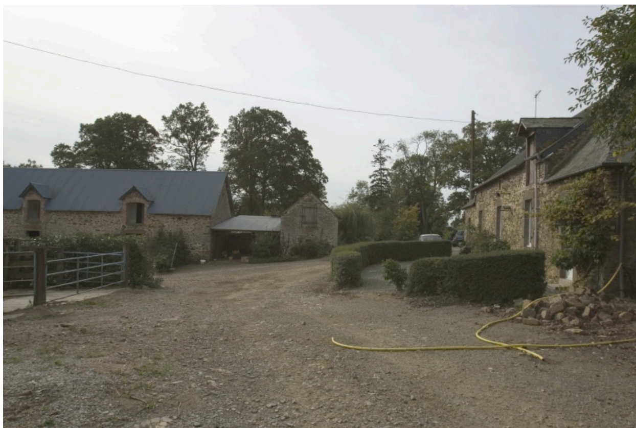
L'étable à chevaux, la porcherie et le logis vus depuis le nord-est.
