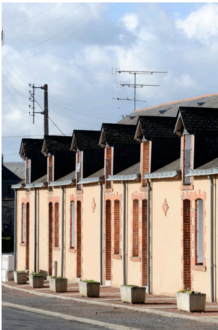
Les maisons ouvrières de la société Ripoché, depuis la rue Jeanne d'Arc.
