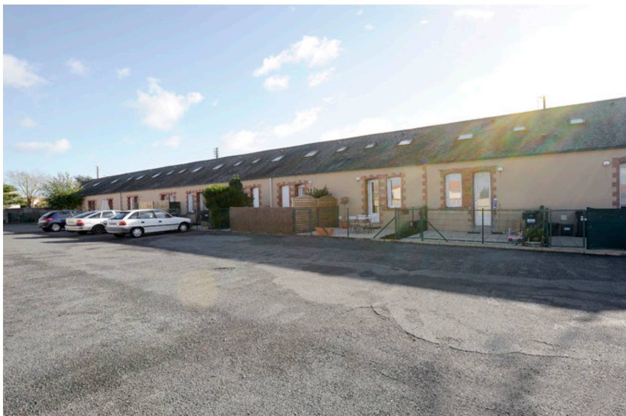
Les maisons ouvrières de la Société Ripoche, côté cour.
