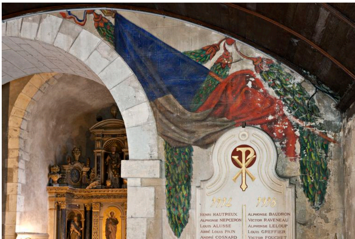
Chapelle sud, monument aux morts : détail du drapeau.
