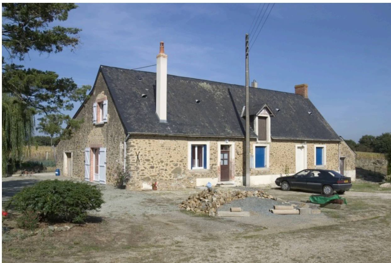
Le logis vu depuis le sud-est.
