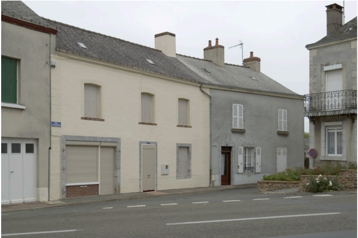
Vue depuis la route du Mans. La maison est à droite.
