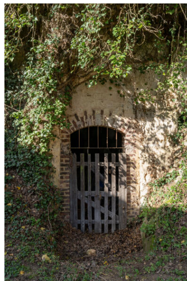
Entrée d'aménagement troglodytique. Phot. Jeanne Minier IVR52_20267200284NUCA
