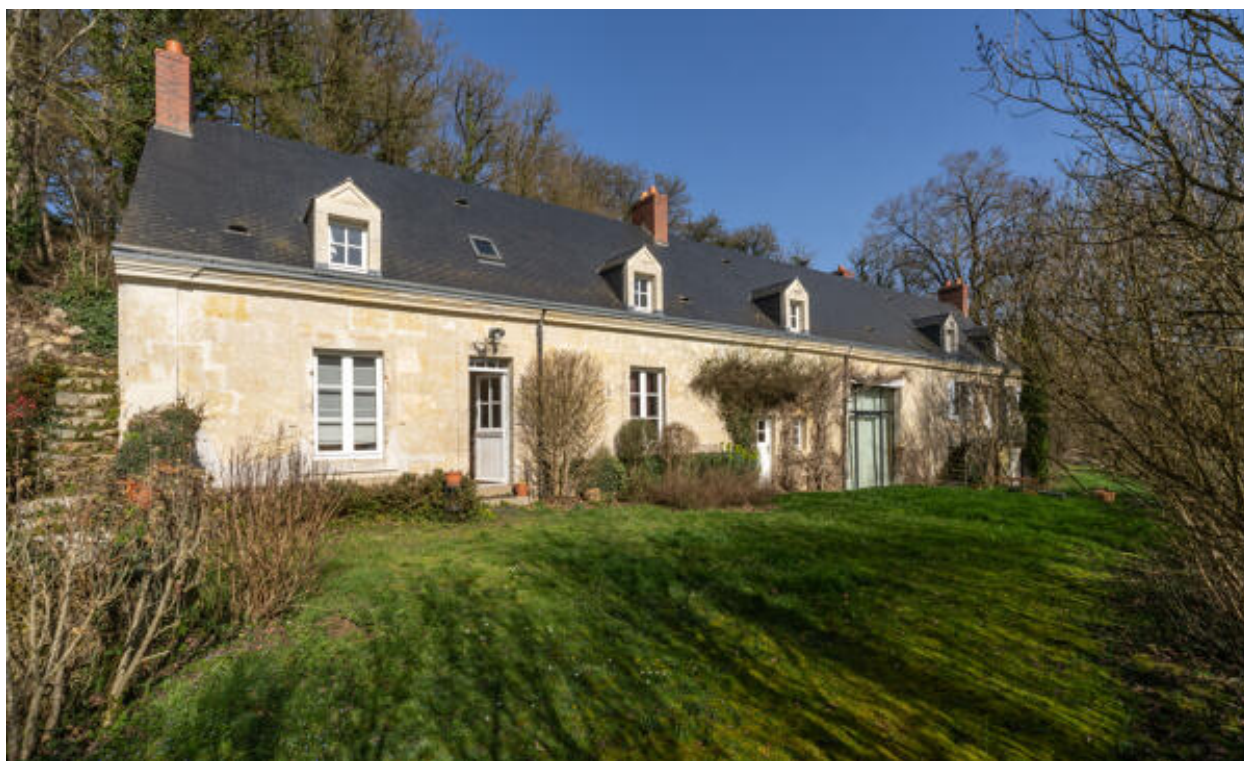
Logis et grange-étable sous même faîte.
