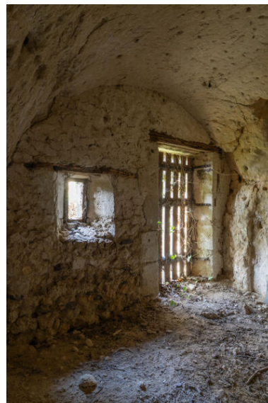
Étable troglodytique (?) : intérieur. Phot. Jeanne Minier IVR52_20267200291NUCA
