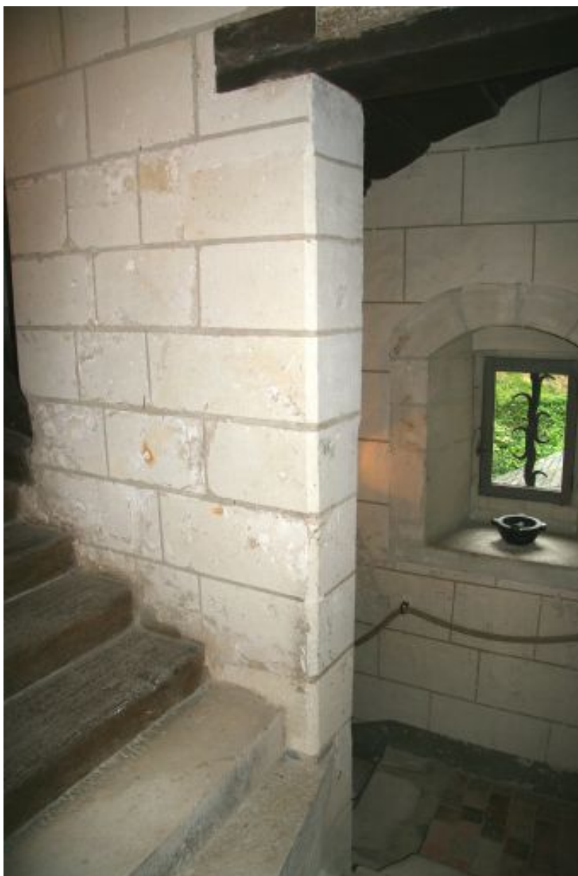
Le logis, escalier à 4 volées : mur d'échiffre.
