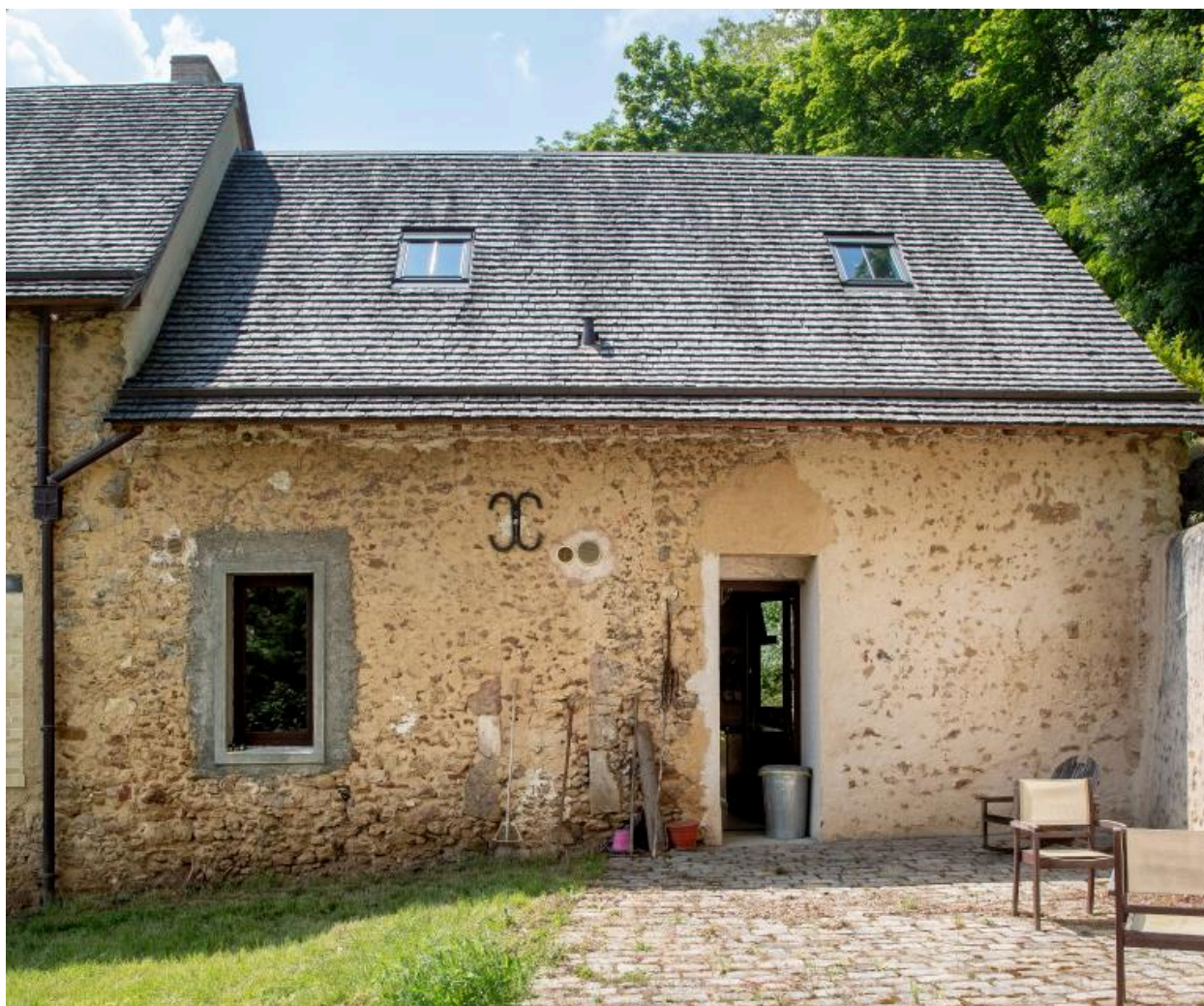
La façade arrière du bâtiment principal.
