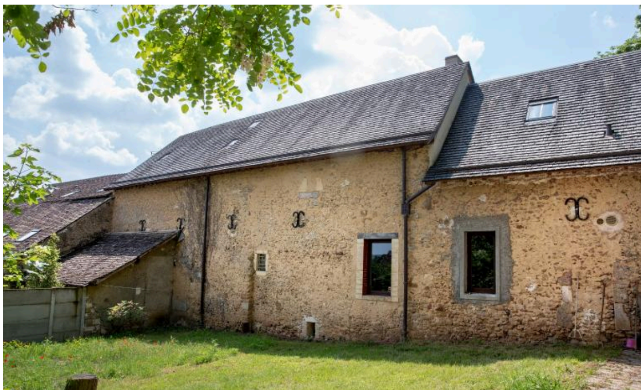
La façade arrière du bâtiment principal.
