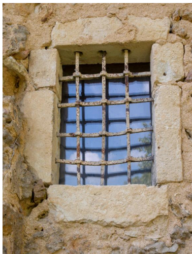
La fenêtre avec grille. Phot. Pierre-Bernard Fourny IVR52_20197201503NUCA
