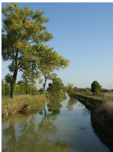
Le canal du Clain, au nord du bourg. Phot. Yannis Suire IVR52_20188500348NUCA
