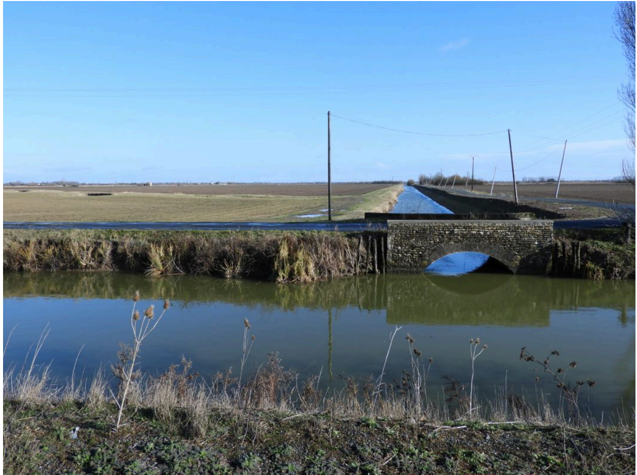
Pont au croisement entre le canal de Vienne, au premier plan, et le canal des Bardettes, à l'arrière-plan, vu depuis l'ouest.
