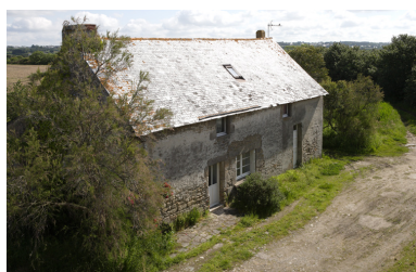
Logis du fermier. Vue depuis la terrasse.
