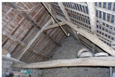
Dépendances. Détail de la charpente.
