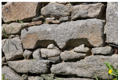
Dépendances. Détail d'un remploi de croisée.
