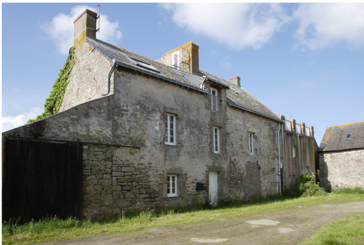
Logis. Vue de trois-quarts depuis le nord-est.
