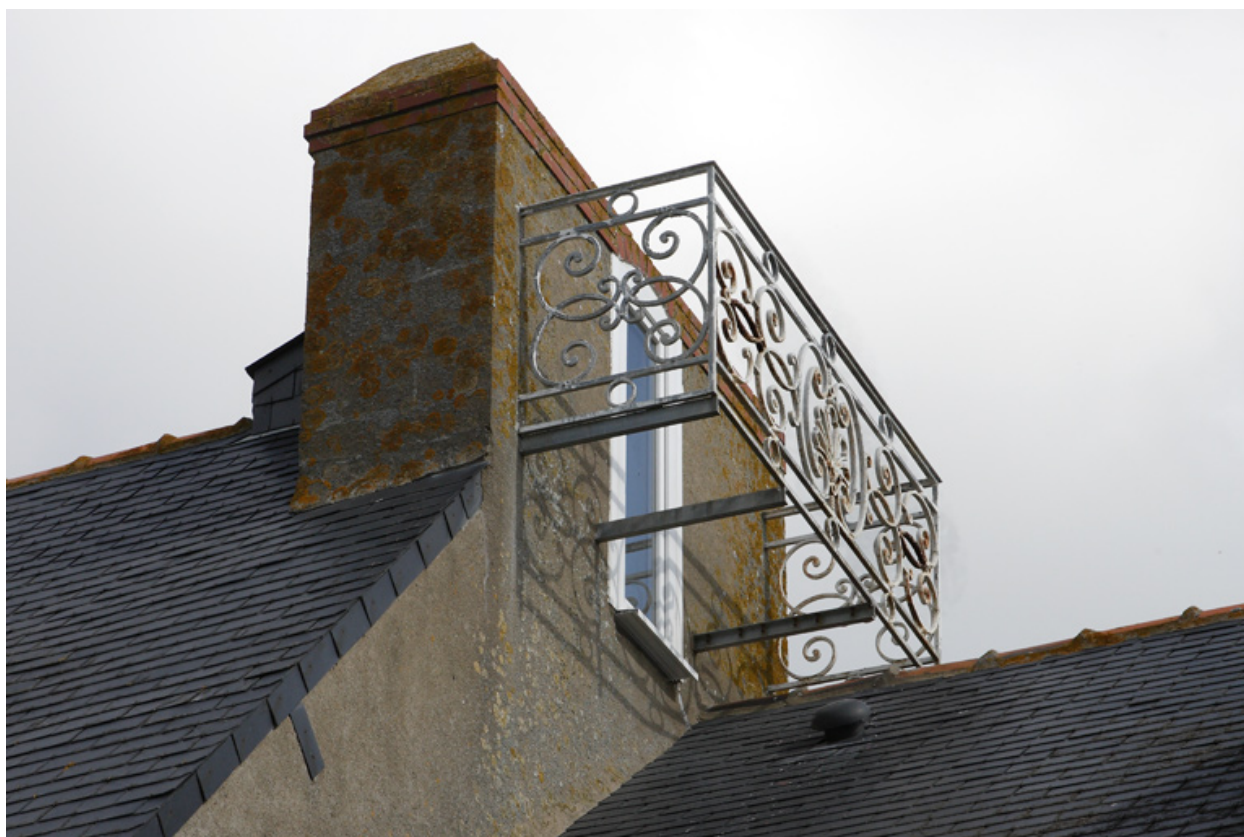
Logis. Détail du balcon aménagé sur le conduit de cheminée.
