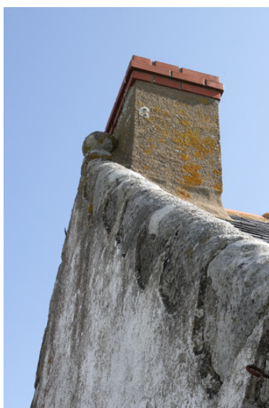
Logis. Partie centrale. Détail des rampants du pignon ouest. Phot. Denis Pillet IVR52_20084401629NUCA
