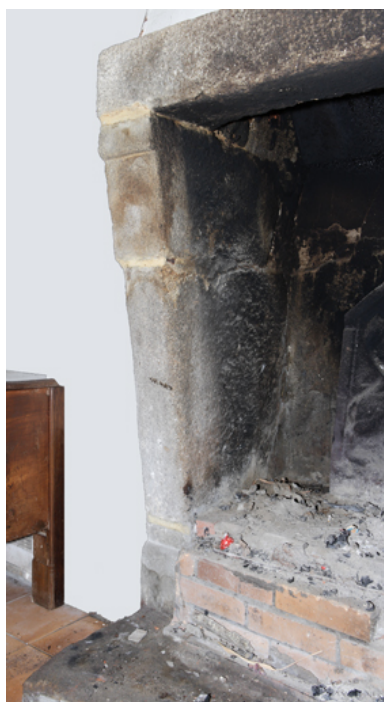
Logis. Partie est. Détail d'un piédroit de la cheminée du rez-de-chaussée.
