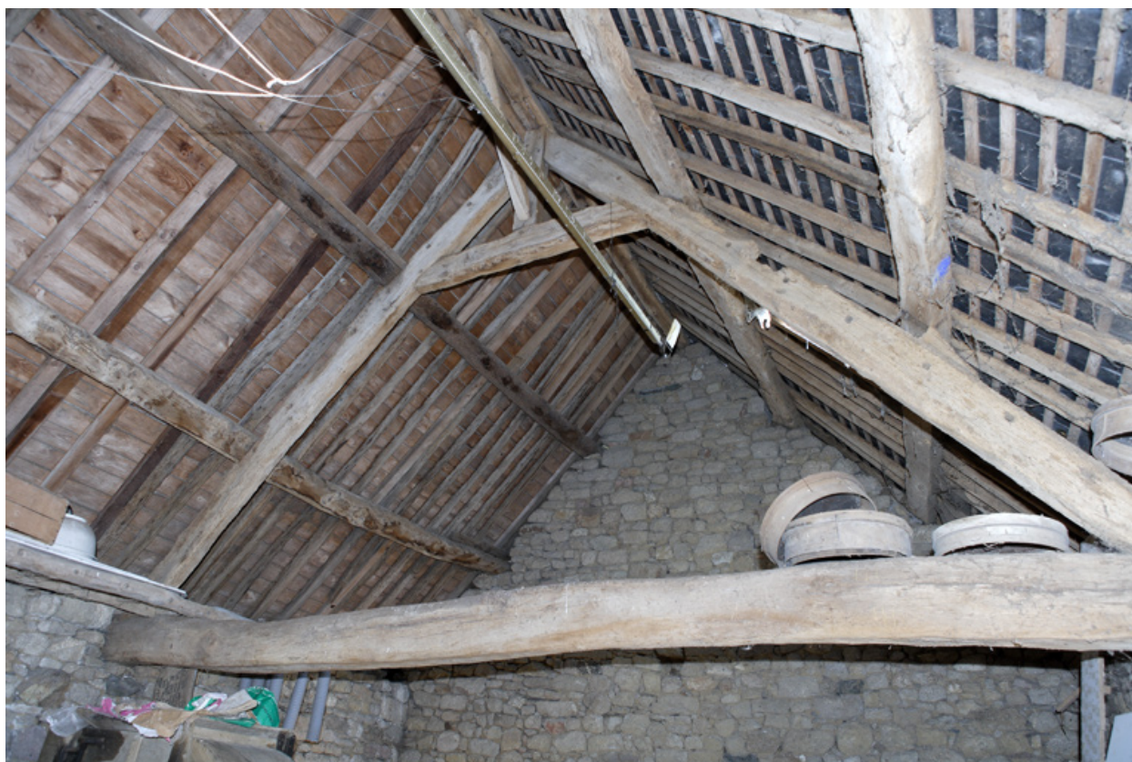
Dépendances. Détail de la charpente.
