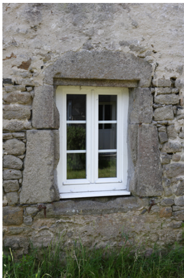
Logis. Façade nord. Partie est. Détail de la baie de gauche du rez-de-chaussée. Phot. Denis Pillet IVR52_20084401623NUCA
