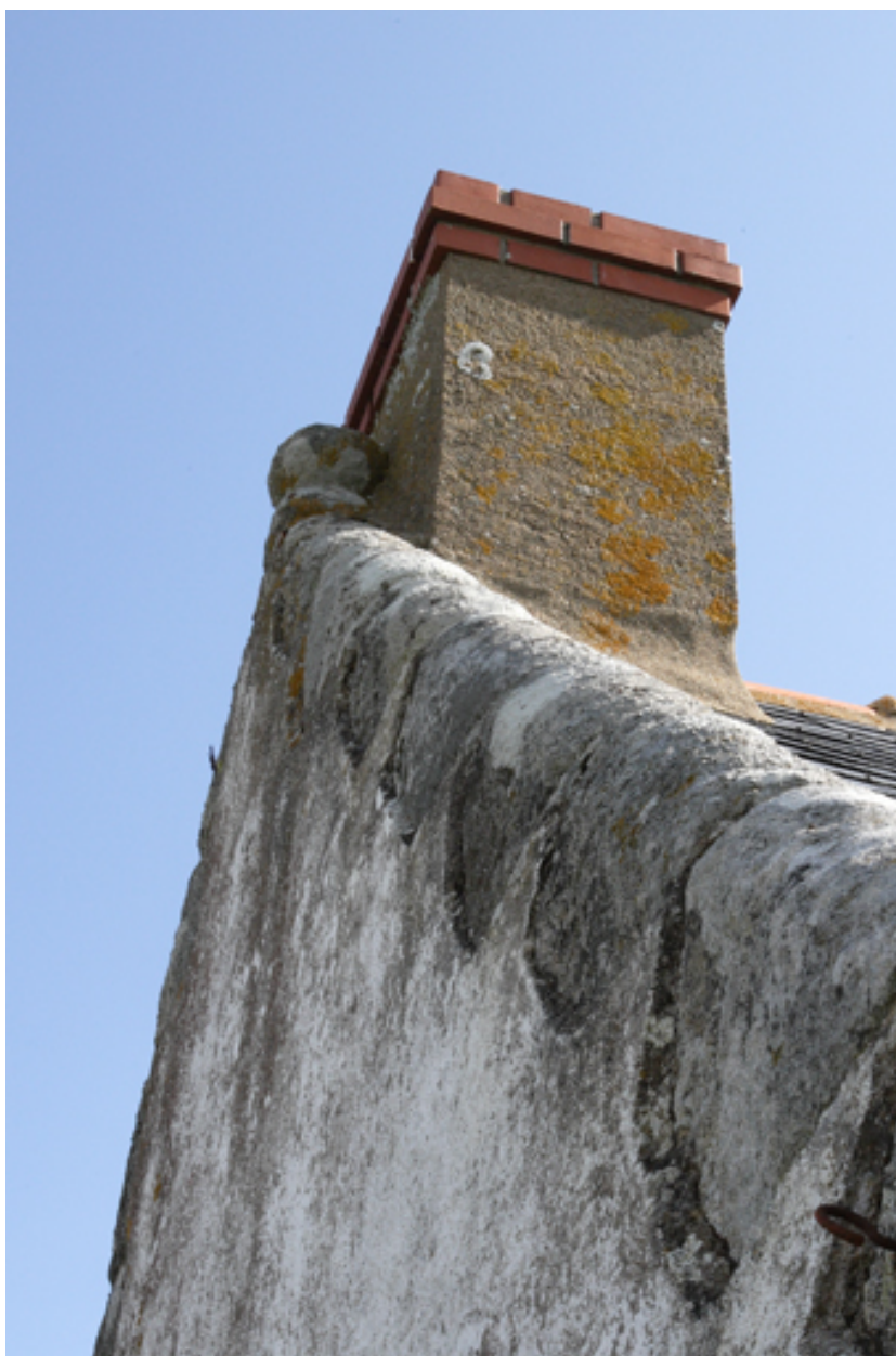
Logis. Partie centrale. Détail des rempants du pignon ouest.
