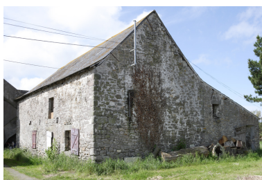
Dépendances. Vue de trois-quarts depuis le nord-est.
