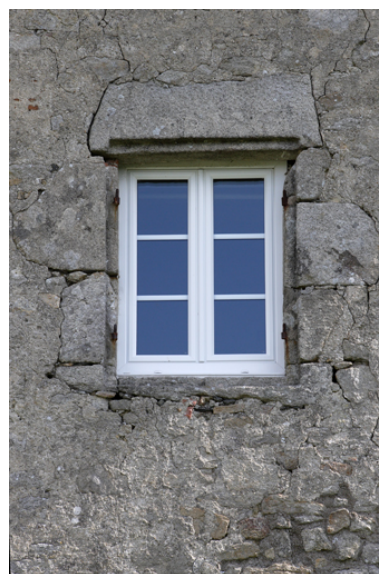
Logis. Façade sud. Partie centrale. Détail de la baie de droite du 2e niveau. Phot. Denis Pillet IVR52_20084401615NUCA
