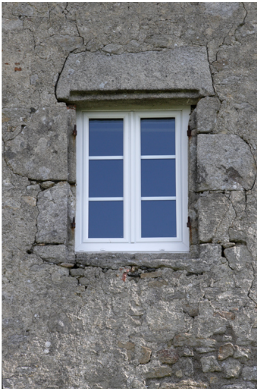
Logis. Façade sud. Partie centrale. Détail de la baie de droite du 2e niveau.
