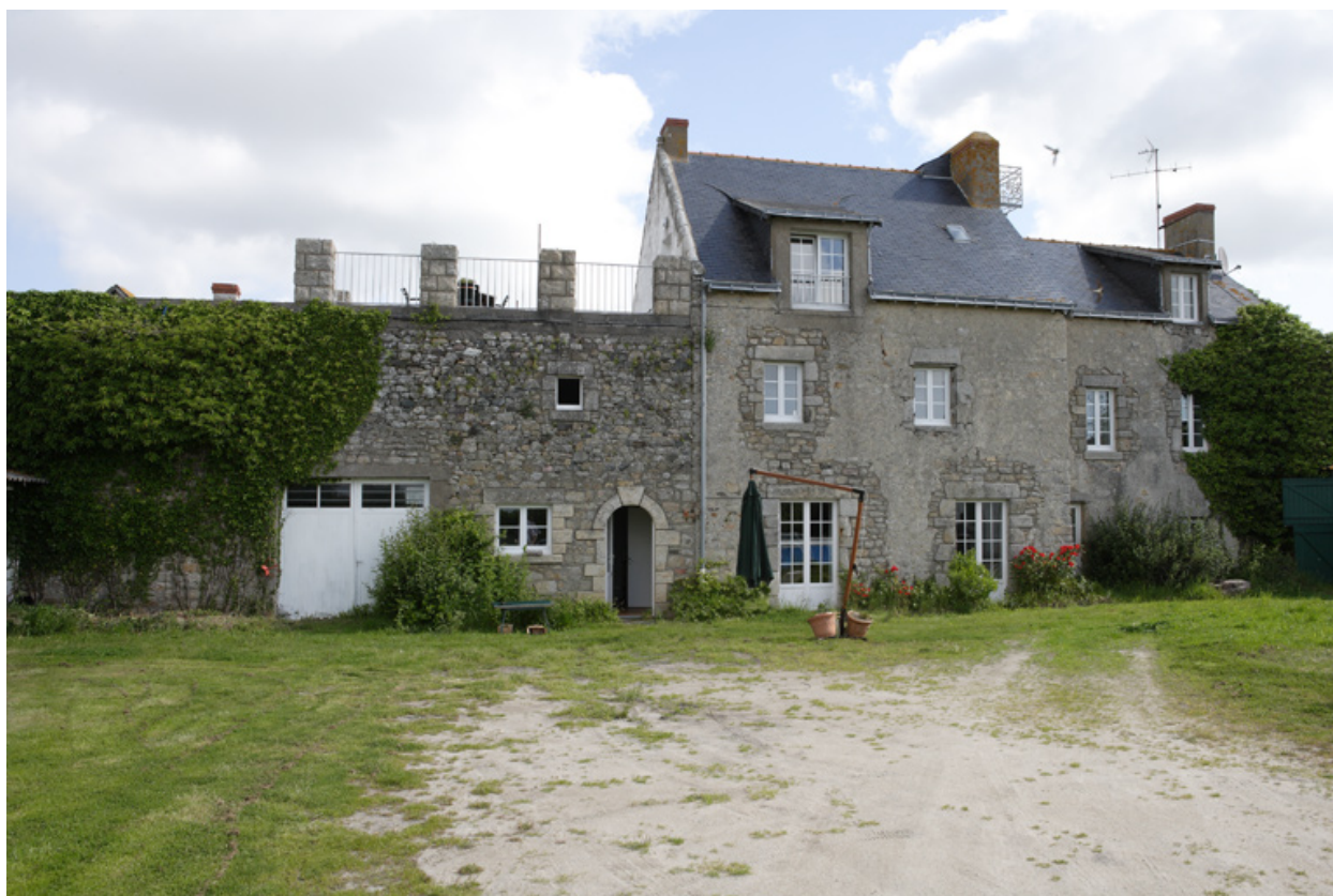
Logis. Façade sud.
