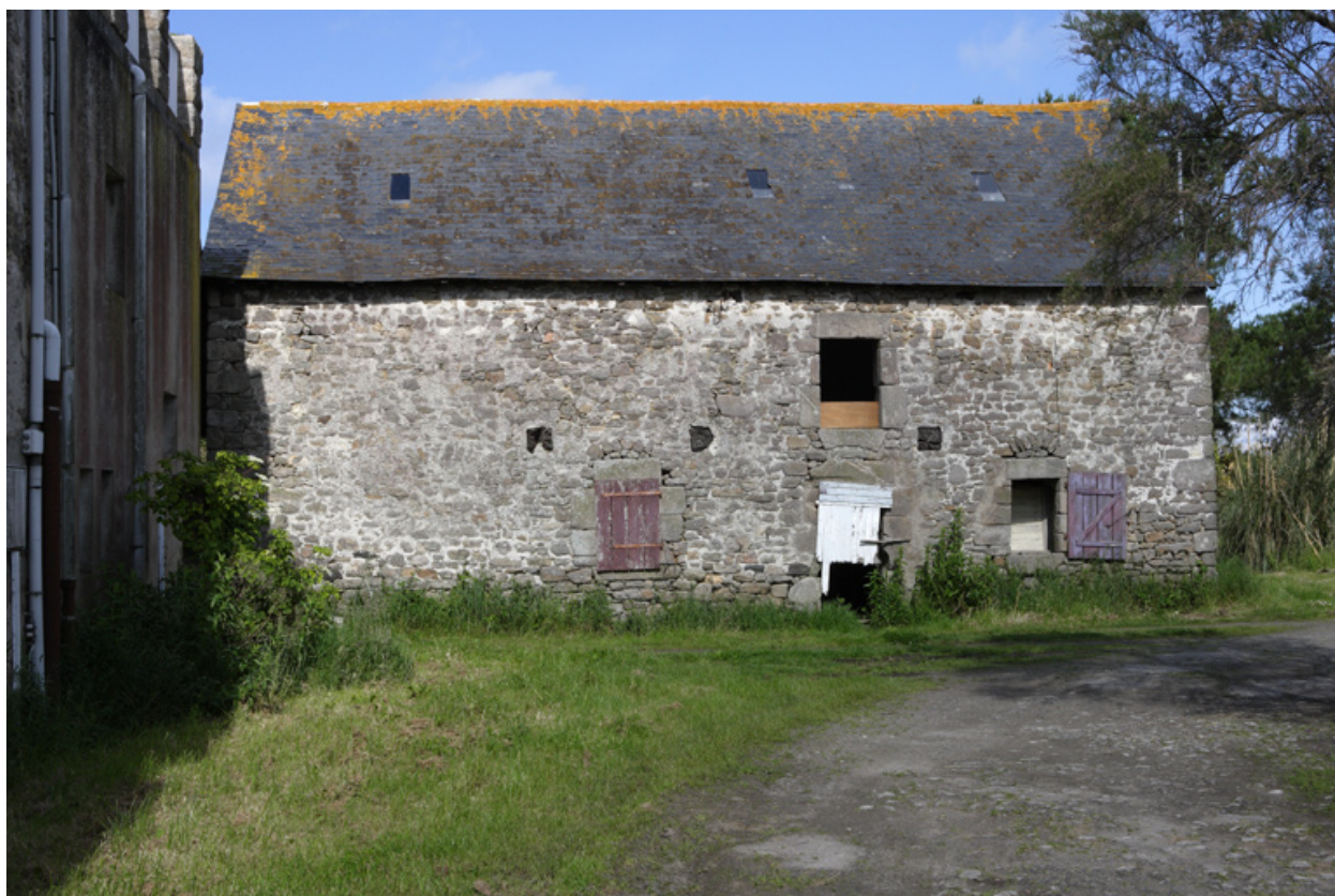
Dépendances. Vue de la façade est.
