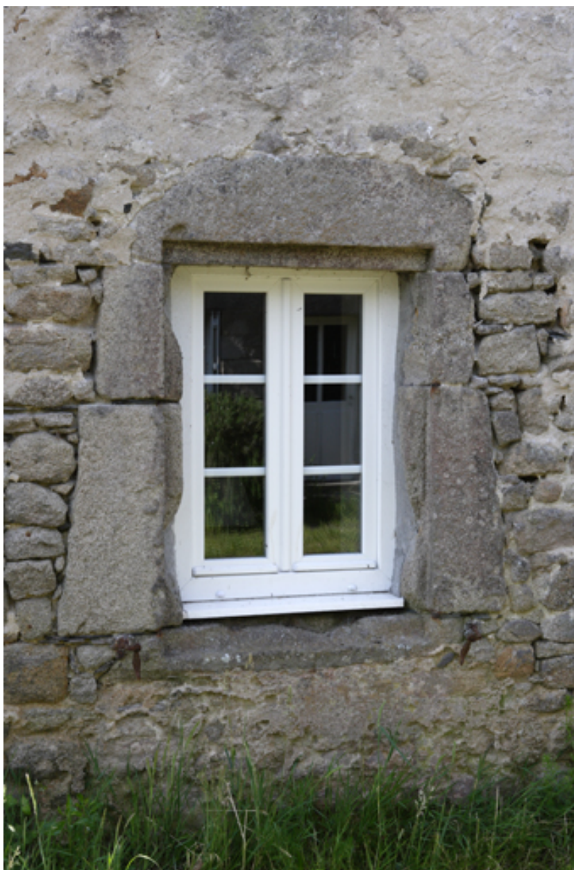
Logis. Façade nord. Partie est. Détail de la baie de gauche du rez-de-chaussée.
