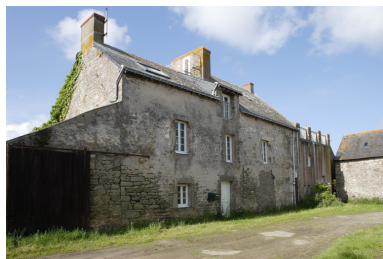
Logis. Vue de trois-quarts depuis le nord-est. Phot. Denis Pillet IVR52_20084401622NUCA
