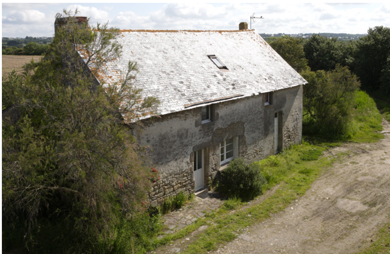
Logis du fermier. Vue depuis la terrasse.
