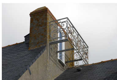
Logis. Détail du balcon aménagé sur le conduit de cheminée. Phot. Denis Pillet IVR52_20084401614NUCA
