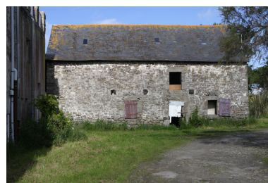
Dépendances. Vue de la façade est.
