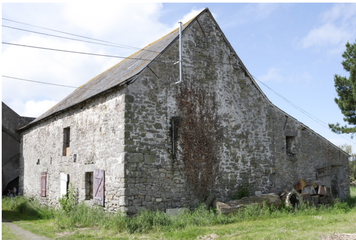
Dépendances. Vue de trois-quarts depuis le nord-est.
