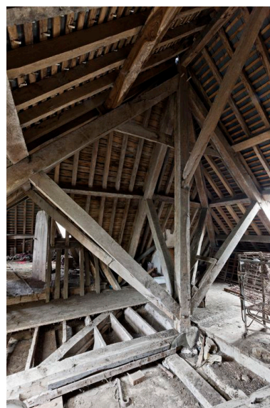
La charpente du château. Phot. Yves Guillotin IVR52_20125300162NUCA
