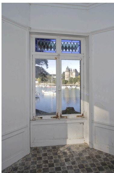
Vue intérieure du kiosque. Phot. Denis Pillet IVR52_20094401276NUCA
