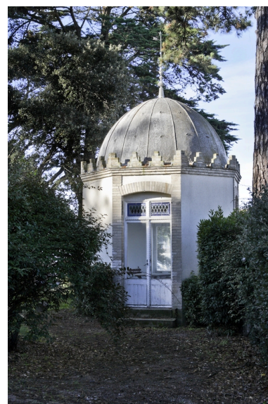
Entrée du kiosque, à l'est. Phot. Denis Pillet IVR52_20094401275NUCA
