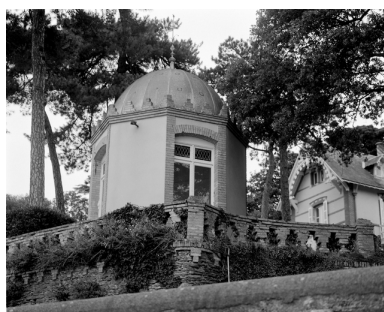
Vue de l'angle nord-ouest. Phot. Denis Pillet IVR52_19984401595X
