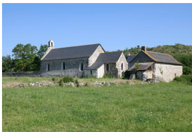
Vue d'ensemble depuis le sud-est, à gauche, la chapelle, et à droite, l'étable avec le fournil, prieuré de Châteaupanne. Phot. Armelle Maugin IVR52_20234900200NUCA
