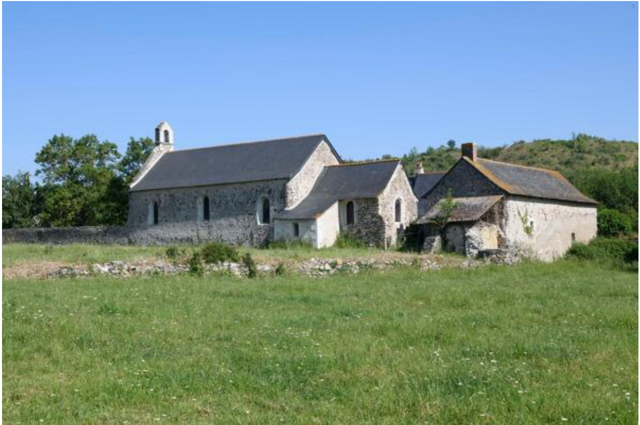
Vue d'ensemble depuis le sud-est, à gauche, la chapelle, et à droite, l'étable avec le fournil, prieuré de Châteaupanne.
