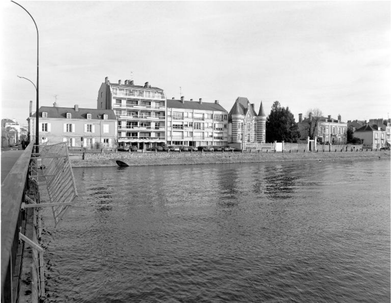
La partie aval du quai Béatrix-de-Gavre, située sur la rive gauche entre le pont de l'Europe et le pont Aristide-Briand, vue depuis le pont de l'Europe.
