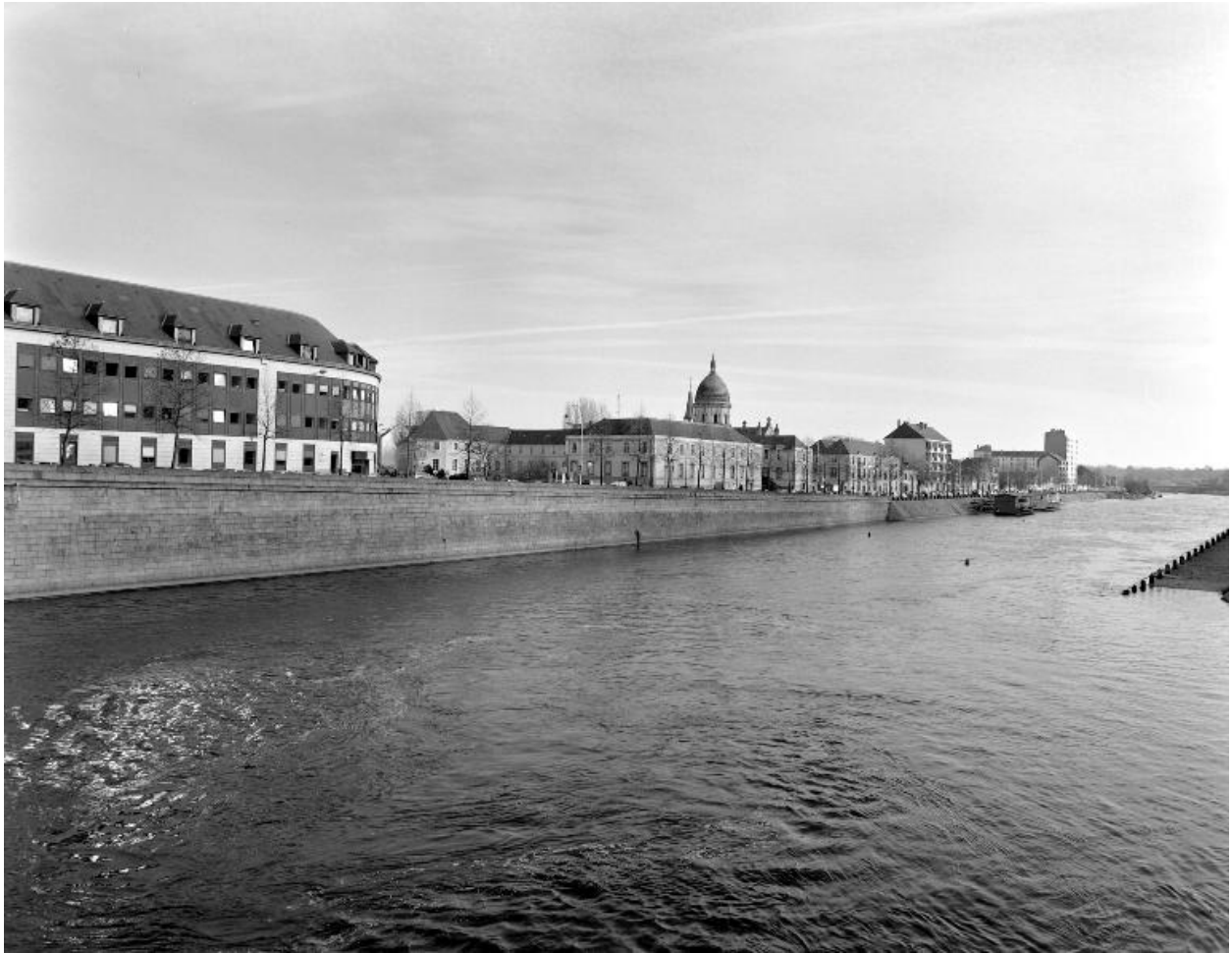
Le quai Paul-Boudet, situé sur la rive gauche entre le vieux pont et le pont d'Avénières, vu depuis le vieux pont.
