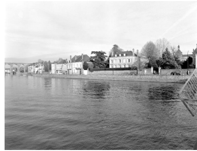
La partie amont du quai Béatrix-de-Gavre, située sur la rive gauche entre le viaduc et le pont de l'Europe, vue depuis ce dernier. Phot. François Lasa IVR52_20025301988X
