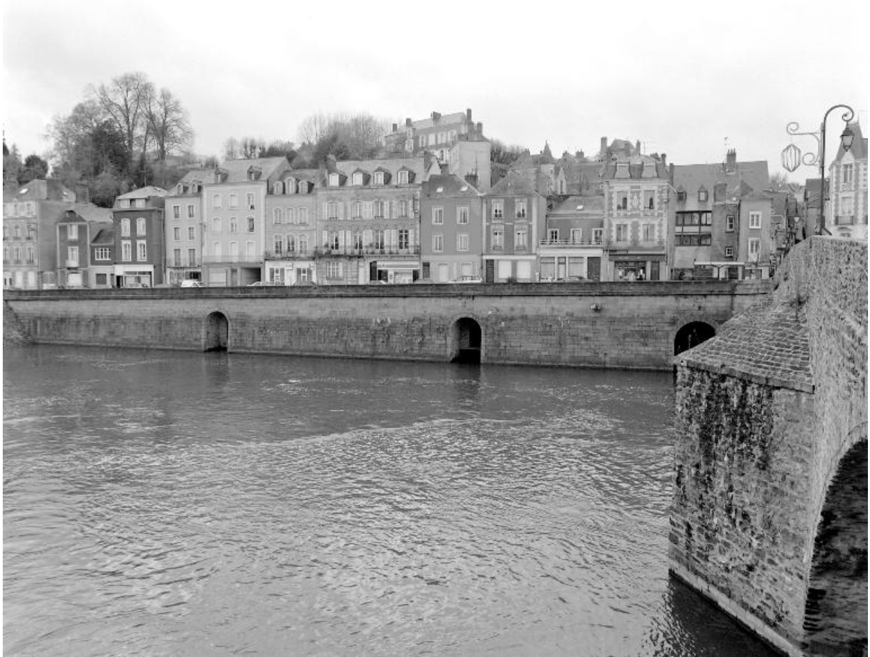
Le quai Albert-Goupil, situé sur la rive droite au sud du vieux pont. Partie amont vue depuis la rive gauche.
