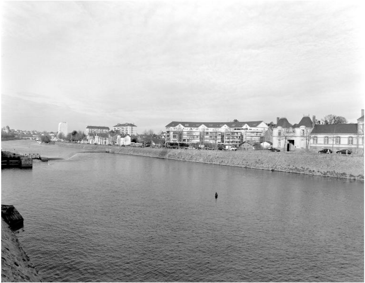
Le quai Paul-Boudet et le barrage d'Avénières, vus depuis le pont d'Avénières.
