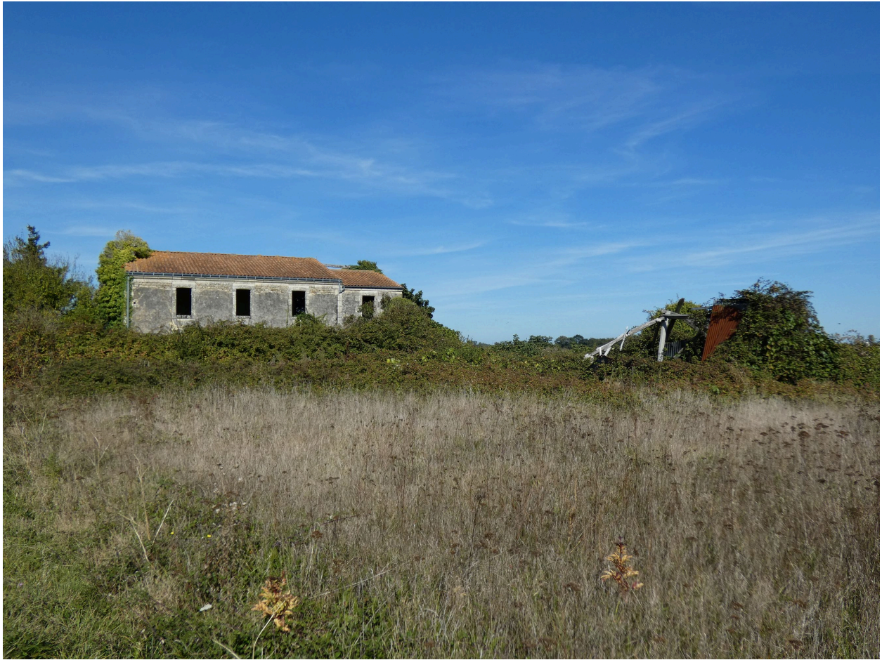
Les vestiges de la ferme vus depuis le sud-ouest.
