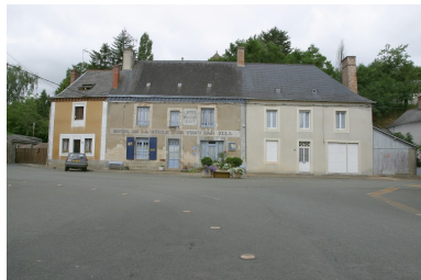
Façade sur la place (bâtiment de gauche). Phot. François Lasa IVR52_20035302371NUCA
