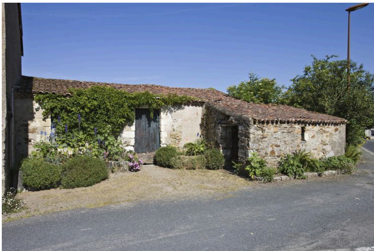
Vue générale des édifices, en bordure de voie.
