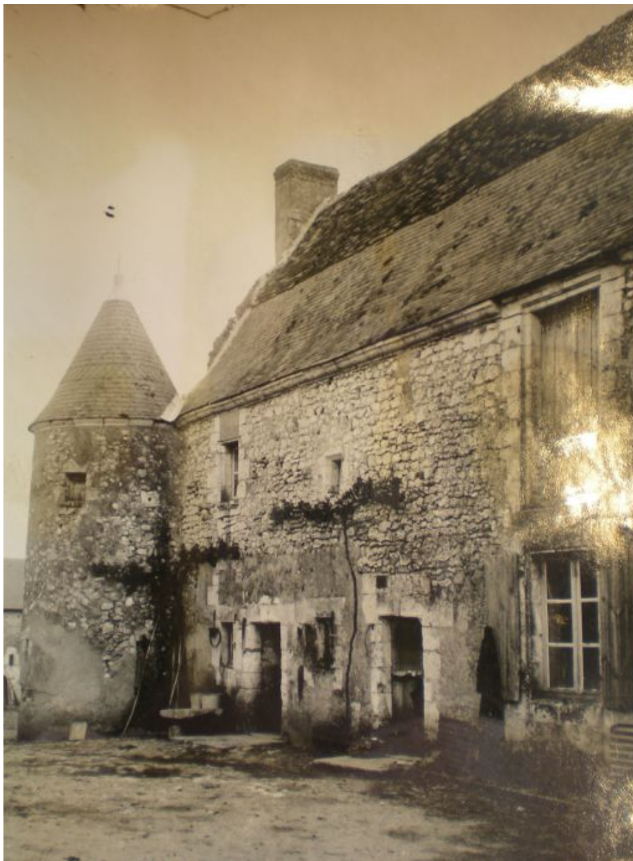
Façade antérieure, état avant restauration en 1948.
