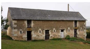
Les toits à porcs avec grenier (XIXe siècle). Phot. Jean-Baptiste Darrasse IVR52_20087202304NUCA
