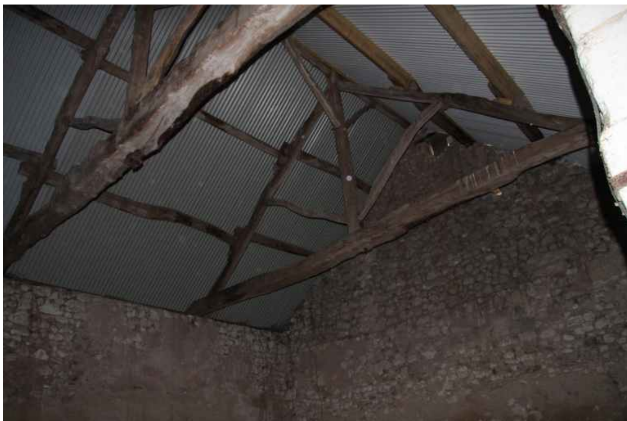
La grange : charpente à pannes.
