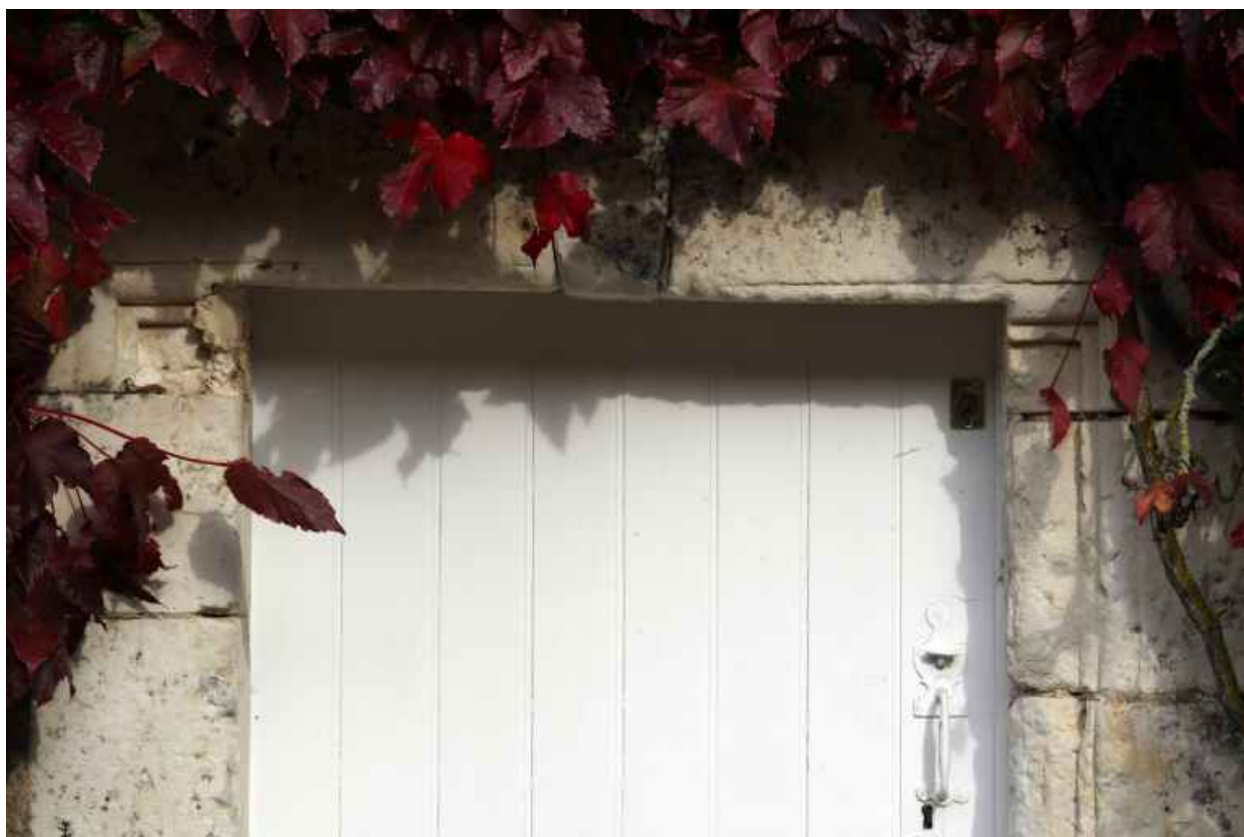
Le logis, porte d'entrée : moulures.
