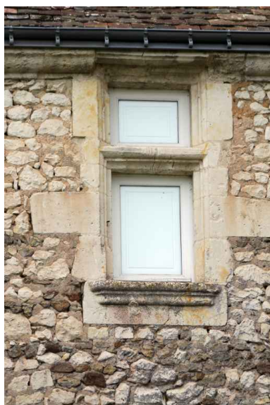
Le logis façade postérieure : demi-baie gauche. Phot. Jean-Baptiste Darrasse IVR52_20087202308NUCA
