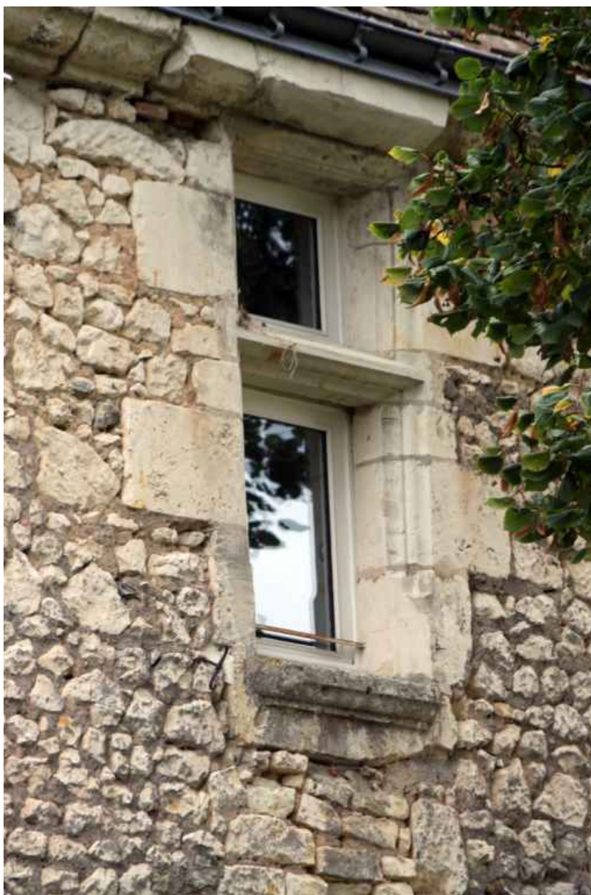
Le logis façade postérieure : demi-baie droite.
