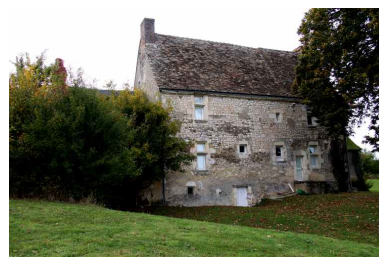
Le logis : façade postérieure. Phot. Jean-Baptiste Darrasse IVR52_20087202305NUCA
