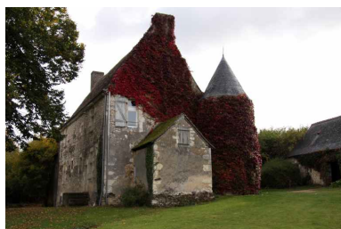
Le logis : vue de volume prise de la grange. Phot. Jean-Baptiste Darrasse IVR52_20087202310NUCA
