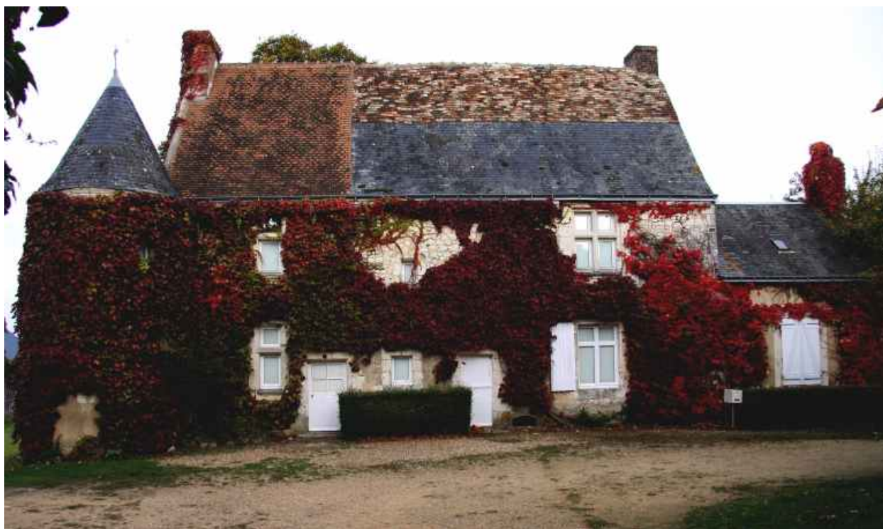
Le logis : façade antérieure.
