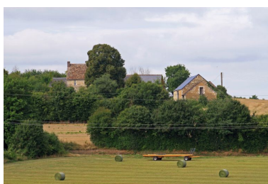
Vue d'ensemble prise de la route D215. Phot. Jean-Baptiste Darrasse IVR52_20087202029NUCA
