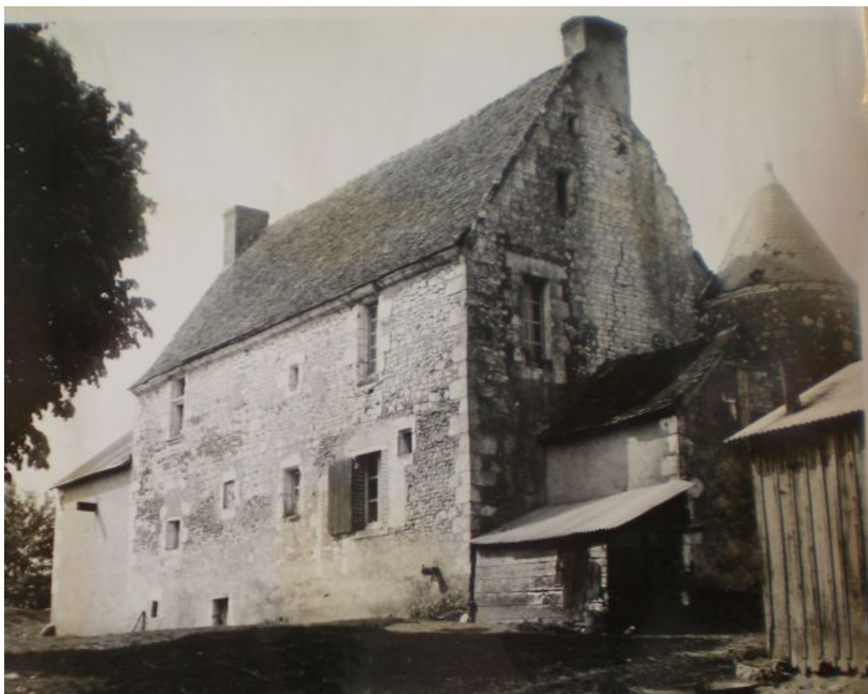
Façade postérieure avant restauration en 1948.
