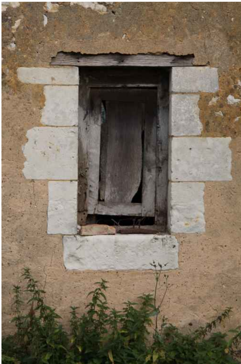
Les communs ouest : fenêtre de la chambre à cheminée remaniée.
