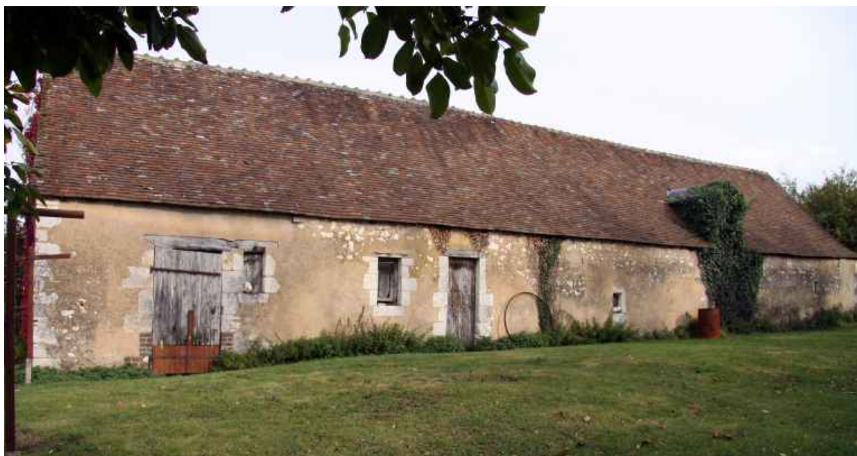
Les communs ouest : façade antérieure sur cour.
