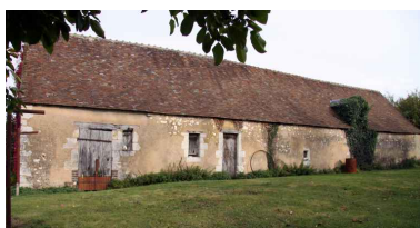
Les communs ouest : façade antérieure sur cour. Phot. Jean-Baptiste Darrasse IVR52_20087202313NUCA
