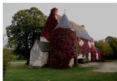
Le logis, vue de volume prise du nord : tourelle d'angle. Phot. Jean-Baptiste Darrasse IVR52_20087202312NUCA
