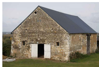
La grange : pignon remanié (abaissé et éventré). Phot. Jean-Baptiste Darrasse IVR52_20087202303NUCA
