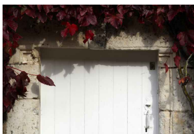
Le logis, porte d'entrée : moulures. Phot. Jean-Baptiste Darrasse IVR52_20087202302NUCA
