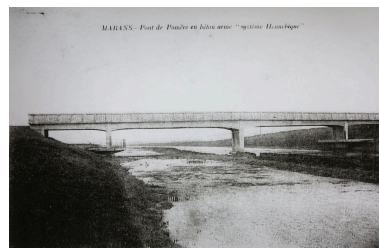
Le pont de type Hennebique construit en 1921. Phot. Yannis (reproduction) Suire IVR52_20198501113NUCA
