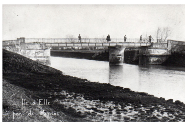
Le pont construit en 1871 par-dessus le barrage de 1841, en aval du pont actuel, vu vers 1920. Phot. Yannis (reproduction) Suire IVR52_20198501108NUCA
