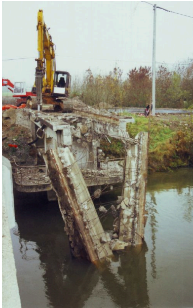
Démolition du pont en 1998. Phot. Yannis (reproduction) Suire IVR52_20198501002NUCA
