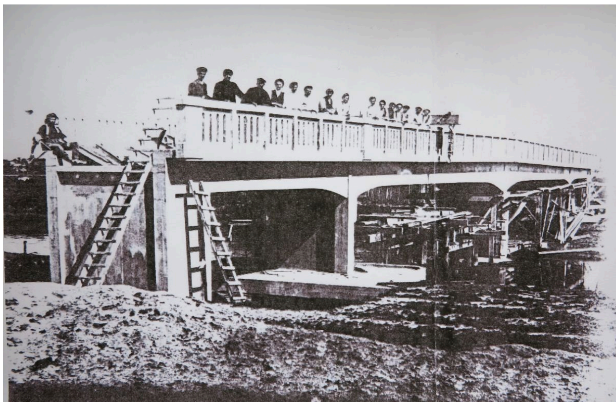
La construction du pont de type Hennebique en 1921-1922.
