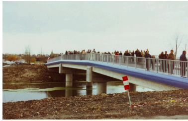
Inauguration du nouveau pont en 1998. Phot. Yannis (reproduction) Suire IVR52_20198501003NUCA
