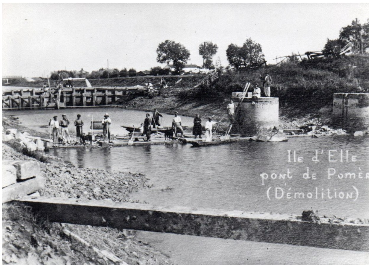
Démolition de l'ancien pont-barrage de 1841-1871 en 1924.
