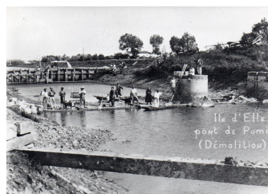
Démolition de l'ancien pont-barrage de 1841-1871 en 1924. Phot. Yannis (reproduction) Suire IVR52_20198501109NUCA
