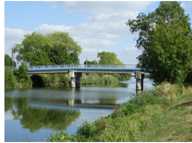
Le pont vu depuis la rive gauche d'aval, à l'ouest. Phot. Yannis Suire IVR52_20198500131NUCA
