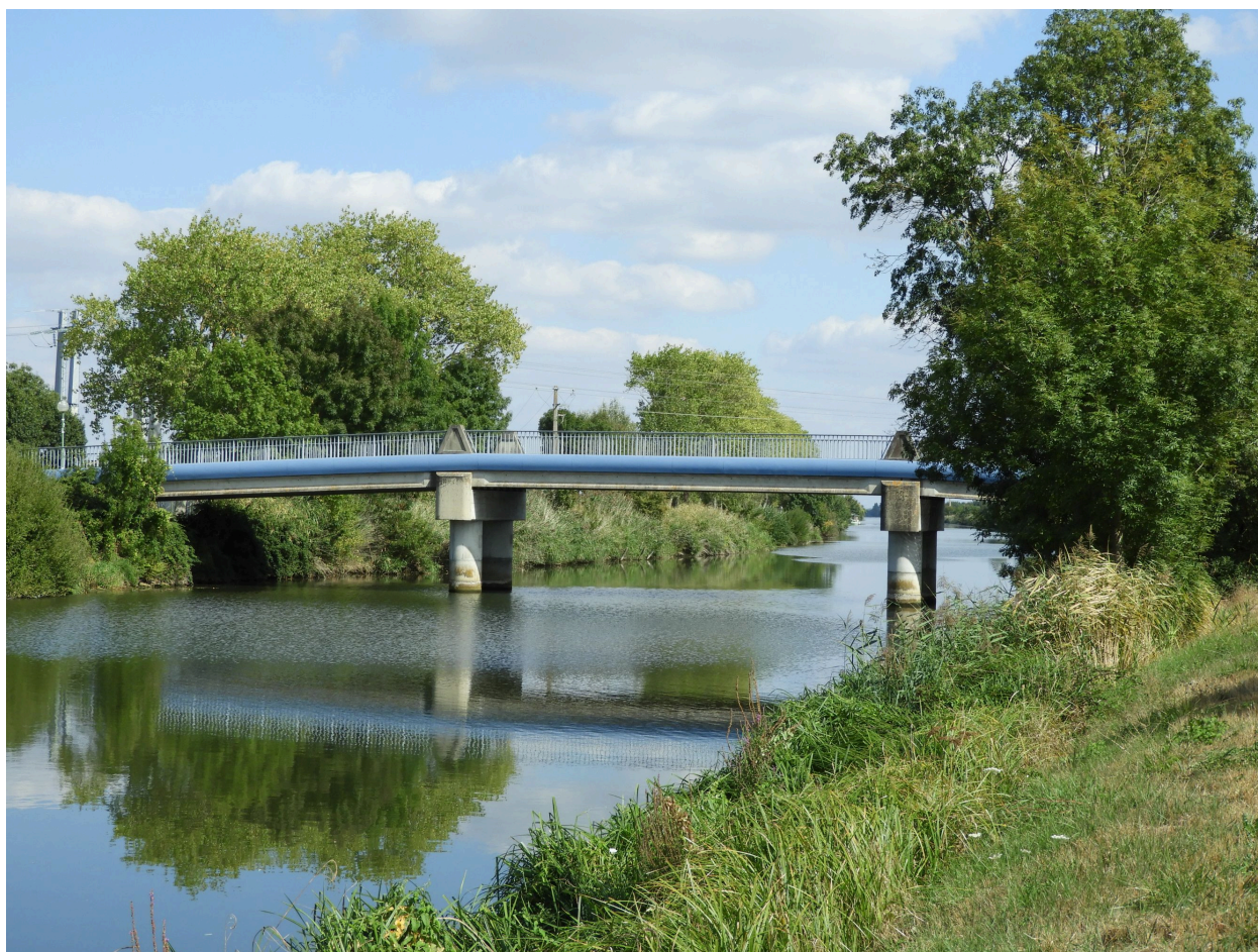
Le pont vu depuis la rive gauche d'aval, à l'ouest.
