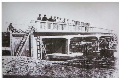
La construction du pont de type Hennebique en 1921-1922. Phot. Yannis (reproduction) Suire IVR52_20198501119NUCA
