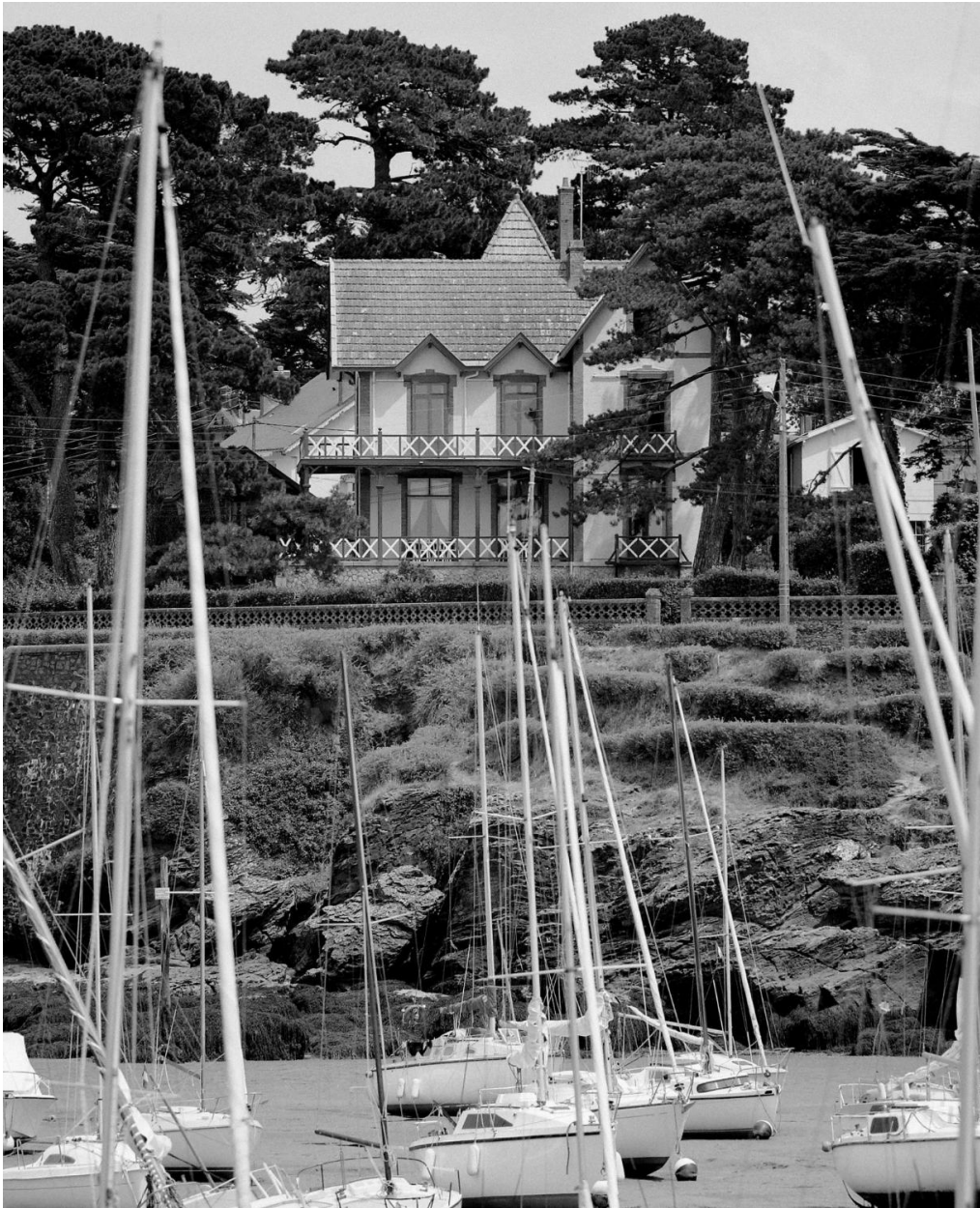
Elévation ouest de la villa.
