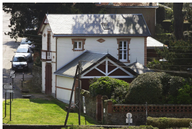
Dépendances au nord de la parcelle. Phot. Denis Pillet IVR52_20104400988NUCA
