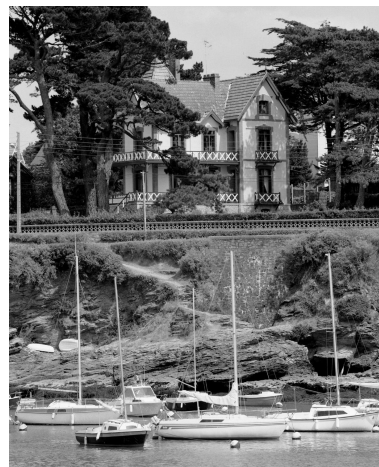
Elévation nord-est de la villa. Phot. Denis Pillet IVR52_19974402398X
