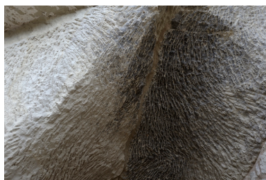
Abri troglodytique secondaire, en contrebas du site. Traces de pics de purge du ciel rocheux. Phot. Bruno Rousseau IVR52_20124901992NUCA
