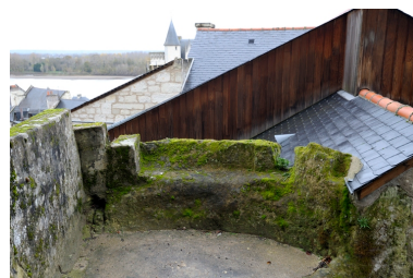
Plate-forme en belvédère, taillée dans le coteau, au-devant de l'entrée de l'abri troglodytique. Phot. Bruno Rousseau IVR52_20124901969NUCA
