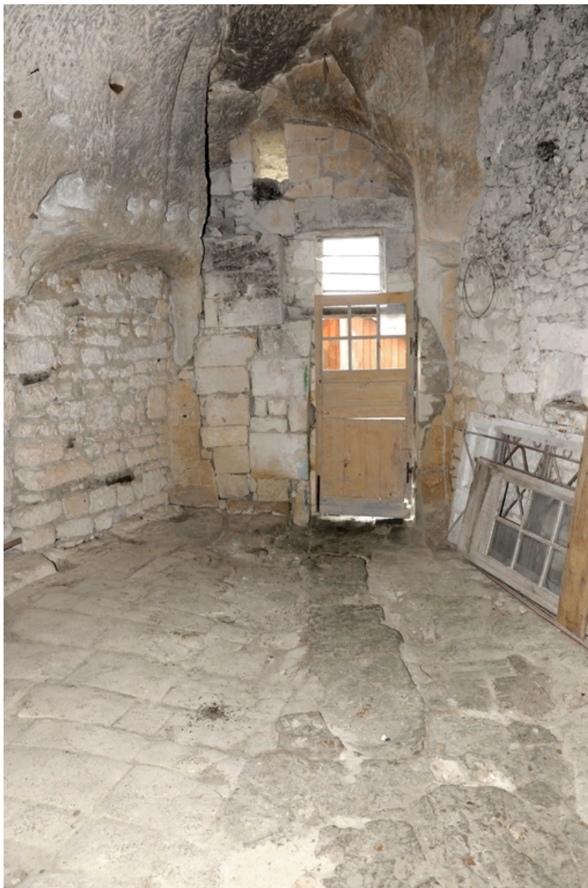
Salle centrale de l'abri troglodytique. Vue intérieure.
