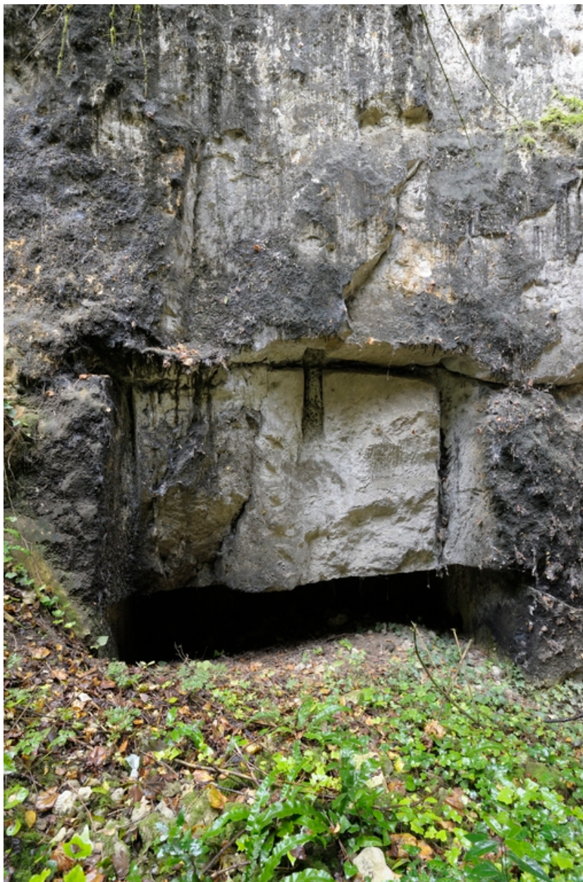
Fontis en partie postérieure de l'abri troglodytique. Vestige d'exploitation de tuffeau par saignées larges.
