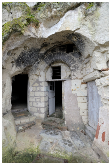
Entrée de l'abri troglodytique. Phot. Bruno Rousseau IVR52_20124901963NUCA
