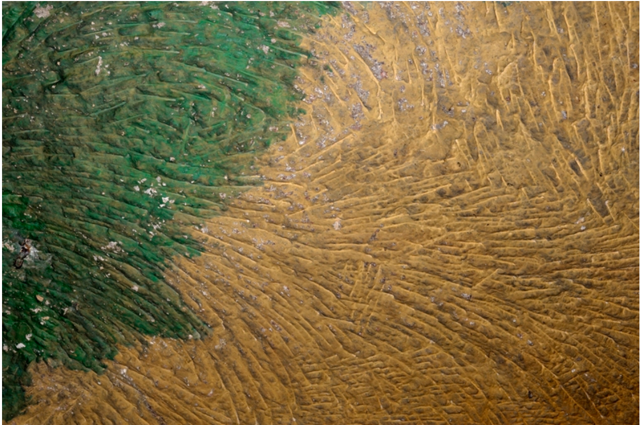
Abri troglodytique secondaire, en contrebas du site. Traces de pics de purge du ciel rocheux (3).
