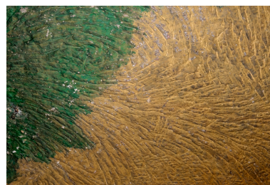
Abri troglodytique secondaire, en contrebas du site. Traces de pics de purge du ciel rocheux (3). Phot. Bruno Rousseau IVR52_20124901995NUCA
