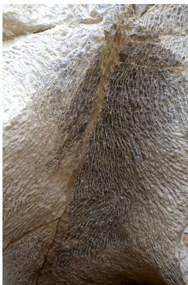
Abri troglodytique secondaire, en contrebas du site. Traces de pics de purge du ciel rocheux (2). Phot. Bruno Rousseau IVR52_20124901993NUCA
