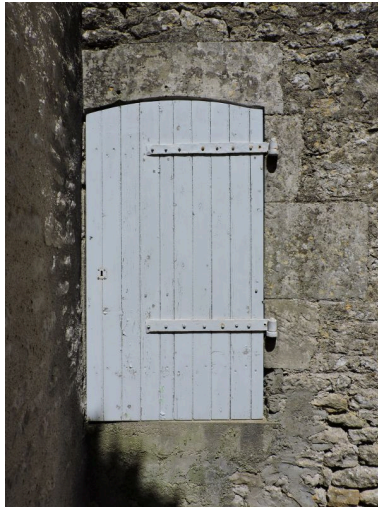
Baie à linteau en arc segmentaire (18e siècle ?) de l'ancienne sacristie. Phot. Yannis Suire IVR52_20198501289NUCA
