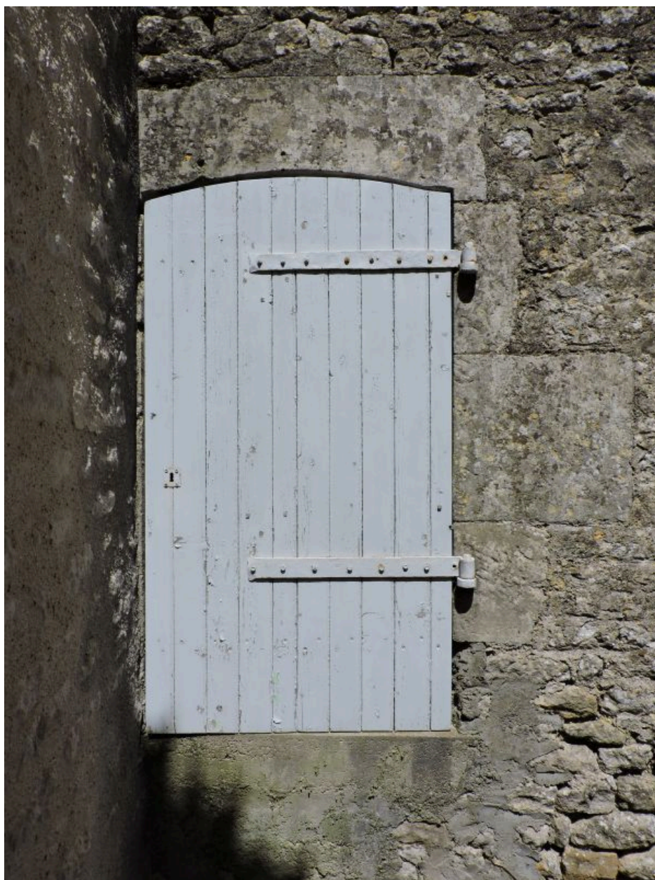
Baie à linteau en arc segmentaire (18e siècle ?) de l'ancienne sacristie.
