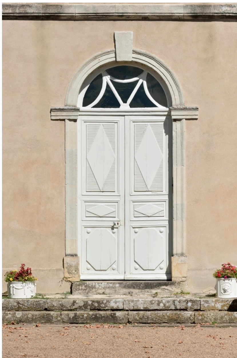
Façade sud. Détail de la porte d'entrée.
