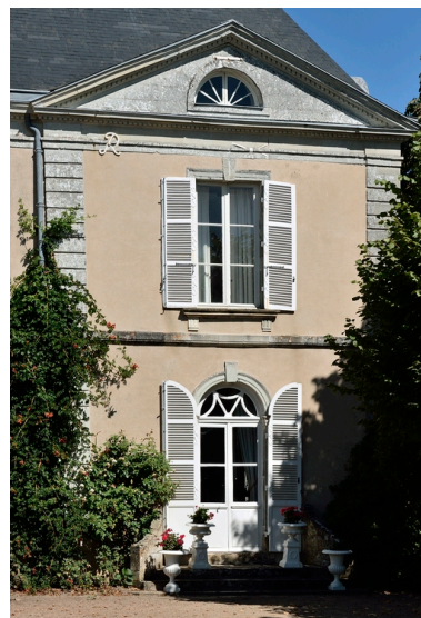
Façade sud. Détail de l'avant-corps est. Phot. Bruno Rousseau IVR52_20164901182NUCA
