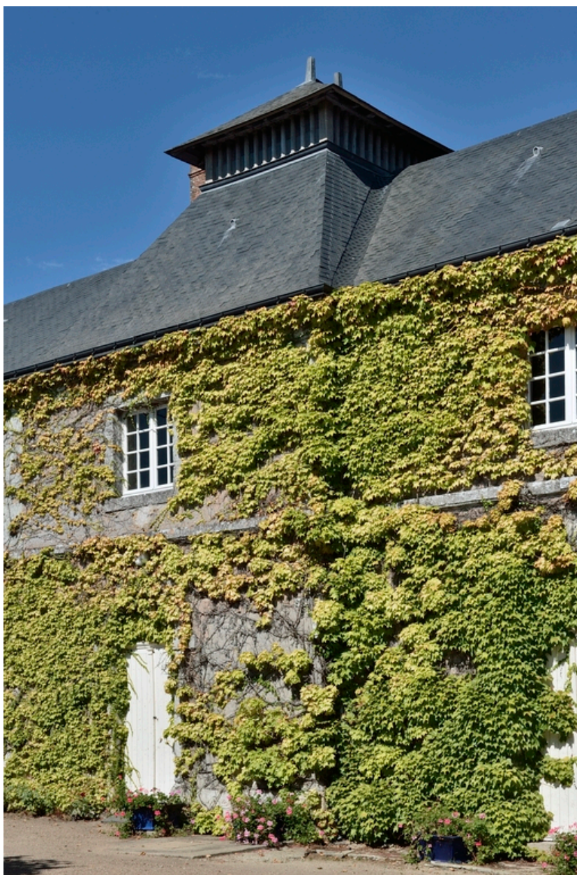
Chai. Façade sud. Détail du belvédère.
