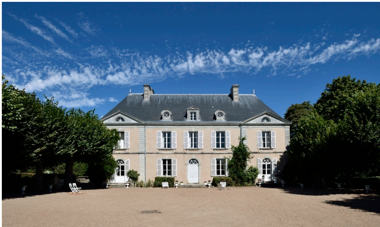
Vue de la façade sud.
