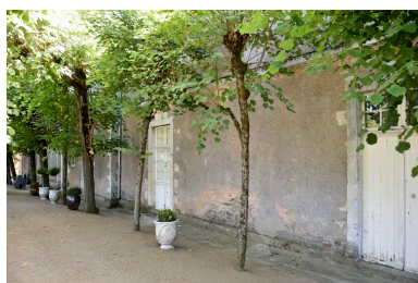
Chai. Façade nord. Détail. Phot. Bruno Rousseau IVR52_20164901210NUCA
