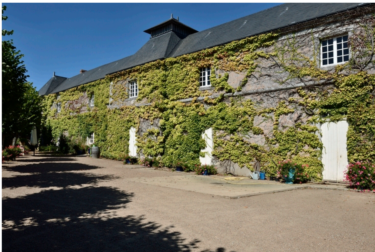
Chai. Vue de la façade sud.
