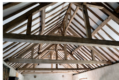
Chai. Détail de la charpente. Phot. Bruno Rousseau IVR52_20164901216NUCA
