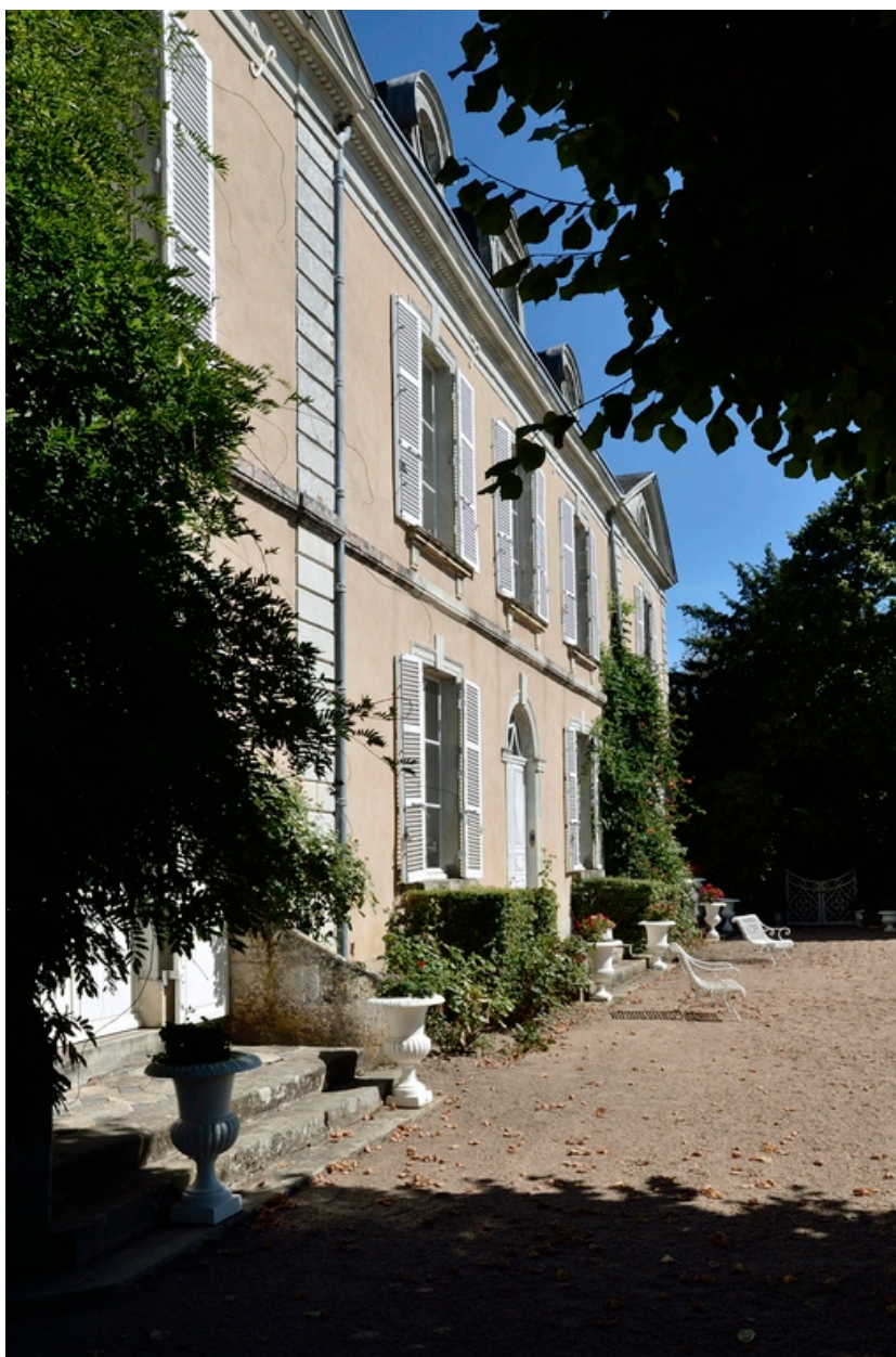
Vue de la façade depuis le sud-ouest.
