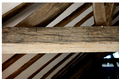
Chai. Charpente. Détail d'une marque de charpentier. Phot. Bruno Rousseau IVR52_20164901217NUCA
