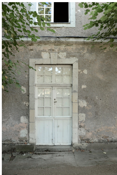
Chai. Détail d'une porte. Phot. Bruno Rousseau IVR52_20164901208NUCA
