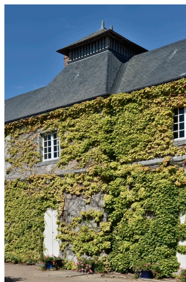
Chai. Façade sud. Détail du belvédère. Phot. Bruno Rousseau IVR52_20164901204NUCA
