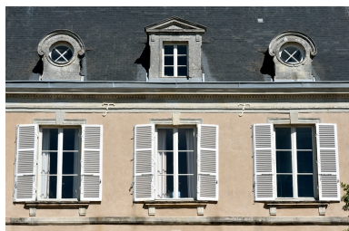
Façade sud. Détail des baies de l'étage et du comble. Phot. Bruno Rousseau IVR52_20164901181NUCA
