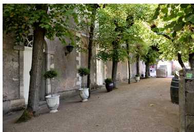
Vue de l'allée longeant la façade nord du chai. Phot. Bruno Rousseau IVR52_20164901207NUCA
