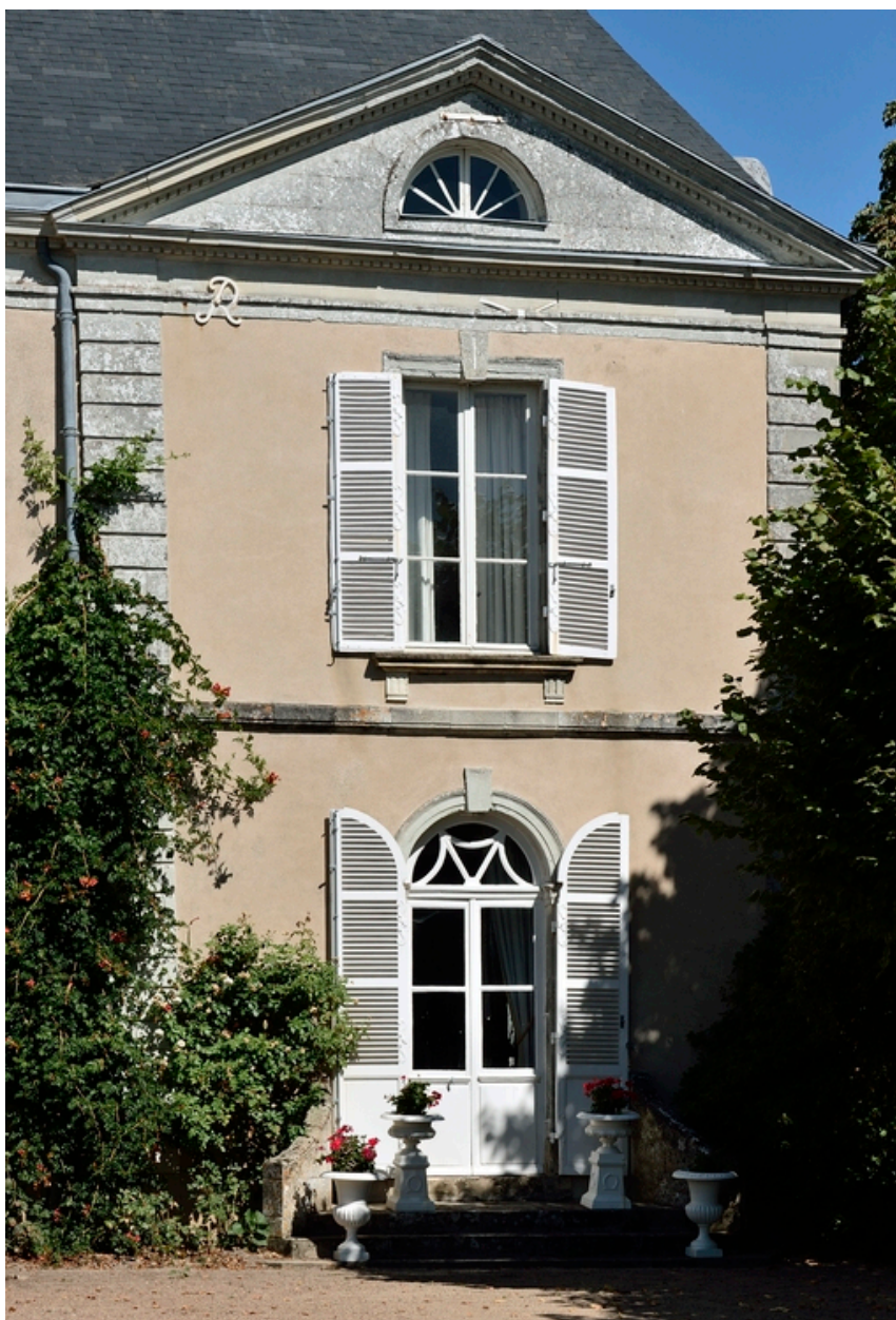
Façade sud. Détail de l'avant-corps est.
