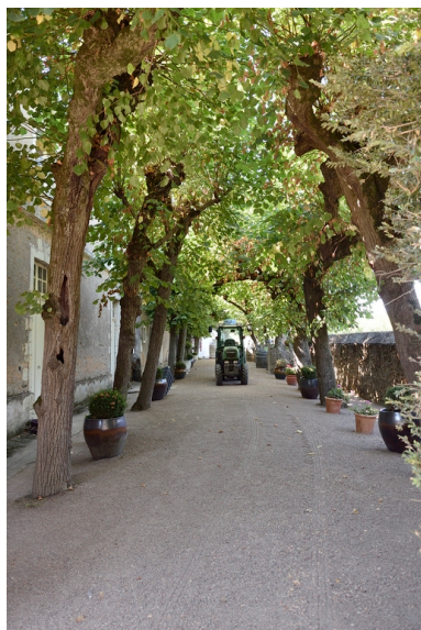
Vue de l'allée longeant la façade nord du chai. Phot. Bruno Rousseau IVR52_20164901206NUCA
