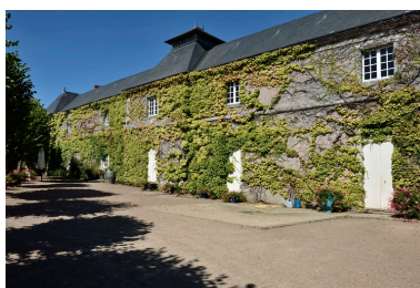
Chai. Vue de la façade sud. Phot. Bruno Rousseau IVR52_20164901203NUCA
