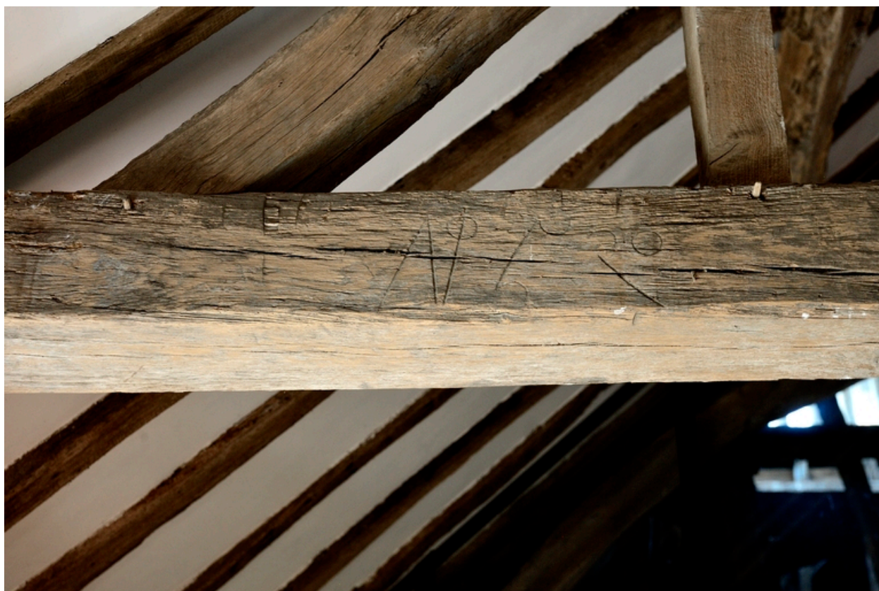
Chai. Charpente. Détail d'une marque de charpentier.
