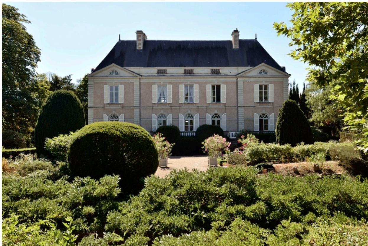
Vue de la façade nord.
