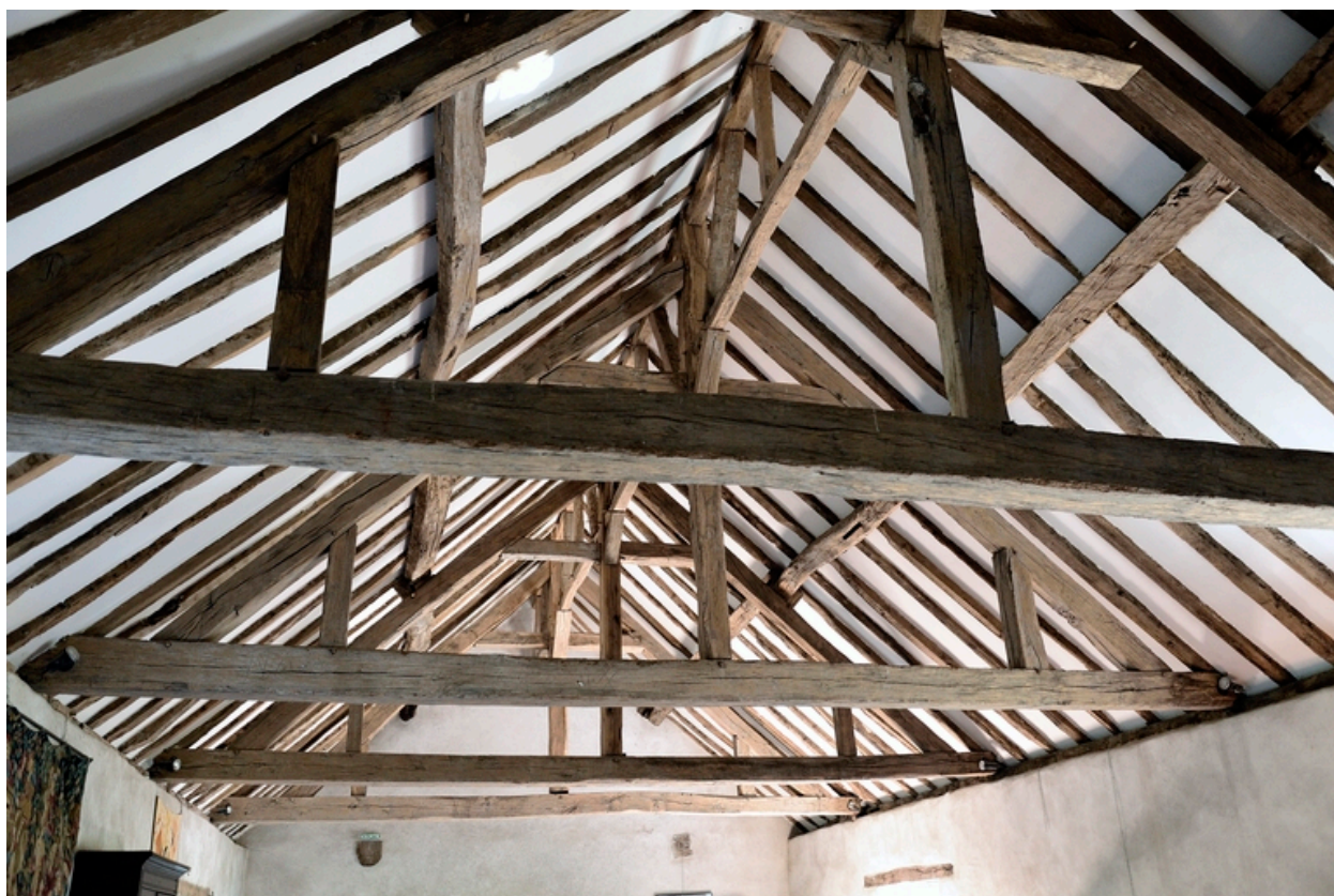
Chai. Détail de la charpente.
