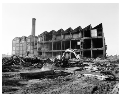
Nouvelle usine. Chaufferie, centrale électrique et casserie en cours de démolition, vues de l'est. Phot. Jacques Le Callonnec IVR52_19784401387X
