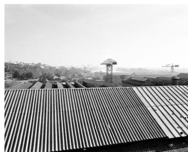
Vue des toits vers le sud-est depuis le 6e étage du bâtiment de fabrication central. Phot. Jacques Le Callonnec IVR52_19784401346X
