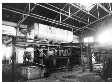
Nouvelle usine. Bâtiment non précisé. Fabrication des sucres granulés. Malaxeur en place. Phot. Jacques Le Callonnec IVR52_19784401373X
