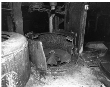
Nouvelle usine. Bâtiment, atelier et étage non localisé. Machine à essorer la masse cuite dite turbine Mollet-Fontaine découpée. Phot. Jacques Le Callonnec IVR52_19784401386X
