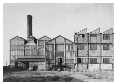
Nouvelle usine. Façades est de la chaufferie, de la centrale électrique et de la casserie, vues de l'est. Phot. Jacques Le Callonnec IVR52_19784401366X
