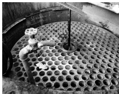
Nouvelle usine. Bâtiment central, 6e étage. Chaudières à clarifier. Détail des faisceaux. Phot. Jacques Le Callonnec IVR52_19784401380X
