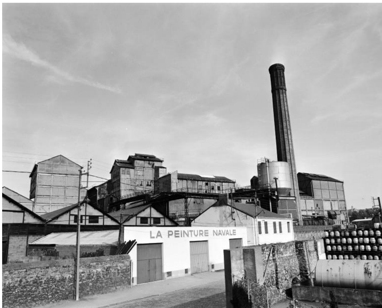
Nouvelle usine vue du sud.
