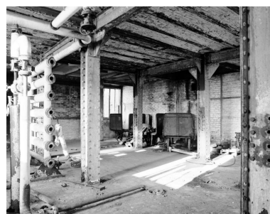
Nouvelle usine. Bâtiment non localisé. Atelier de décoloration sur résine. Vue d'ensemble. Phot. Jacques Le Callonnec IVR52_19784401385X
