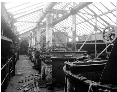
Nouvelle usine. Bâtiment central, 6e étage. Chaudières à clarifier. Phot. Jacques Le Callonnec IVR52_19784401379X
