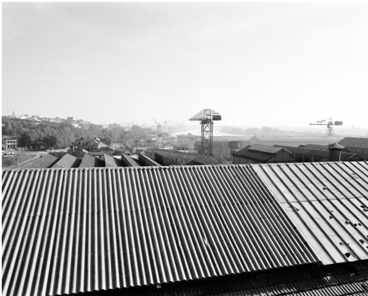
Vue des toits vers le sud-est depuis le 6e étage du bâtiment de fabrication central.
