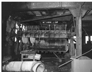
Nouvelle usine. Bâtiment et étage non localisés. Filtre-presse. Phot. Jacques Le Callonnec IVR52_19784401377X
