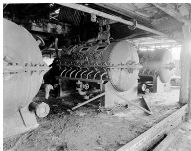
Nouvelle usine. Bâtiment et étage non localisés. Filtres à tambour pour le désucrage des tourteaux. Phot. Jacques Le Callonnec IVR52_19784401383X
