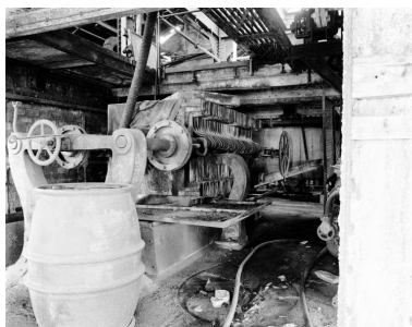
Nouvelle usine. Bâtiment et étage non localisés. Filtre-presse. Phot. Jacques Le Callonnec IVR52_19784401382X
