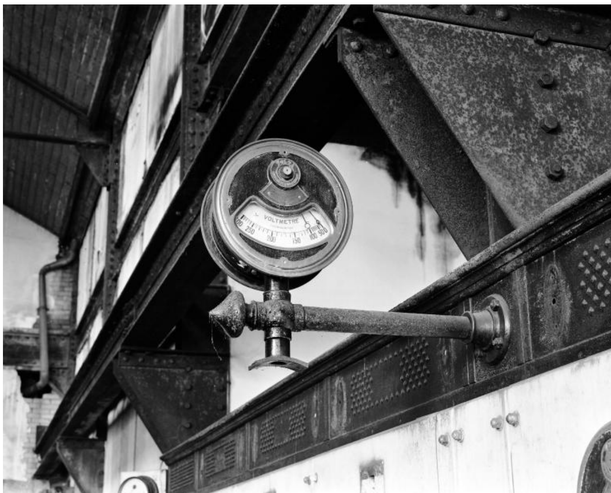
Nouvelle usine. Centrale électrique. Voltmètre Volta.
