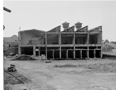
Partie ancienne de l'usine (ouest). Bâtiment de fabrication du sucre candi et cartonnerie partiellement démolis. Phot. Jacques Le Callonnec IVR52_19784401328X
