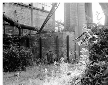
Nouvelle usine. Base de la cheminée industrielle de la chaufferie. Phot. Jacques Le Callonnec IVR52_19784401336X
