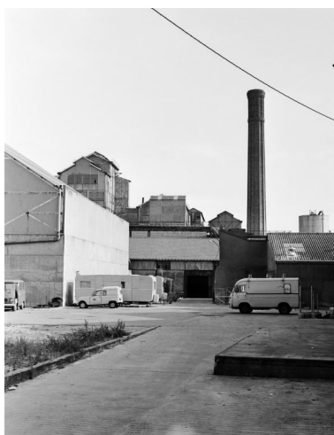
Entrée de l'usine sur le boulevard de Chantenay. Phot. Jacques Le Callonnec IVR52_19784401347X
