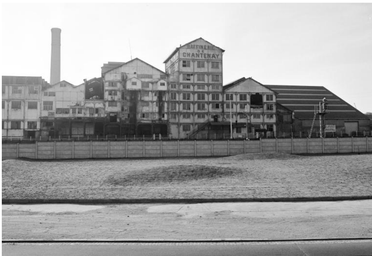
Nouvelle usine. Façades nord des bâtiments de fabrication vues de la rue Jules-Launay.
