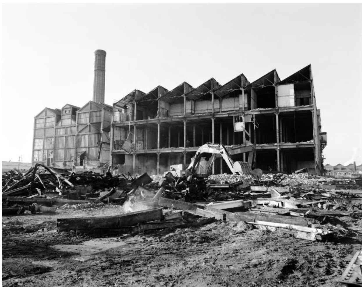
Nouvelle usine. Chaufferie, centrale électrique et casserie en cours de démolition, vues de l'est.
