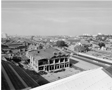
Vestige de la partie ancienne de l'usine. Bâtiment de fabrication du sucre candi et cartonnerie vus depuis le 6e étage du bâtiment central. Le permis de construire de la partie gauche a été déposée en 1921 sous le nom de bâtiment de l'Intensif. Phot. Jacques Le Callonnec IVR52_19784401343X
