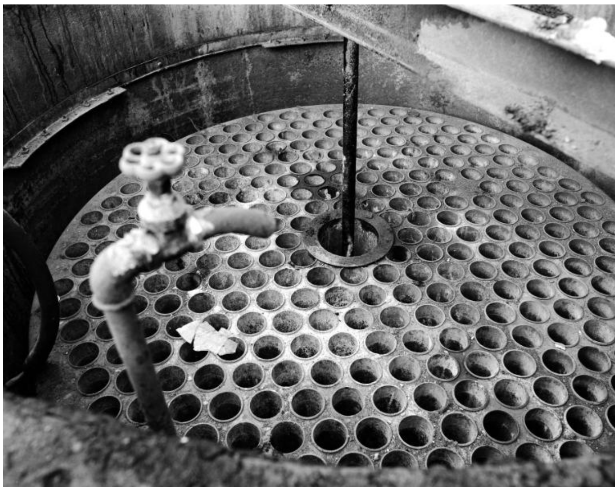
Nouvelle usine. Bâtiment central, 6e étage. Chaudières à clarifier. Détail des faisceaux.
