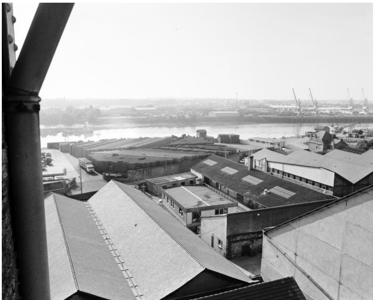
Vue de la Loire et des chantiers navals vers l'amont depuis le 6e étage du bâtiment de fabrication central
