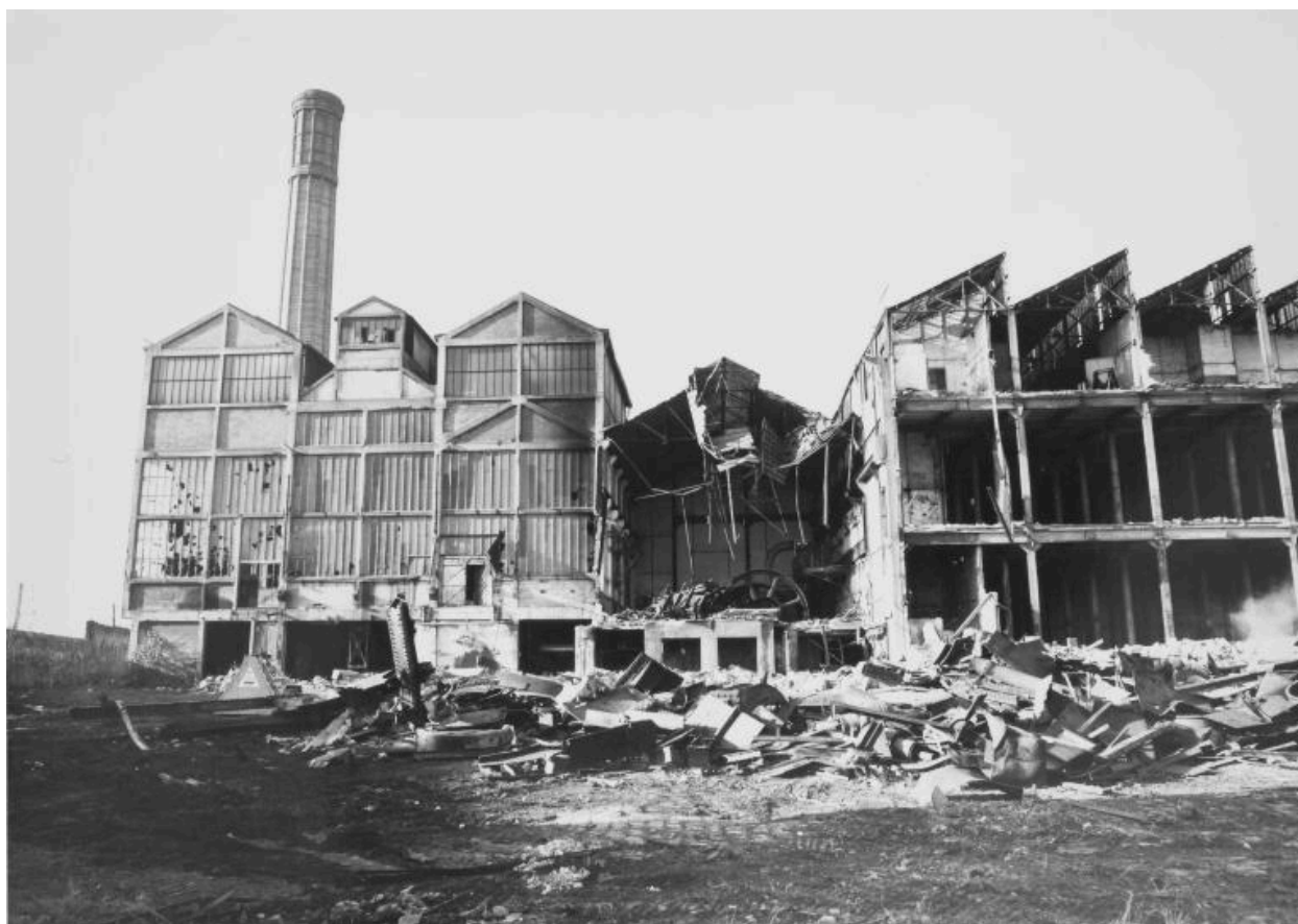
Nouvelle usine. Chaufferie, centrale électrique et casserie partiellement démolies, vues de l'est.
