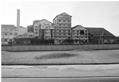
Nouvelle usine. Façades nord des bâtiments de fabrication vues de la rue Jules-Launay. Phot. Jacques Le Callonnec IVR52_19784401330X
