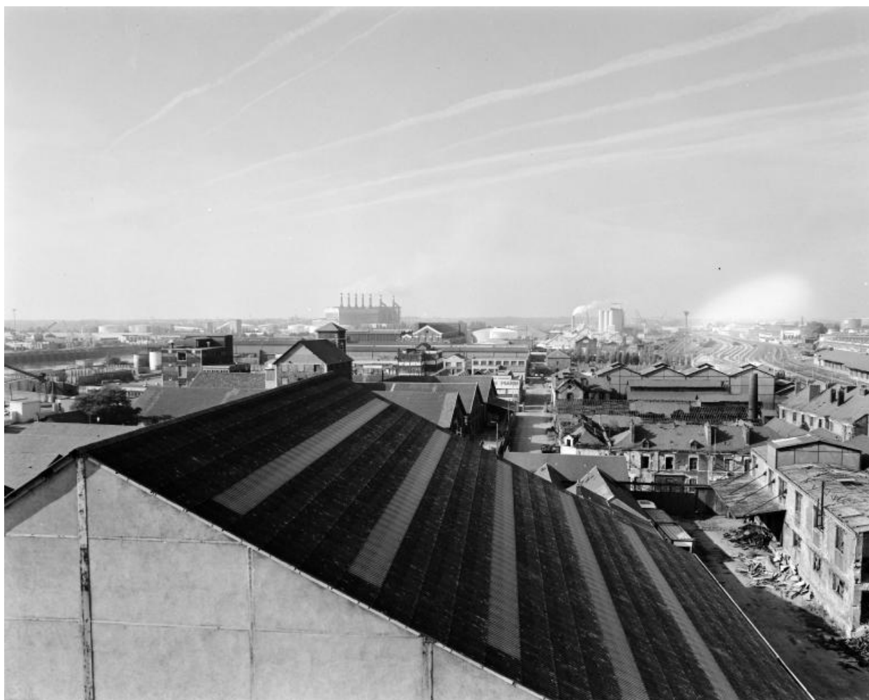
Vue du paysage vers l'aval depuis le 6e étage du bâtiment de fabrication centrall, avec la centrale de Cheviré à l'horizon.
