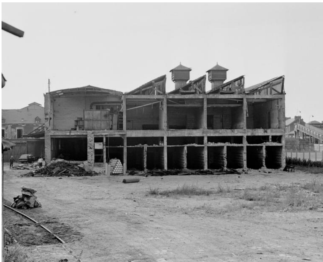
Partie ancienne de l'usine (ouest). Bâtiment de fabrication du sucre candi et cartonnerie partiellement démolis.
