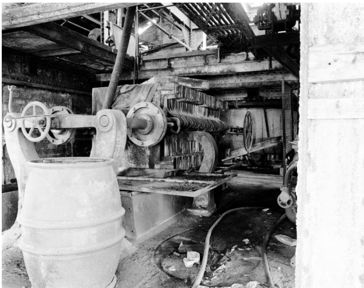
Nouvelle usine. Bâtiment et étage non localisés. Filtre-presse.
