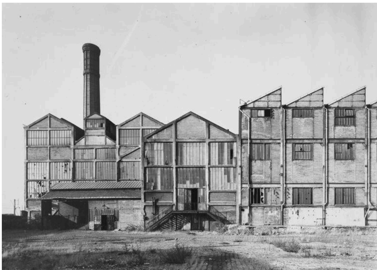
Nouvelle usine. Façades est de la chaufferie, de la centrale électrique et de la casserie, vues de l'est.
