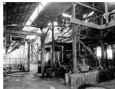
Nouvelle usine. Bâtiment central. 5e étage : réservoirs à sirop. Phot. Jacques Le Callonnec IVR52_19784401378X
