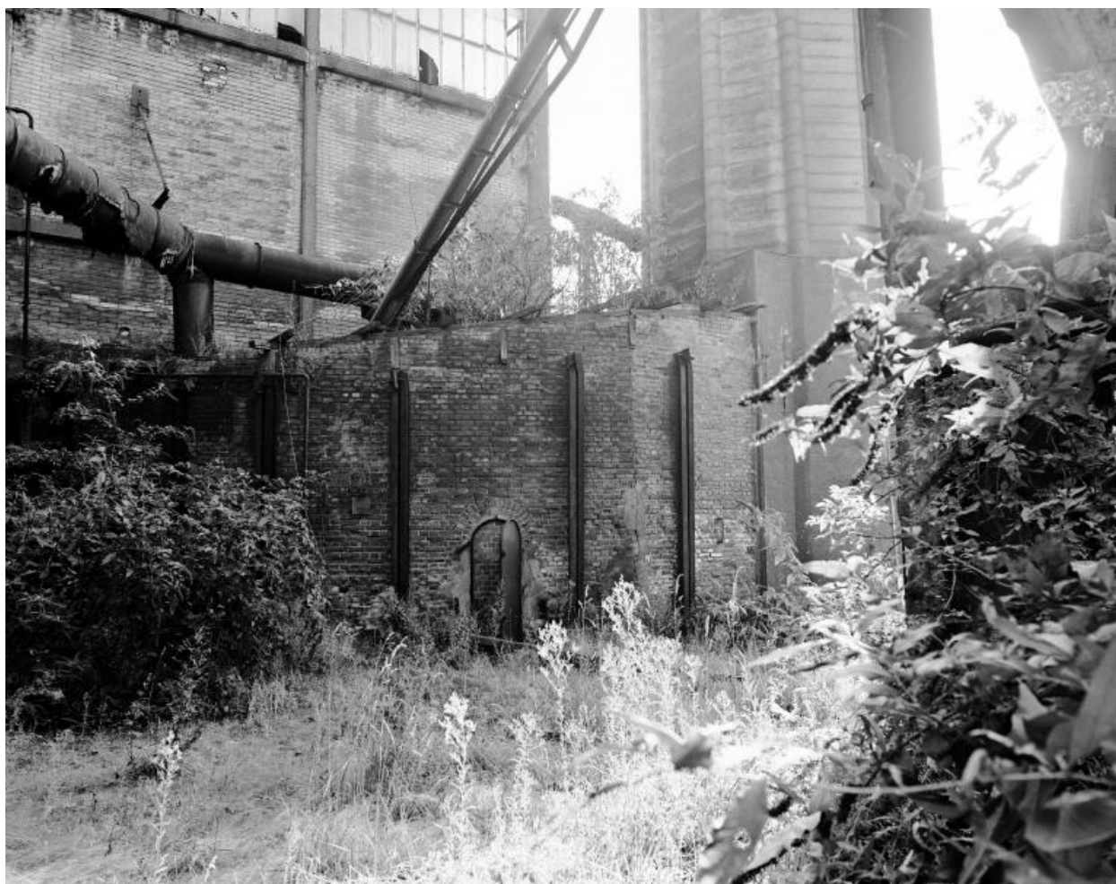
Nouvelle usine. Base de la cheminée industrielle de la chaufferie.
