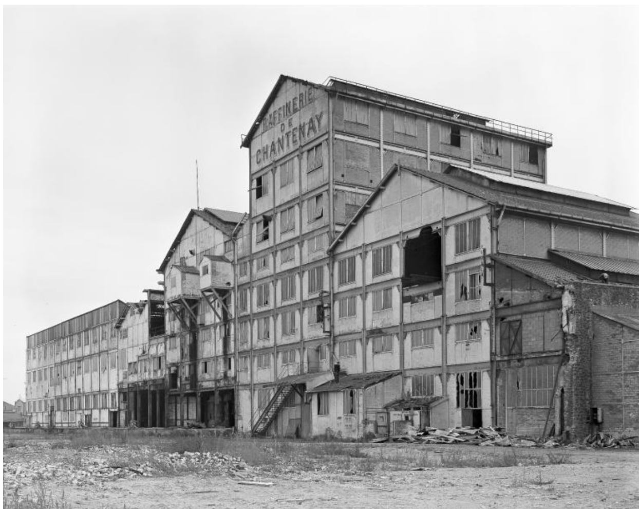
Nouvelle usine. Façades nord vues du nord-ouest.
