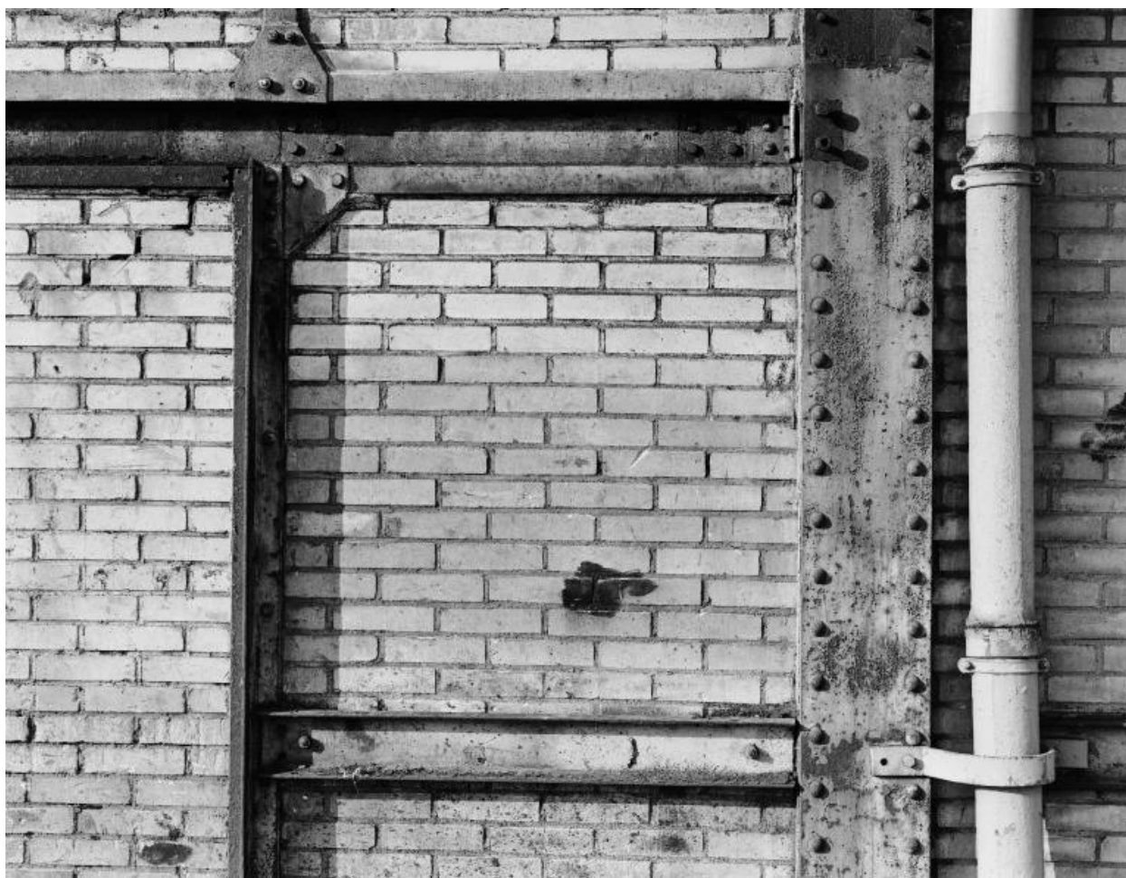
Nouvelle usine. Bâtiment non précisé. Magasin des raffinés, mur nord détail du pan-de-fer.
