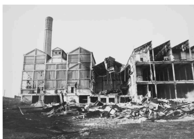
Nouvelle usine. Chaufferie, centrale électrique et casserie partiellement démolies, vues de l'est. Phot. Jacques Le Callonnec IVR52_19784401388X
