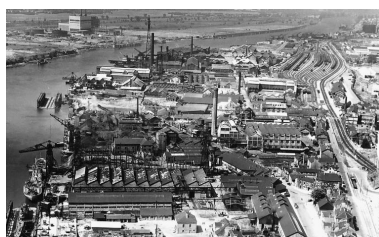
Photographie : vue aérienne de la raffinerie depuis l'est en 1966. Phot. Denis (reproduction) Pillet IVR52_19924400105X
