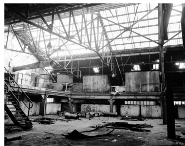
Nouvelle usine. Bâtiment non localisé. Dernier étage. Atelier de cuite avec bacs de stockage des sirops en place. Phot. Jacques Le Callonnec IVR52_19784401381X
