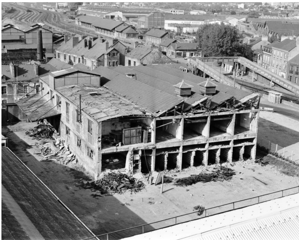
Vestige de la partie ancienne de l'usine. Bâtiment de fabrication du sucre candi et cartonnerie.
