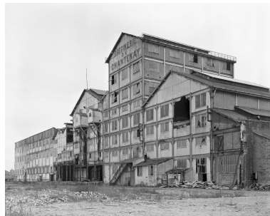
Nouvelle usine. Façades nord vues du nord-ouest. Phot. Jacques Le Callonnec IVR52_19784401365V
