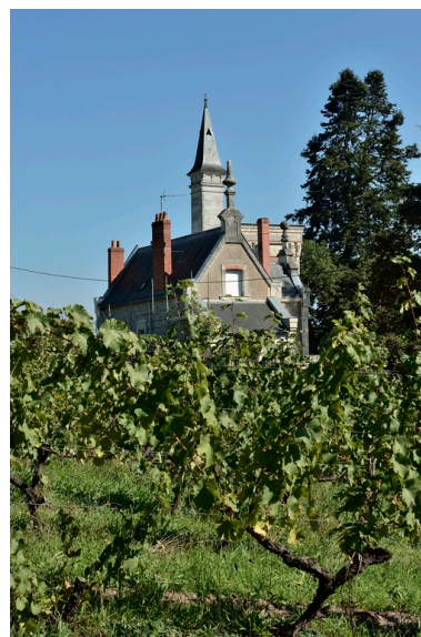
Vue d'ensemble depuis le nord-ouest. Phot. Bruno Rousseau IVR52_20154900504NUCA
