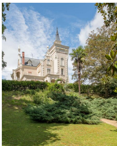
Vue d'ensemble depuis le sud. Phot. Armelle Maugin IVR52_20204900401NUCA
