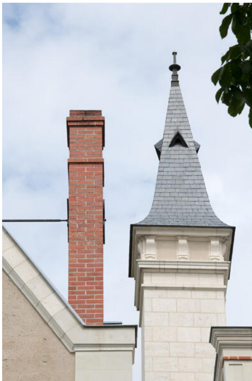
Détail du lanternon surmontant la tour d'escalier.
