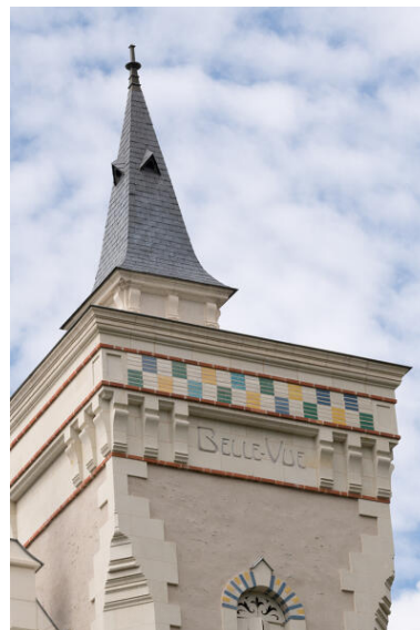
Détails du haut de la tour d'escalier et de l'inscription "Belle-Vue". Phot. Armelle Maugin IVR52_20204900414NUCA
