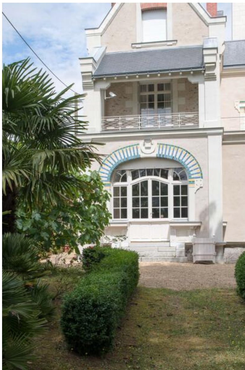
Pignon ouest. Vue de la porte-fenêtre du salon.
