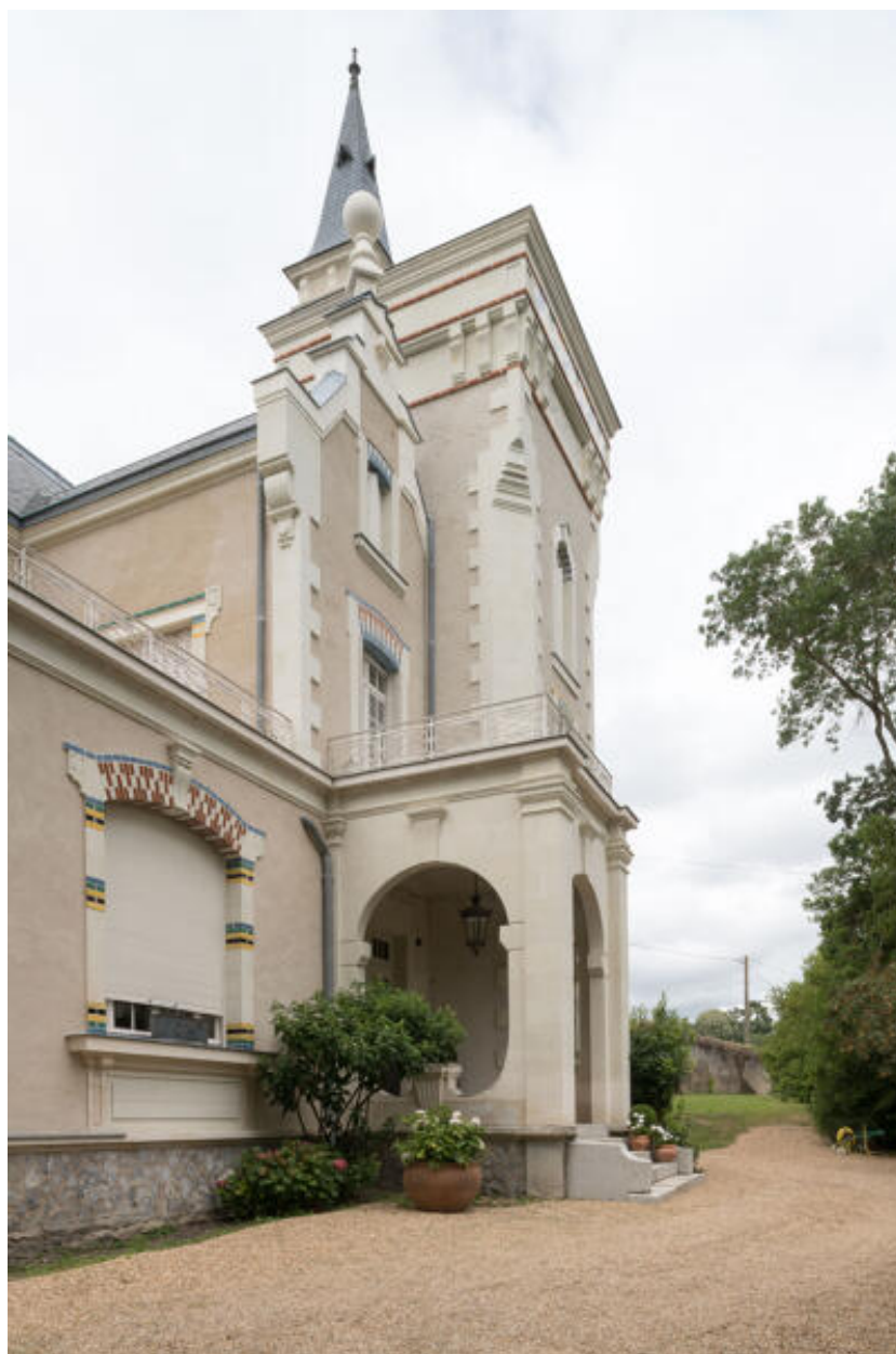
Façade sud. Vue du porche et de la tour d'escalier.
