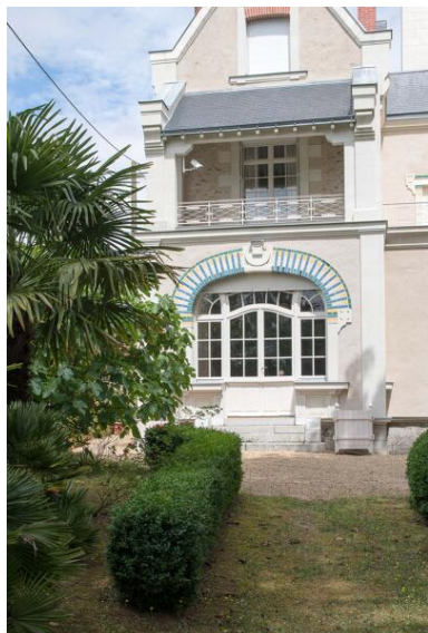
Pignon ouest. Vue de la porte-fenêtre du salon. Phot. Armelle Maugin IVR52_20204900405NUCA
