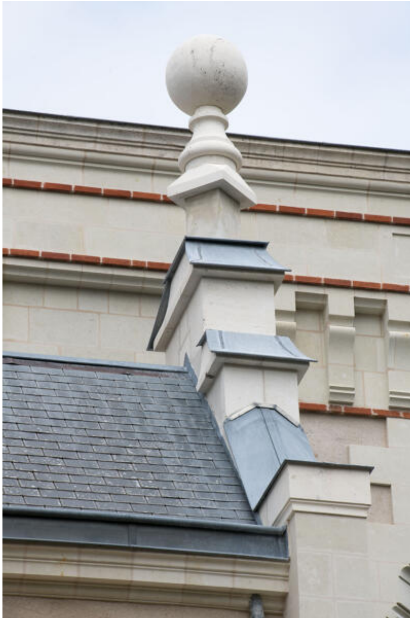
Façade sud. Détail d'un amortissement.
