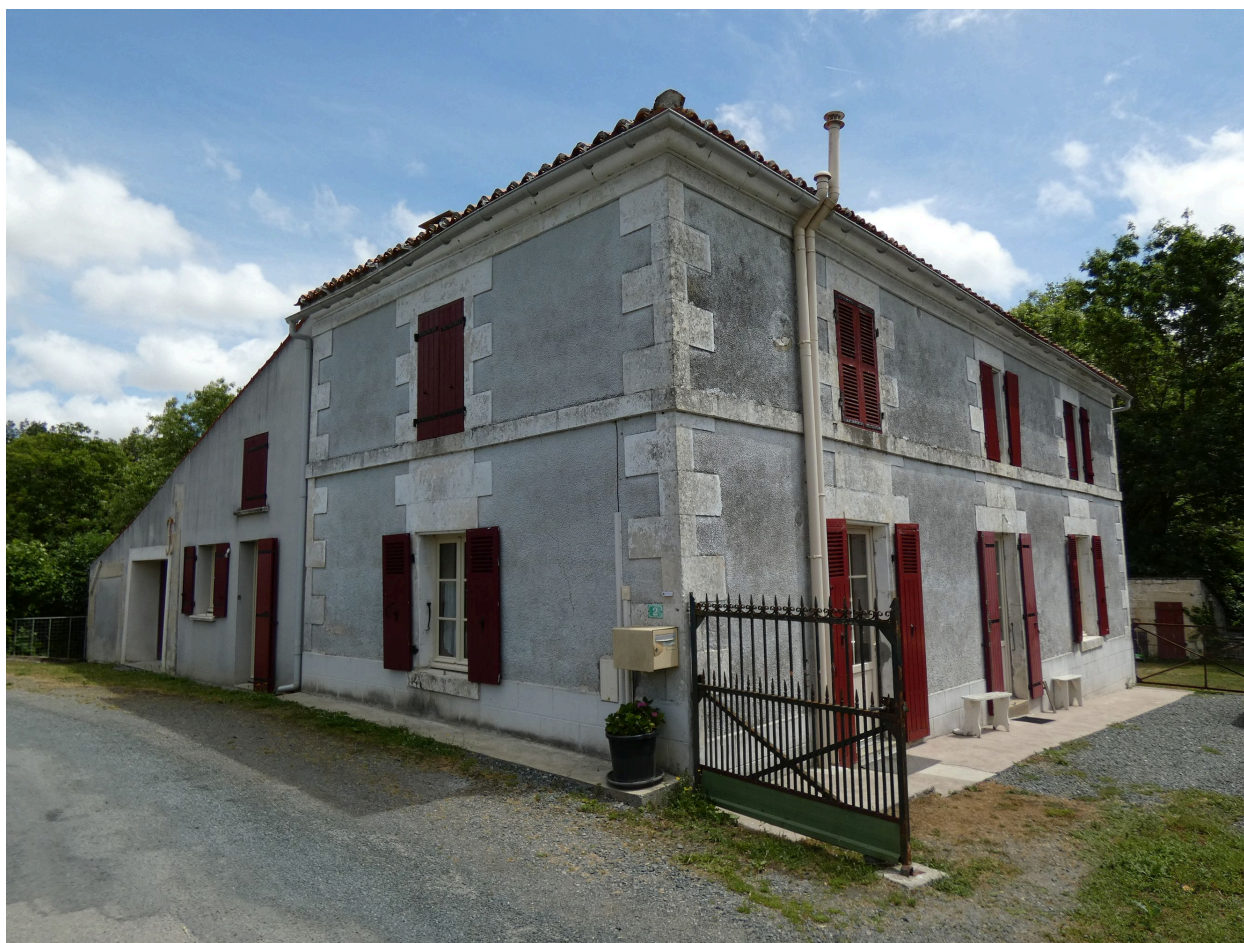
L'ancienne ferme vue depuis l'ouest.
