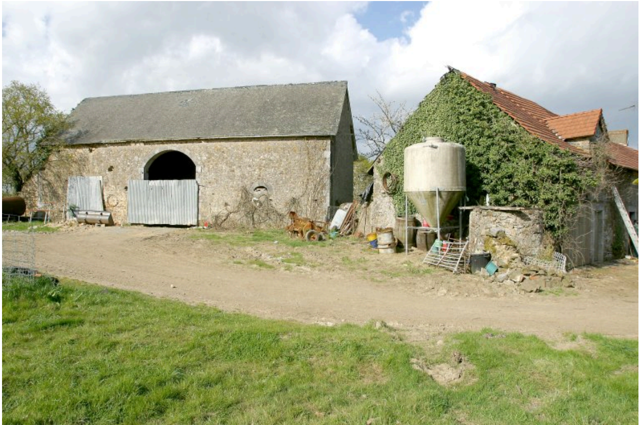
La remise et le pignon du logis vus du sud-ouest.
