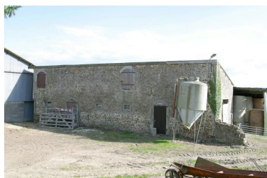
La seconde étable. Phot. François Lasa IVR52_20035301451NUCA
