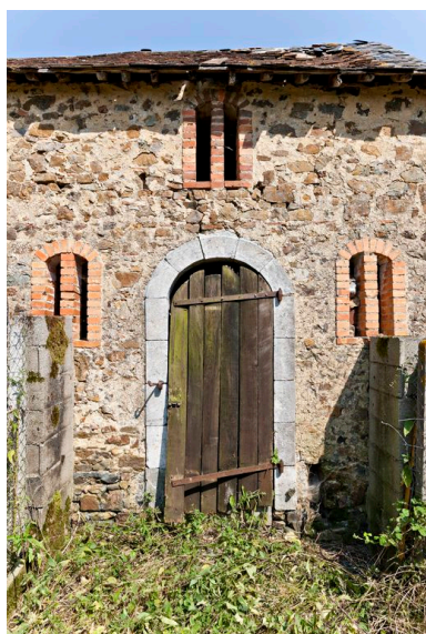
La porcherie. Détail de la façade. Phot. Yves Guillotin IVR52_20135300324NUCA
