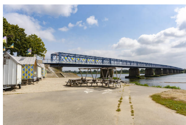
Vue générale de la cale aval. Phot. Pierre-Bernard Fourny IVR52_20214400909NUCA
