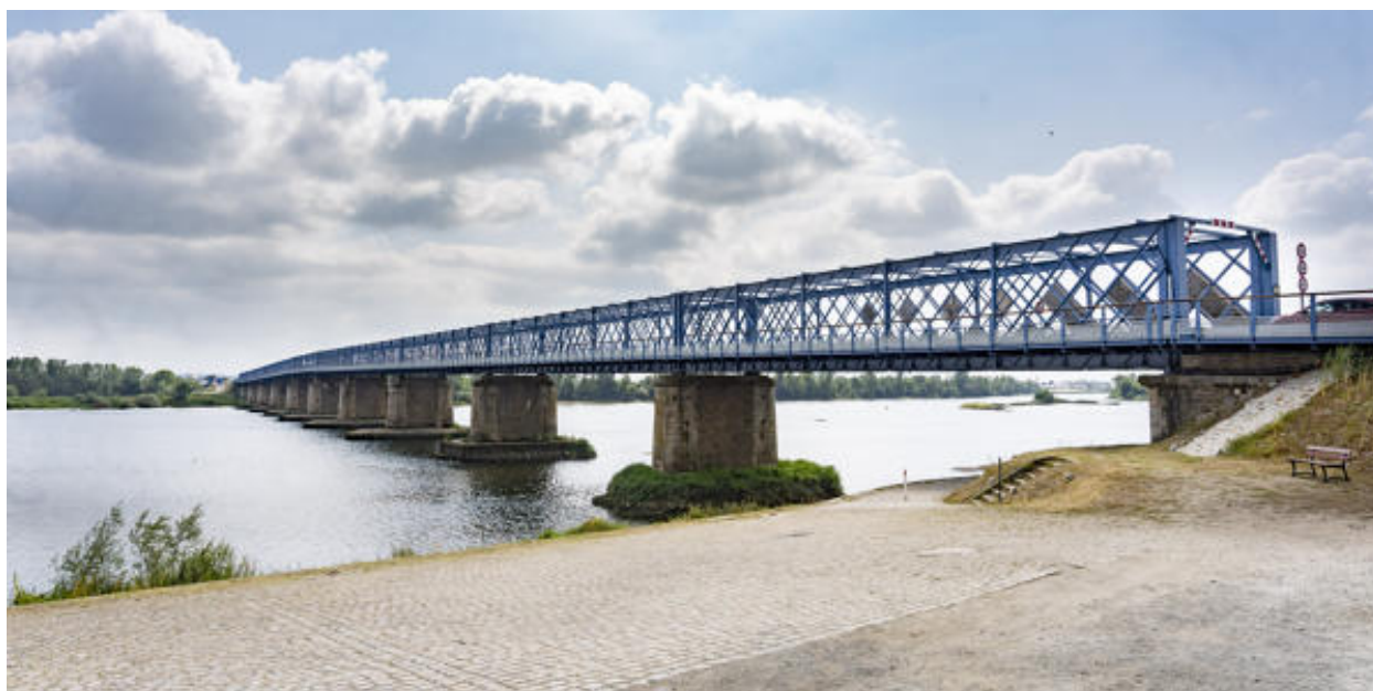
Vue générale de la cale amont.
