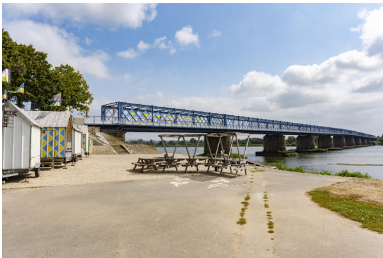
Vue générale de la cale aval.
