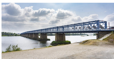
Vue générale de la cale amont. Phot. Pierre-Bernard Fourny IVR52_20214400906NUCA
