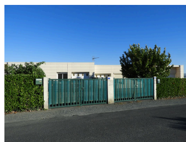
Les logements de fonction au sud-ouest du collège, vus depuis le sud. Phot. Yannis Suire IVR52_20198500231NUCA
