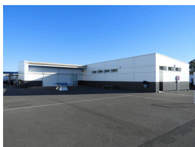
Les salles de cours au sud de la galerie, dont l'ancien préau, à gauche, vus depuis le sud-ouest. Phot. Yannis Suire IVR52_20198500214NUCA
