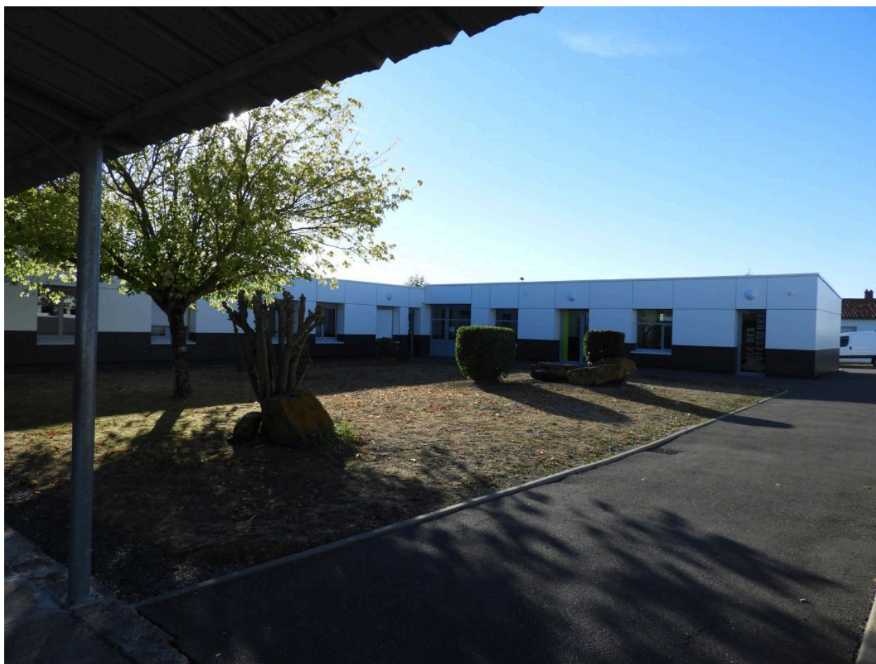
Le bâtiment d'administration, à gauche, et la salle des professeurs, à droite, vus depuis la galerie au nord-ouest.
