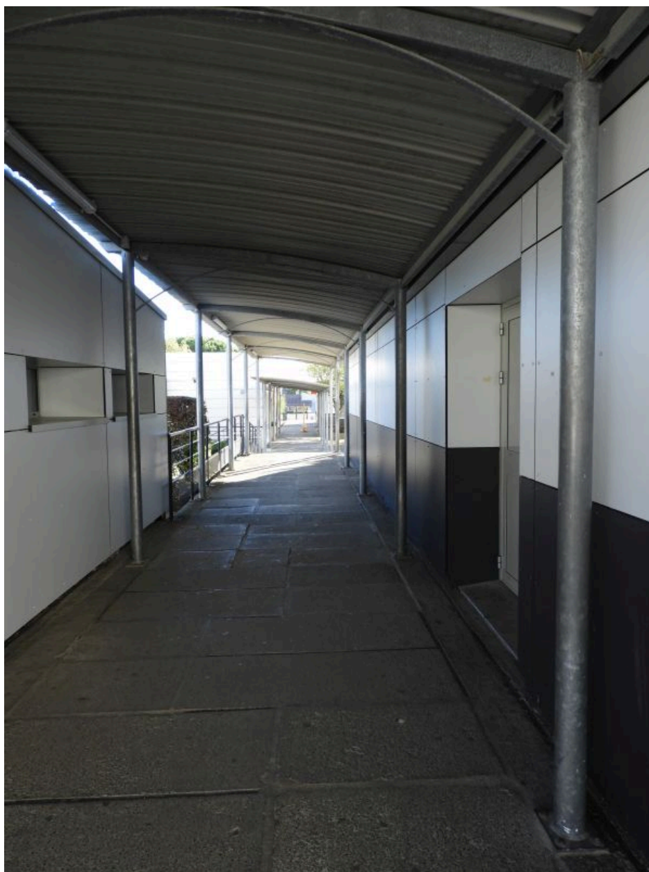
La galerie vue en direction de l'est, entre la salle d'étude à gauche et la salle de cours à droite.
