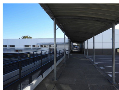
La galerie vue depuis l'ouest au niveau du bâtiment de salles de cours ouest. Phot. Yannis Suire IVR52_20198500216NUCA
