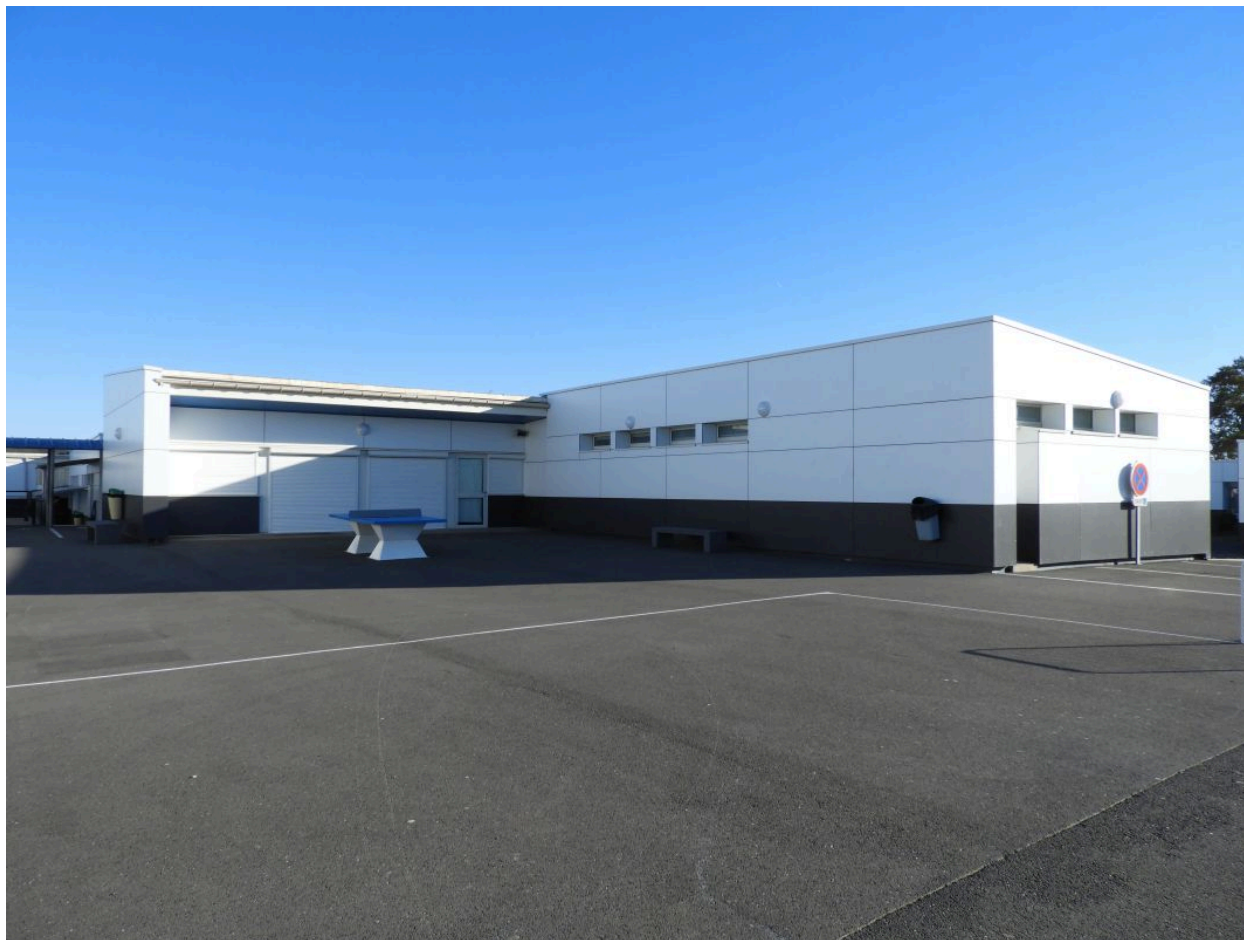
Les salles de cours au sud de la galerie, dont l'ancien préau, à gauche, vus depuis le sud-ouest.
