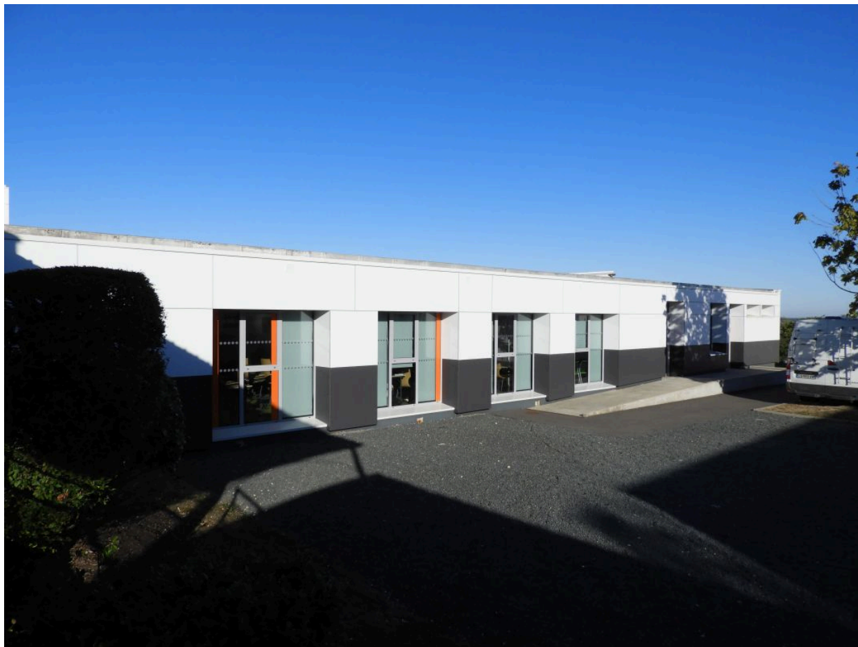
La salle d'étude vue depuis le sud-est.
