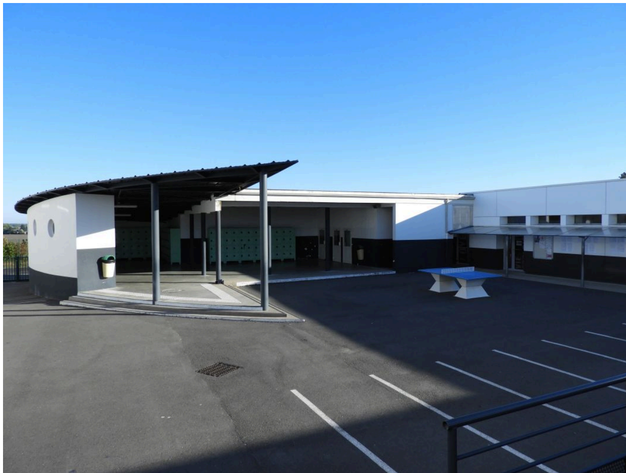
La cour nord vue depuis le sud-ouest.
