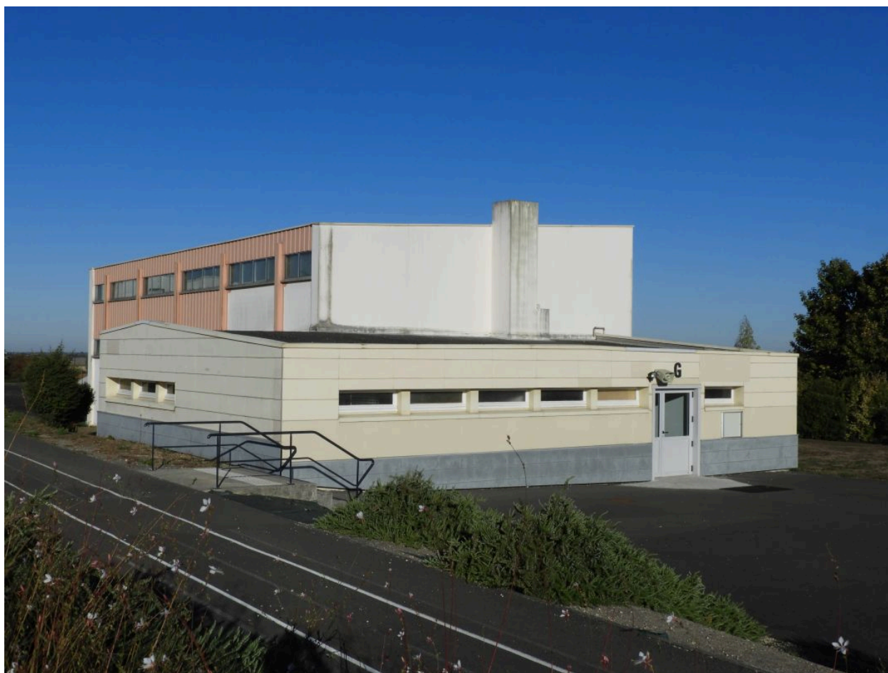
Le gymnase vu depuis le sud-est.
