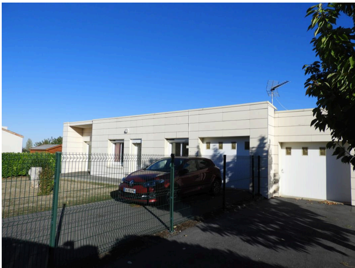
Logements de fonction au sud-ouest : logement ouest, vu depuis le sud-est.
