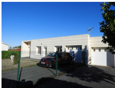
Logements de fonction au sud-ouest : logement ouest, vu depuis le sud-est.
