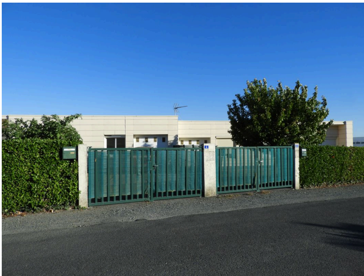
Les logements de fonction au sud-ouest du collège, vus depuis le sud.
