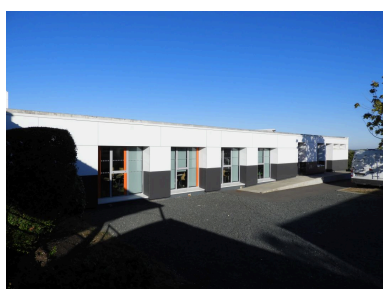
La salle d'étude vue depuis le sud-est. Phot. Yannis Suire IVR52_20198500226NUCA
