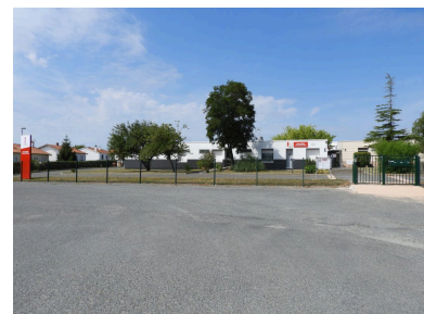
Le collège vu depuis l'est. Au premier plan, le bâtiment d'accueil et d'administration. Phot. Yannis Suire IVR52_20188501373NUCA
