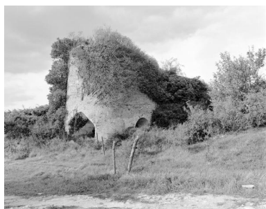
Le four et la rampe, vue d'ensemble depuis le sud-est, four du Grand Lièvre, Montjean-sur-Loire Phot. Bruno Rousseau IVR52_19854901744X
