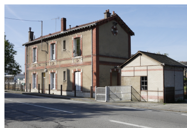
Logement de fonction, côté rue. Phot. Denis Pillet IVR52_20104402512NUCA
