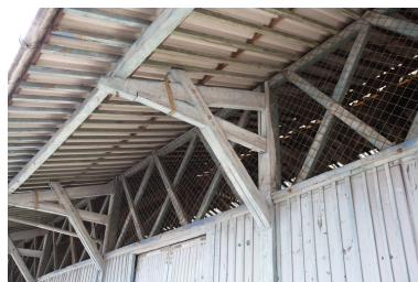
Halle de marchandises : détail de la charpente. Phot. Denis Pillet IVR52_20104402517NUCA
