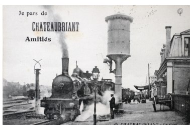
Réservoir d'eau, fin du XIXe siècle. Phot. Denis Pillet IVR52_20104402337NUCA
