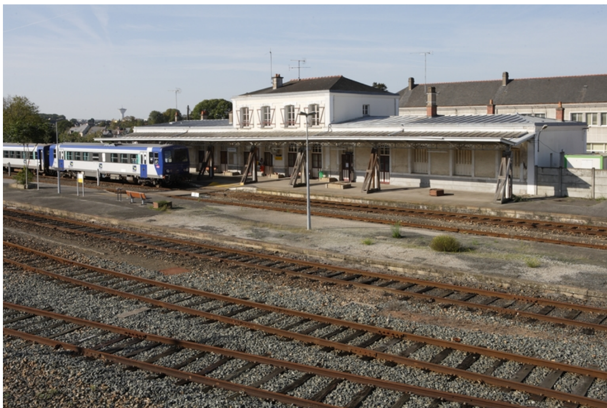
Gare de Châteaubriant, côté quais.
