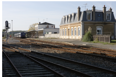
Voies en direction de Nantes. Phot. Denis Pillet IVR52_20104402507NUCA
