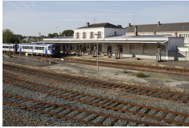
Gare de Châteaubriant, côté quais. Phot. Denis Pillet IVR52_20104402513NUCA
