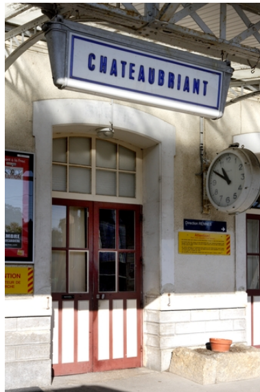
Porte d'accès aux quais. Phot. Denis Pillet IVR52_20104402502NUCA
