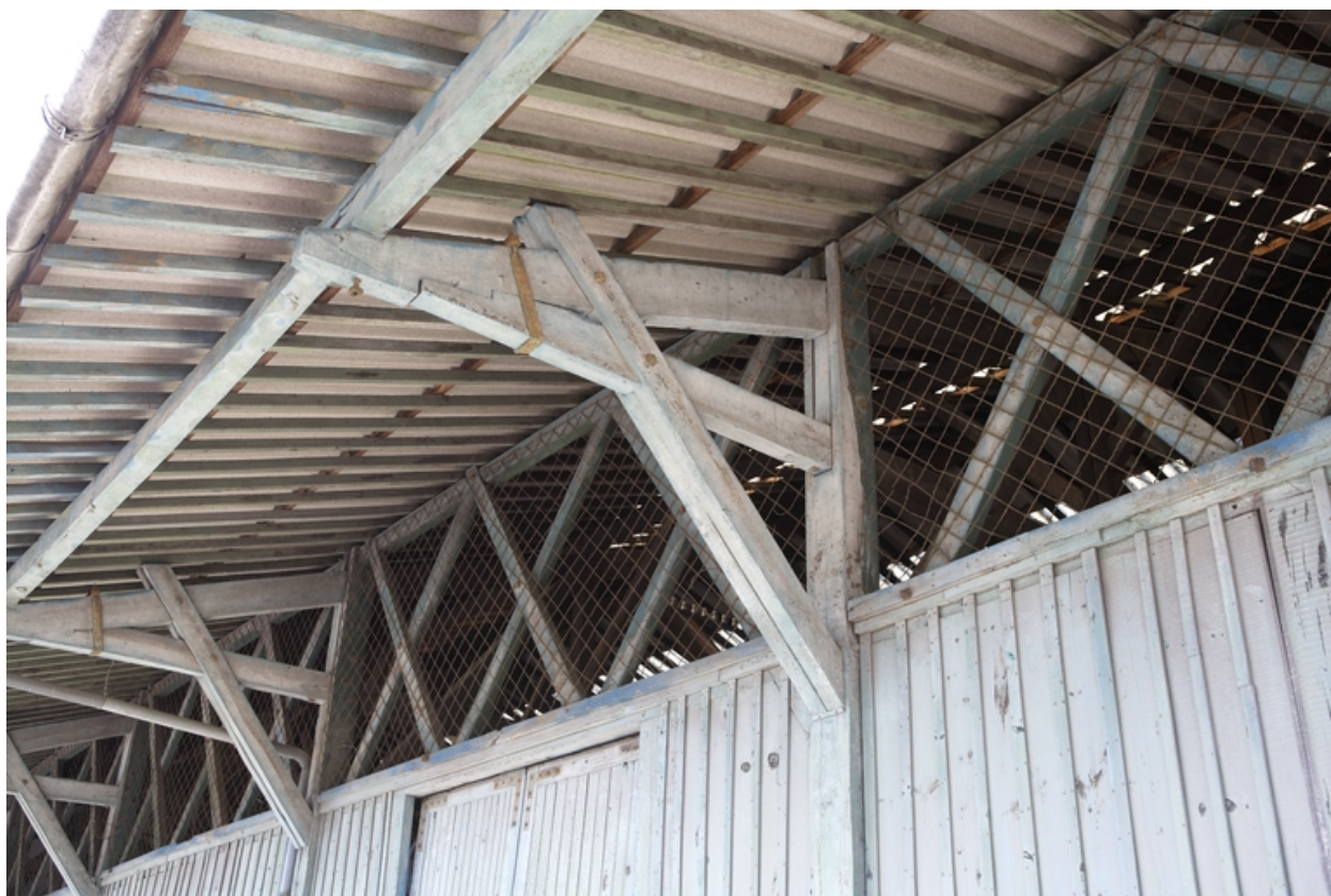
Halle de marchandises : détail de la charpente.
