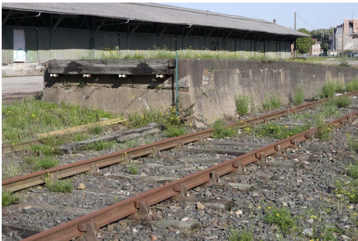
Quai de chargement.
