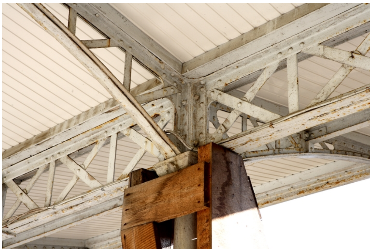
Détail de la charpente métallique de la marquise.
