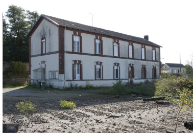
Logement pour les conducteurs et les contrôleurs. Phot. Denis Pillet IVR52_20104402519NUCA
