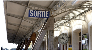
Marquise protégeant le quai principal. Phot. Denis Pillet IVR52_20104402501NUCA
