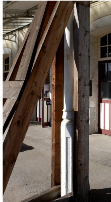
Poteau-gouttière soutenant la marquise. Phot. Denis Pillet IVR52_20104402499NUCA
