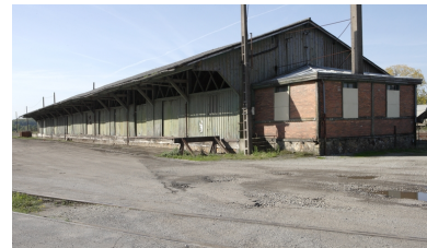
Halle de marchandises. Phot. Denis Pillet IVR52_20104402515NUCA
