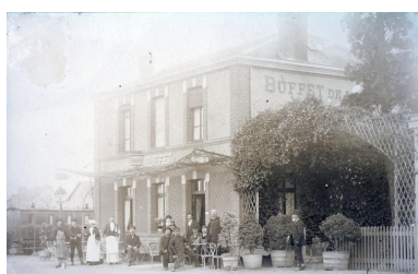
Hôtel de la gare, fin du XIXe siècle. Phot. Denis Pillet IVR52_20104402332NUCA
