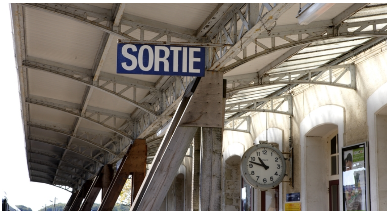
Marquise protégeant le quai principal.
