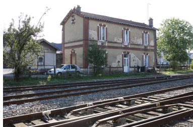
Logement de fonction, côté quai. Phot. Denis Pillet IVR52_20104402509NUCA
