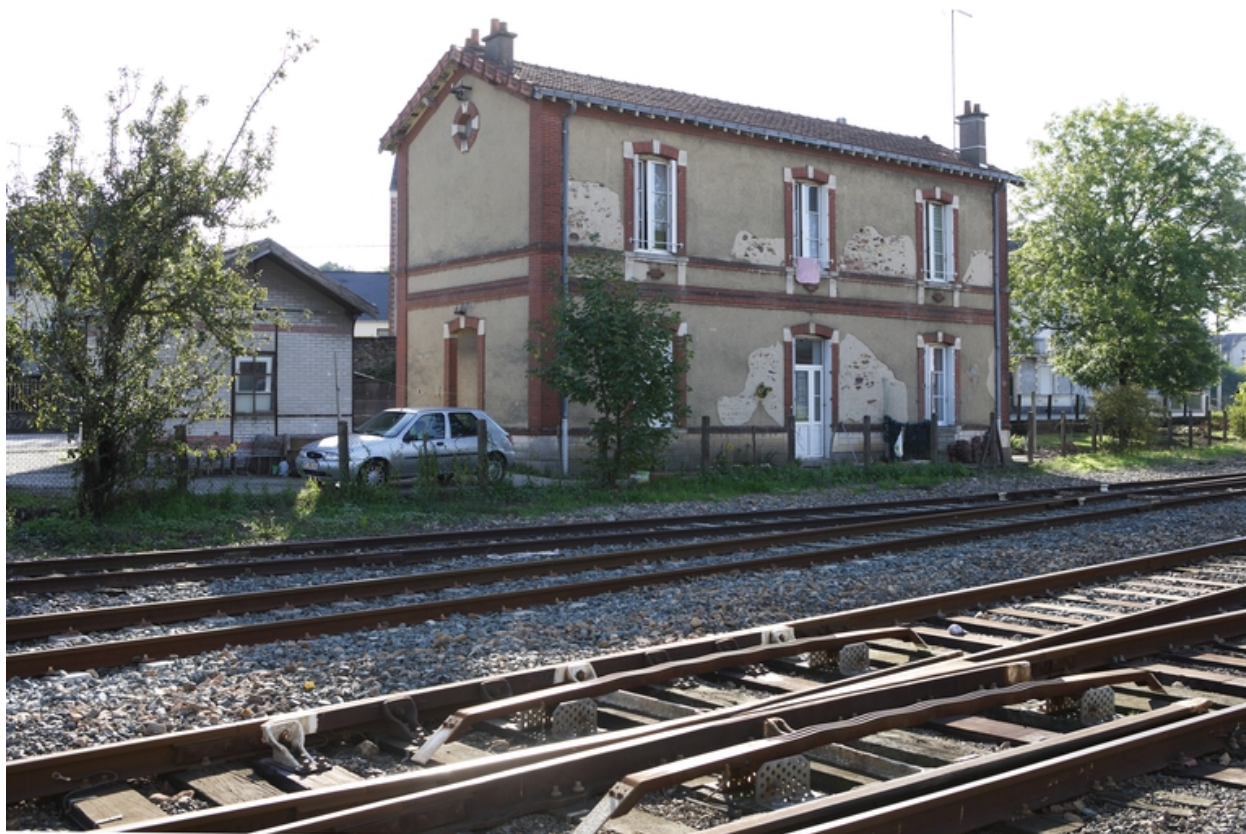
Logement de fonction, côté quai.
