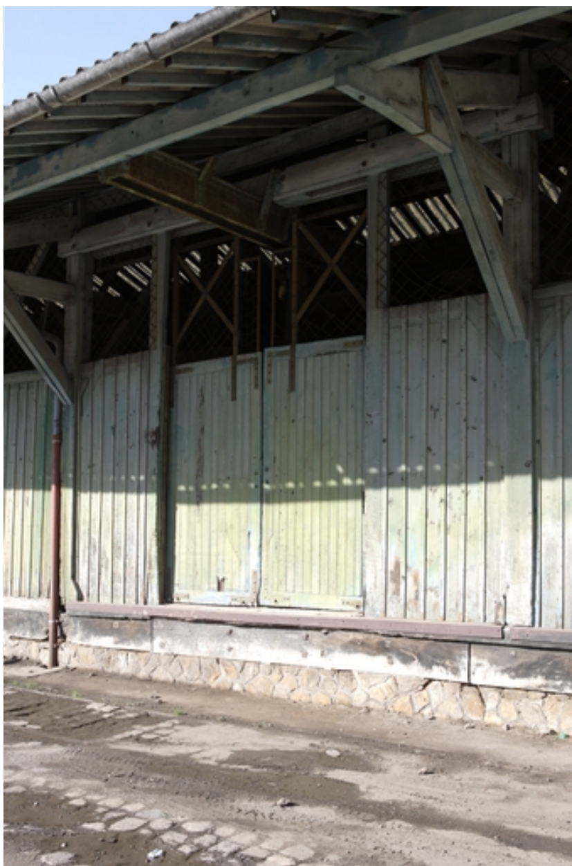
Halle de marchandises : porte de chargement.
