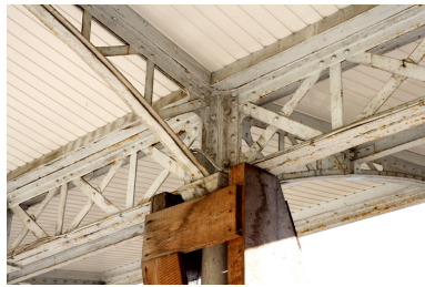
Détail de la charpente métallique de la marquise. Phot. Denis Pillet IVR52_20104402498NUCA
