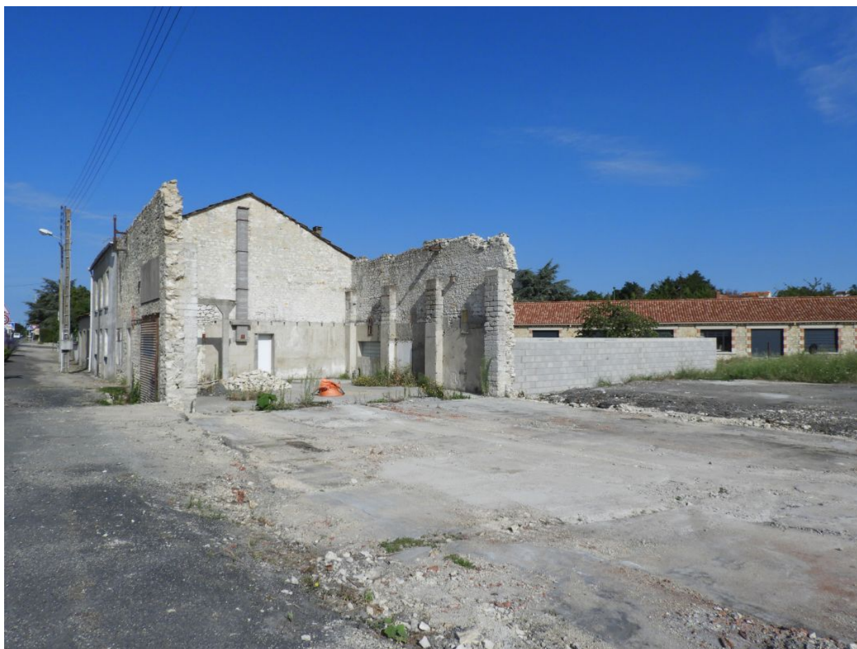
Les vestiges de l'usine vus depuis l'est.
