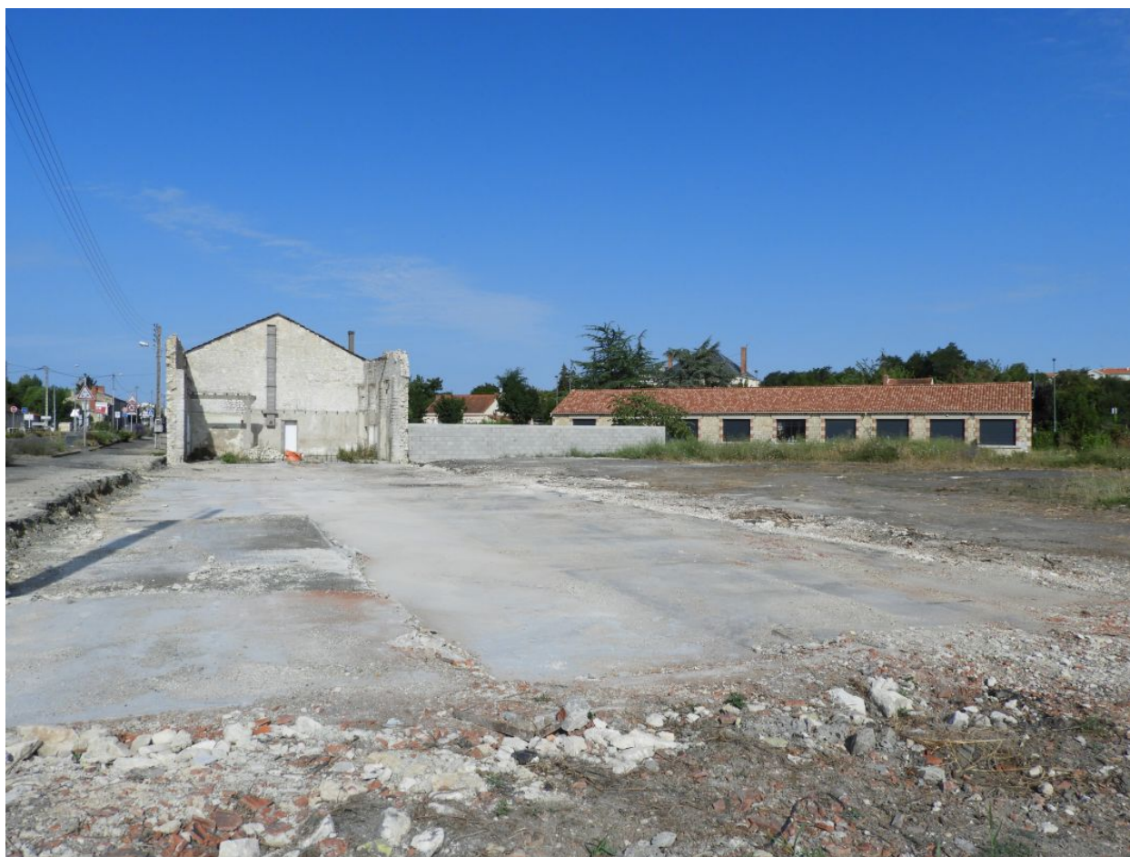
Les vestiges de l'usine vus depuis l'est.
