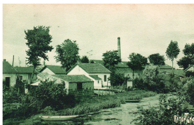
L'usine, à l'arrière-plan, vue depuis le sud vers 1930. Phot. Yannis (reproduction) Suire IVR52_20198501078NUCA
